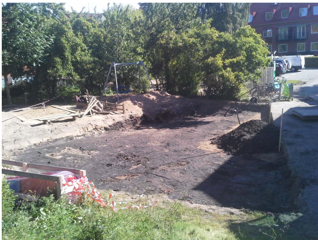
Figur 3. Vy över den redan schaktade ytan, i rapporten kallad Schakt 1, då Kulturen fick information om markingreppet. Fotografiet taget från väster.
