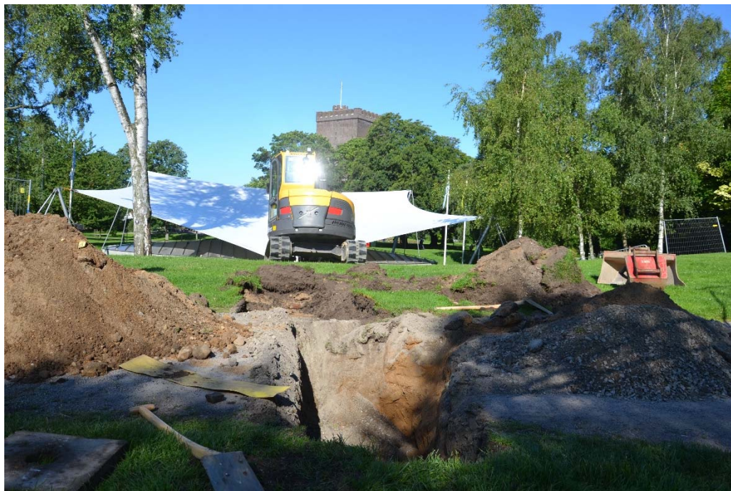
Figur 5. Schakt 1, med grävmaskinen på väg för att påbörja schakt 2. Fotografi från öster.
