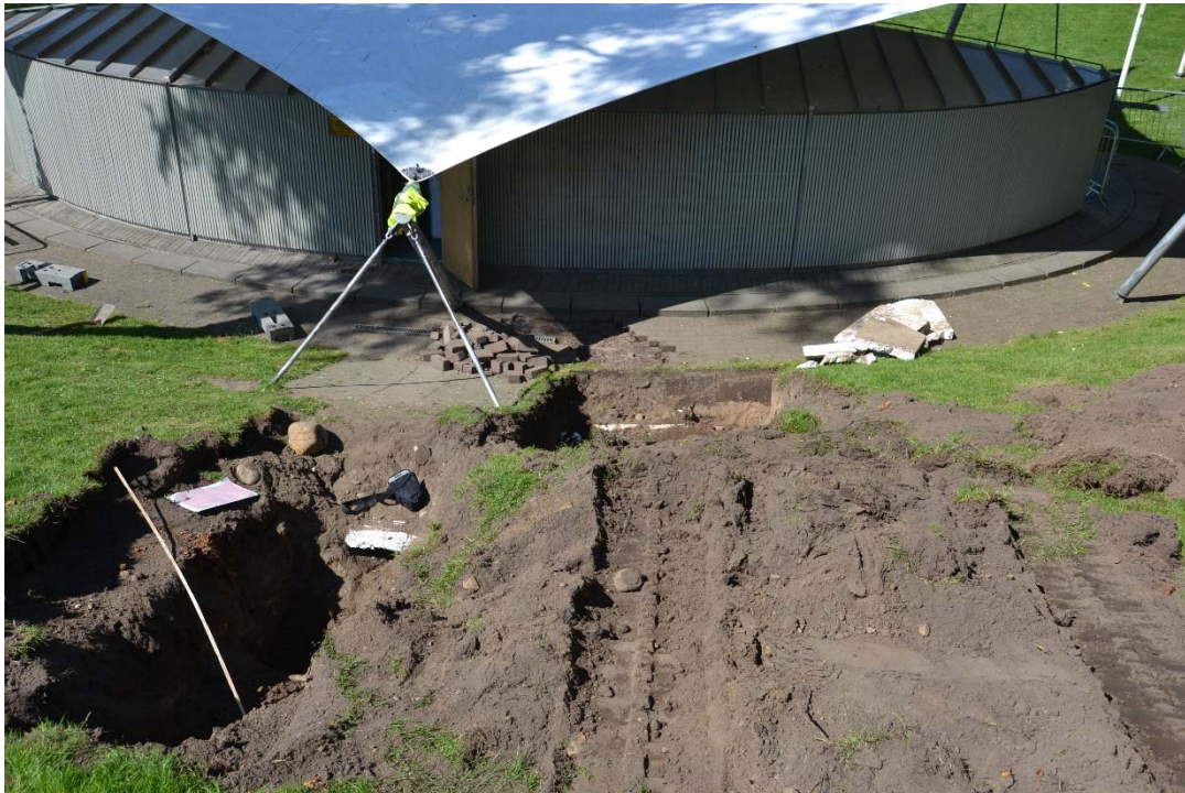
Figur 4. Schakt 2 och 3, under dokumentation. Fotografi från öster.
