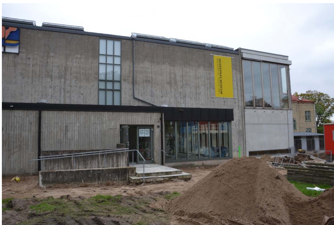
Figur 3. Schaktningsarbeten vid Skissernas museum. Fotografiet taget från väster.
