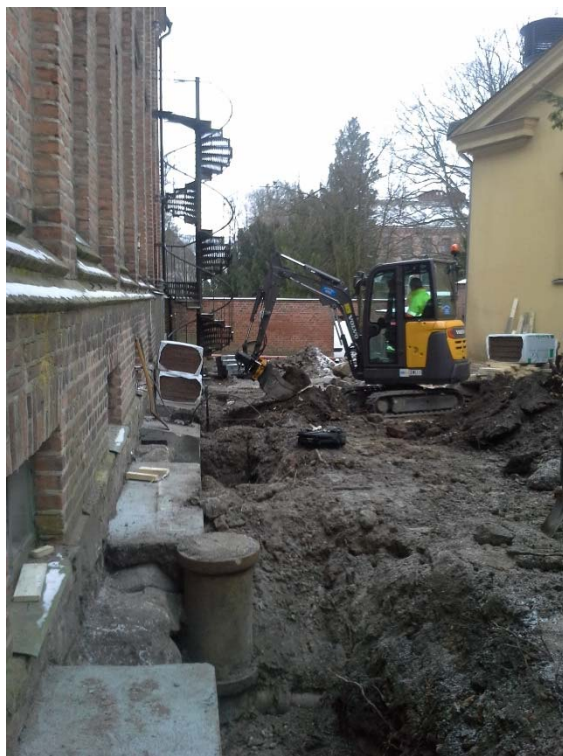
Figur 3. Bilden visar schakt längs med husgrunden i väster, samt tidigare grävda schakt där betong redan gjutits. Fotografiet är taget från norr.
