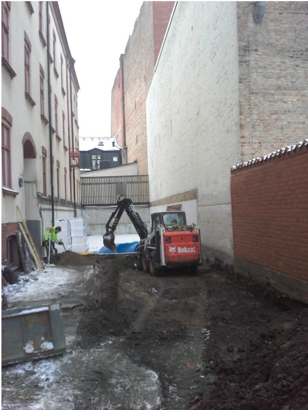
Figur 7. Det trånga utrymmet mellan fastigheterna blir påtagligt vid schaktning. Fotografiet taget från Norr.
