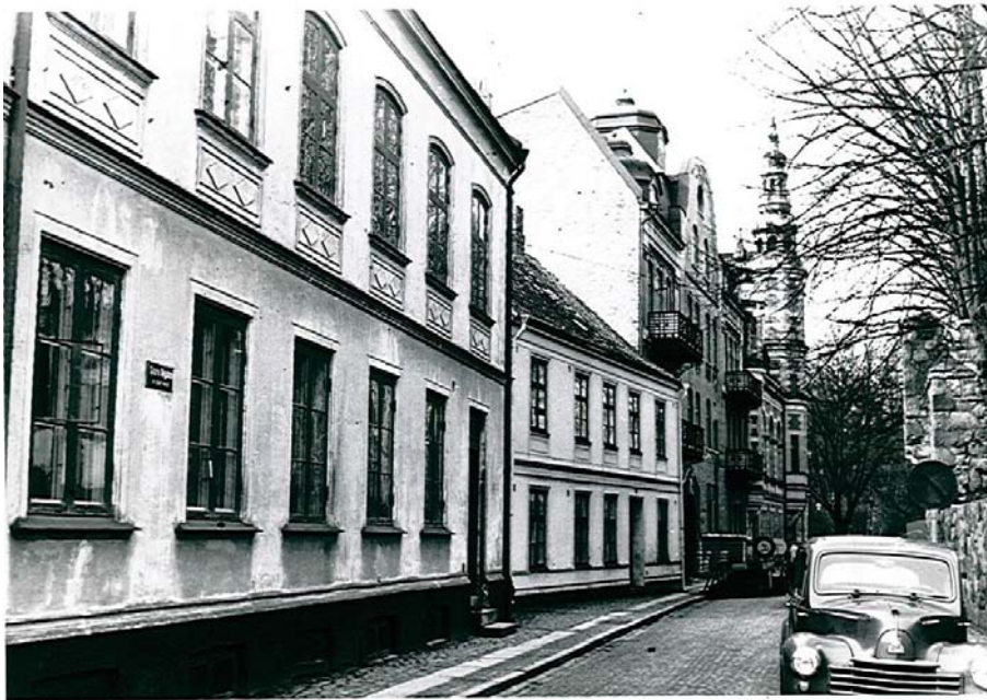
Figur 4. Fastigheten i mitten ut mot Stora Algatan före rivning år 1959. Kulturens LB-arkiv D 1959:2.
