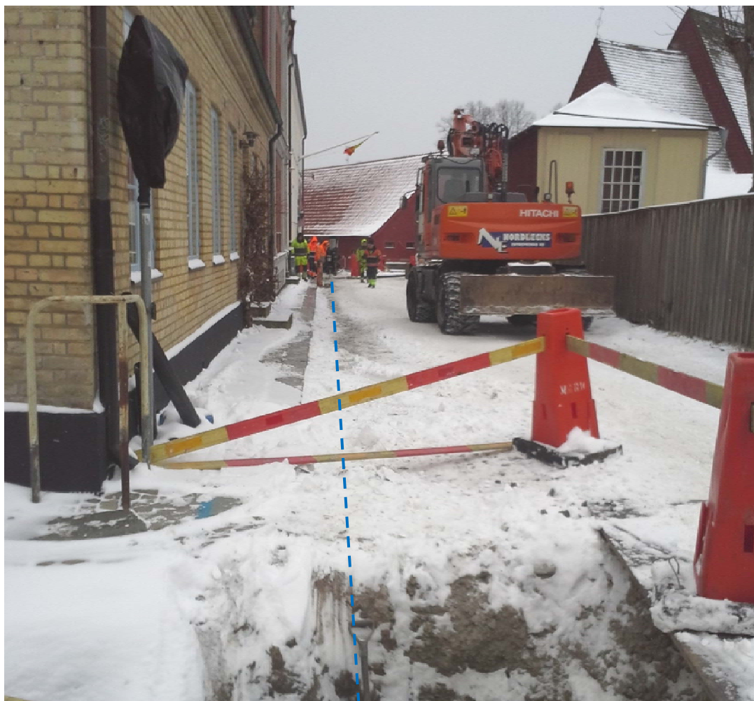
Figur 21. Påträffade hinder längs med den blåa linjen på en nivå av 2,30 – 2,50 m djup då styrd borrrning genomfördes på Adelgatan 4/Östgöta Nation - Lilla Tomegatan. Troligen indikerar det att bebyggelse tidigare funnits längre västerut och att Adelgatan varit smalare. Fotografi taget från norr.
