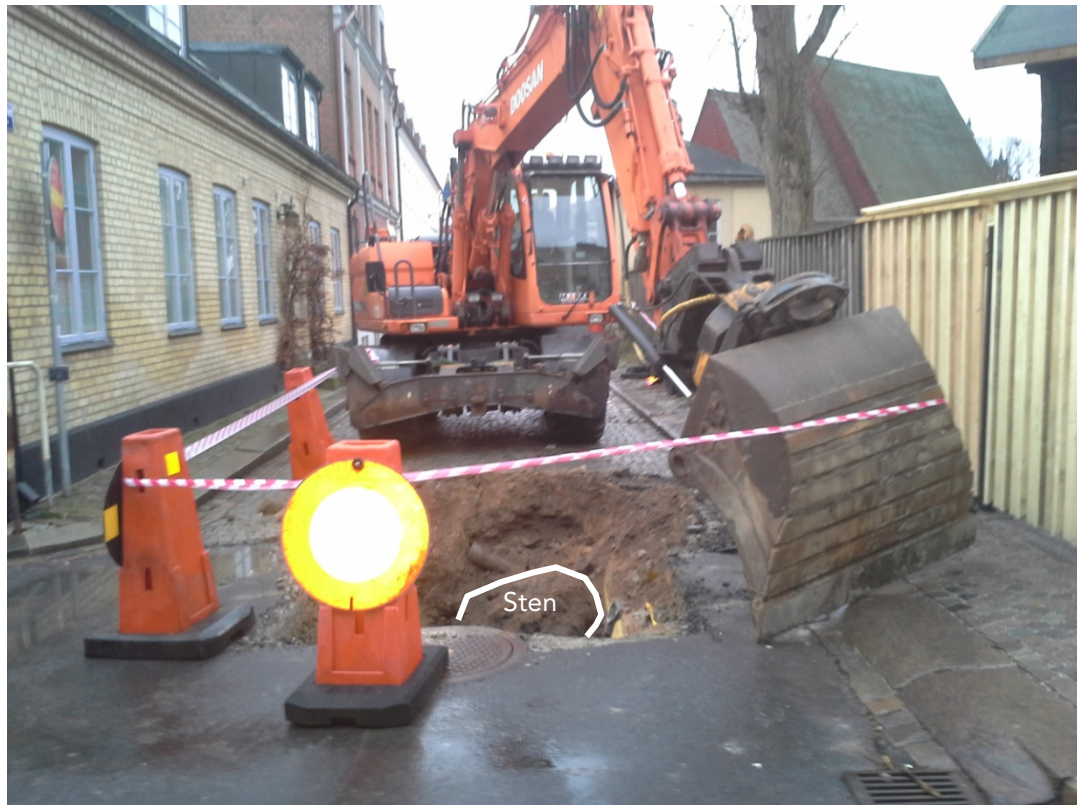
Figur 24. Kompletterande arbete i januari 2015 för att koppla på en brunn på Adelgatan/Lilla Tomegatan. En stor syllsten cirka 2,60 m ut i gatan indikerar att gatan varit betydligt smalare. Stenen är markerad med en svart linje. Fotografi taget från norr.
