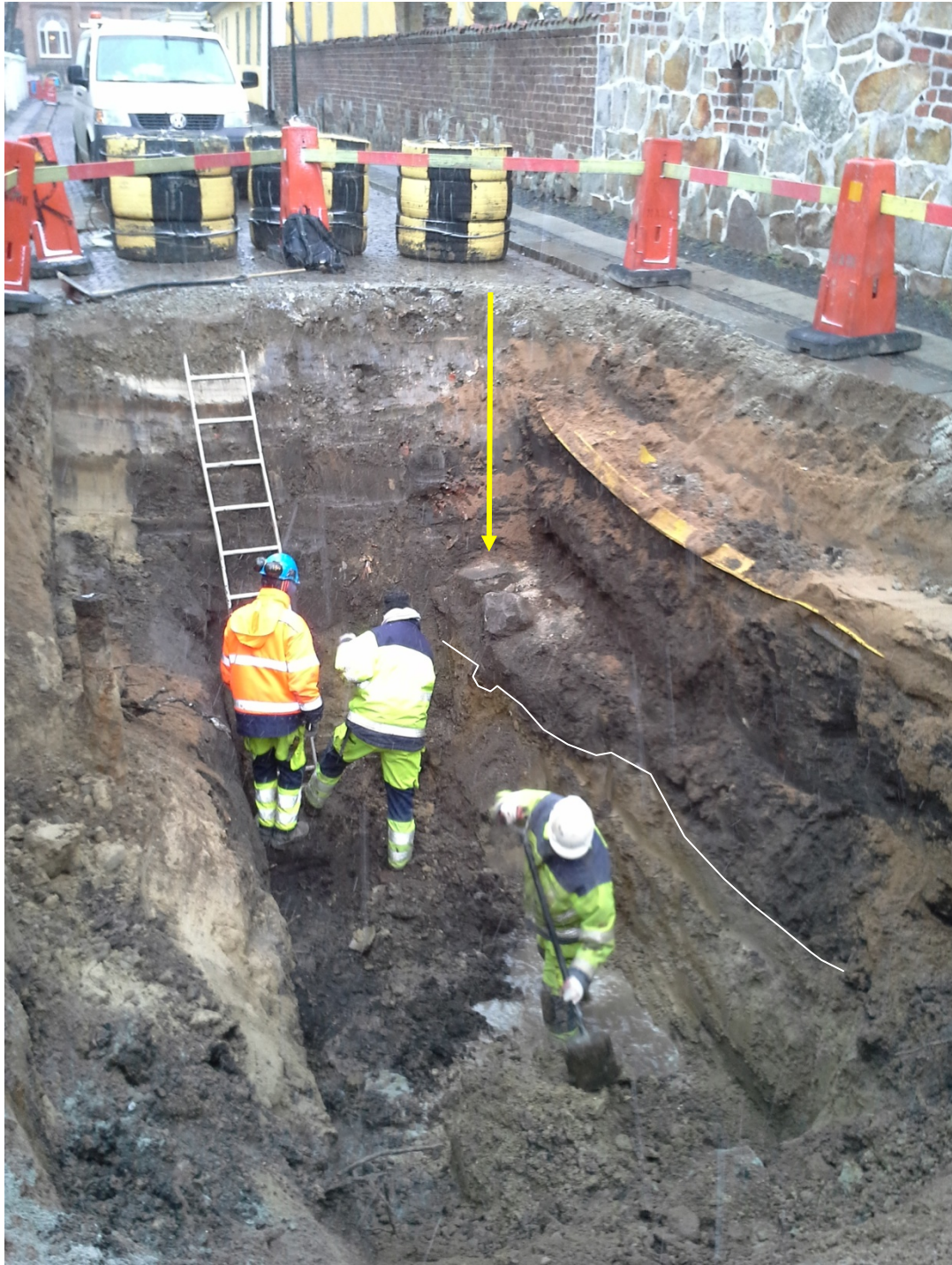
Figur 15. Schakt 3 med husgrunden i norra sektionen, se pil. Nivån på moränen markerad med vit linje. Husgrunden tyder på att gatan varit smalare (bilaga 2). Fotografi taget mot nordväst.
