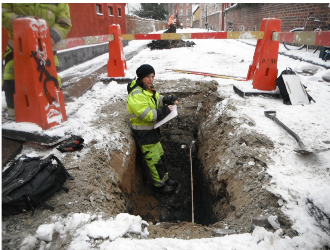
Figur 18. Dokumentation av en stenläggning i området vid Adelgatan 4. Medeltidens Adelgata löpte troligen längre norrut än den påträffade stenläggningen. Schaktet förlängdes efter att fotografiet togs.
