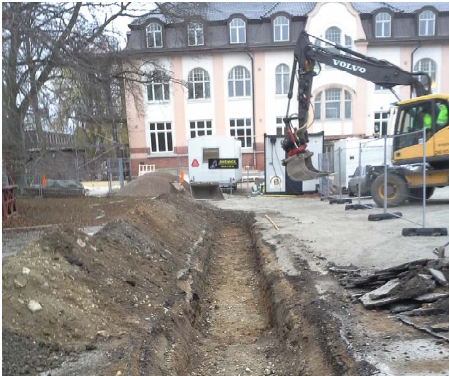
Figur 4. Pågående arbete med schakt 2. Till vänster i bild skymtar några av träderna med mycket högt skyddsvärde. Till höger syns avstängningen som flyttats för att åter kunna göra parkeringsplatser tillgängliga i julhandeln.
