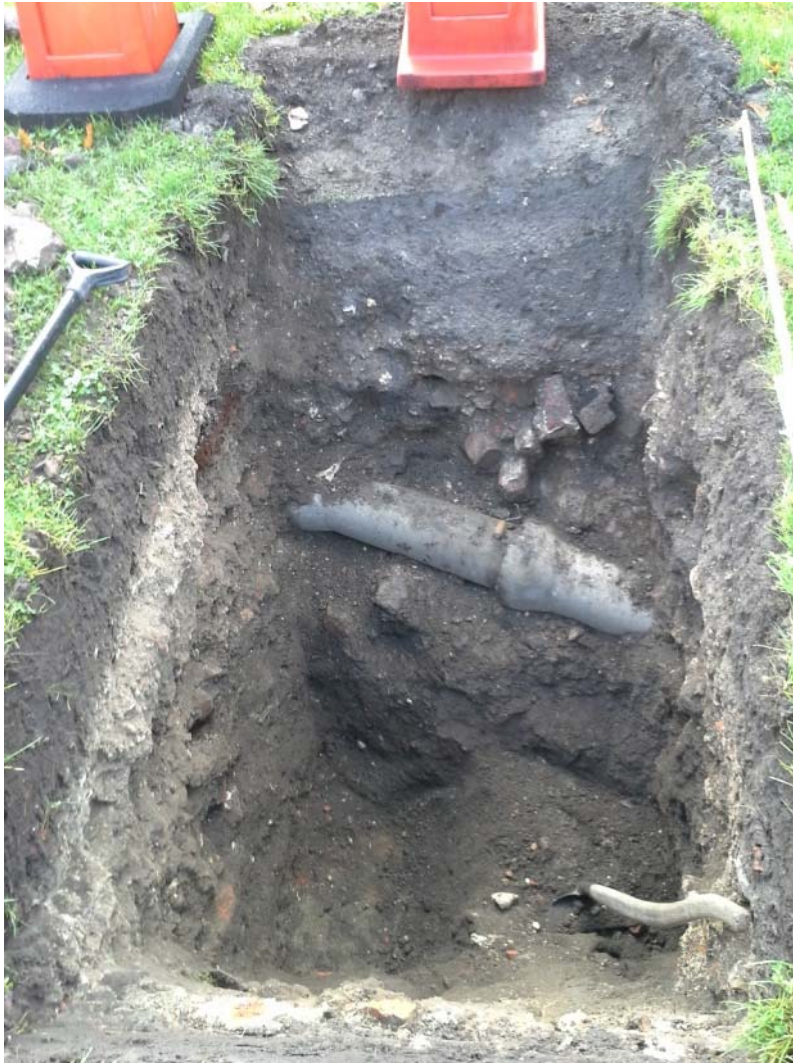
Figur 13. Schakt 4 från väster, med det påträffades betongröret i den östra sidan.
