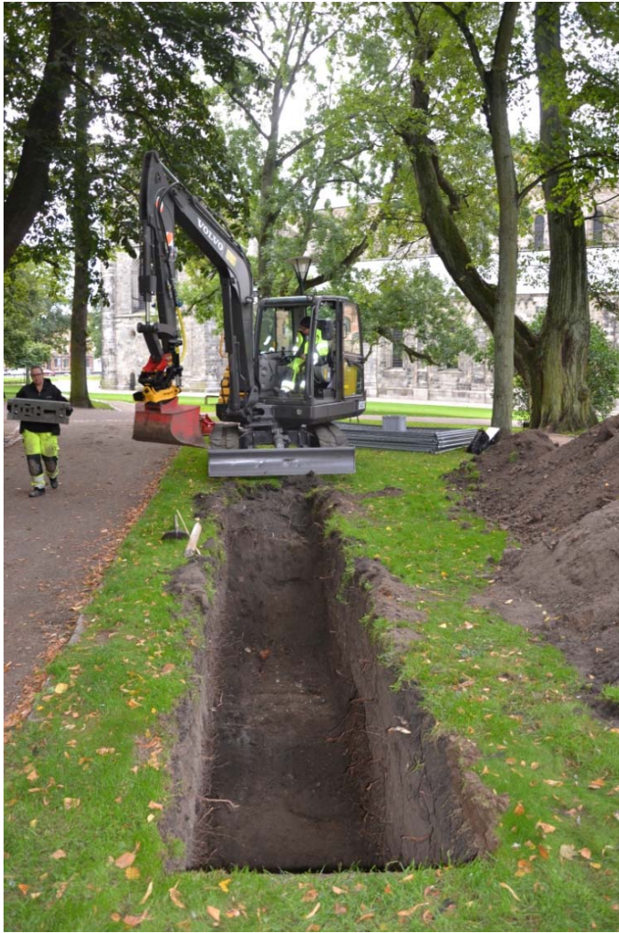
Figur 14. Paus i grävandet av schakt 5, med uppsättning av stängsel. Fotografi från norr.
