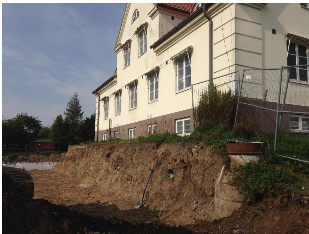
Figur 7. Den norra sidan färdigschaktad. Fotografi från öster.
