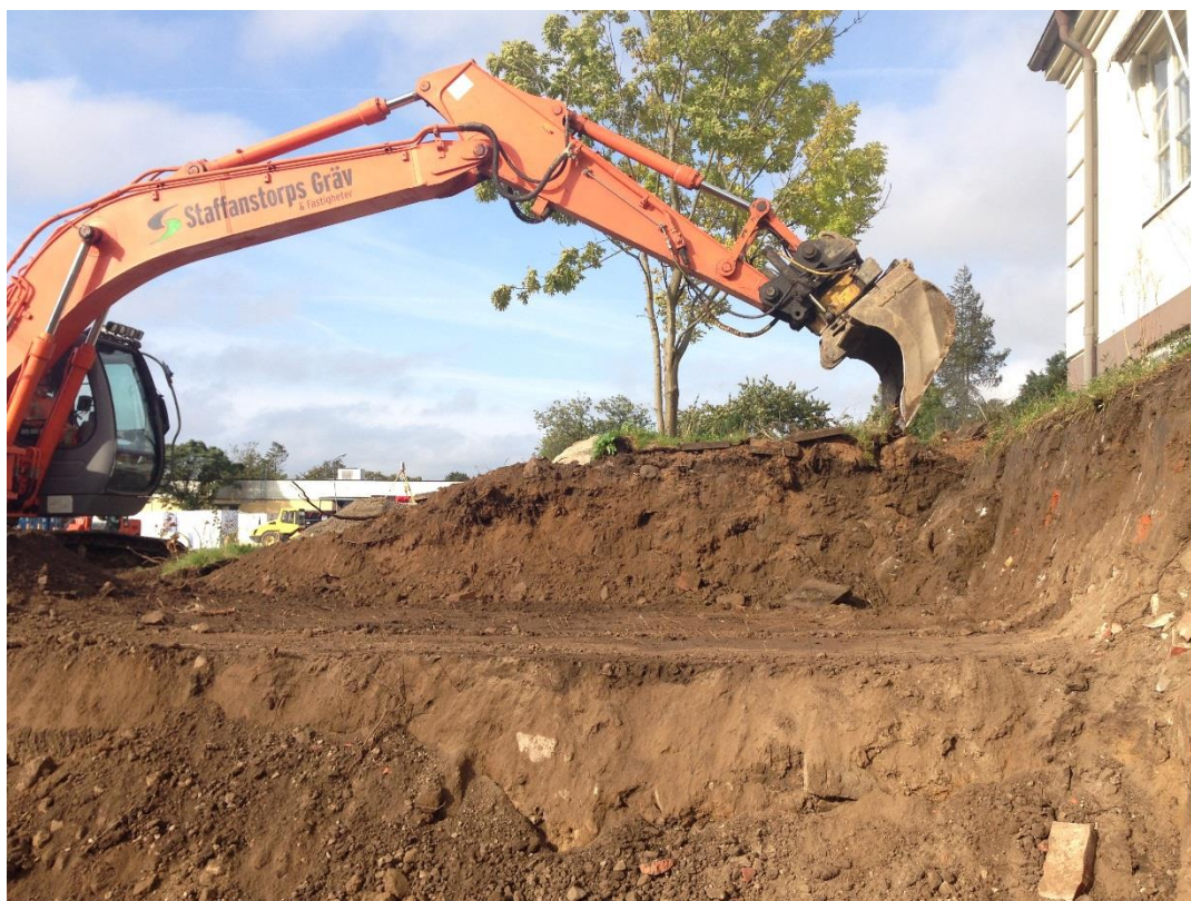
Figur 6. Schaktning av den norra kanten för L-stöd. Fotografi från öster.
