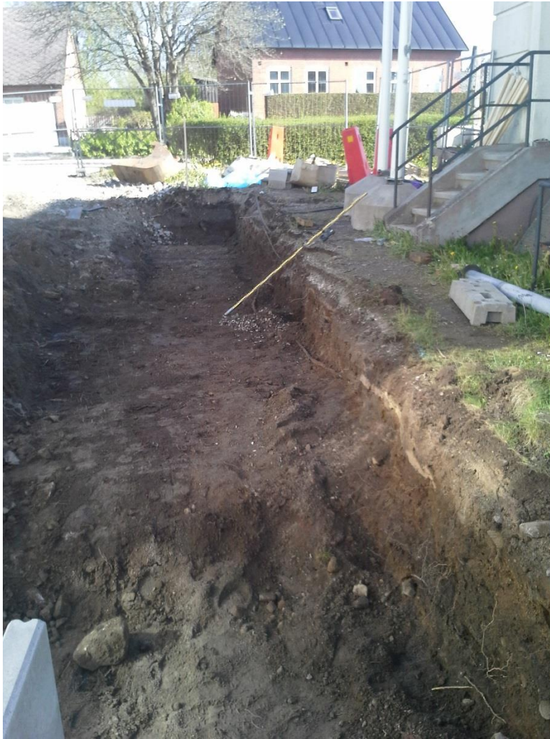
Figur 8. Den sista delen, som schaktades i maj 2015, från söder.
