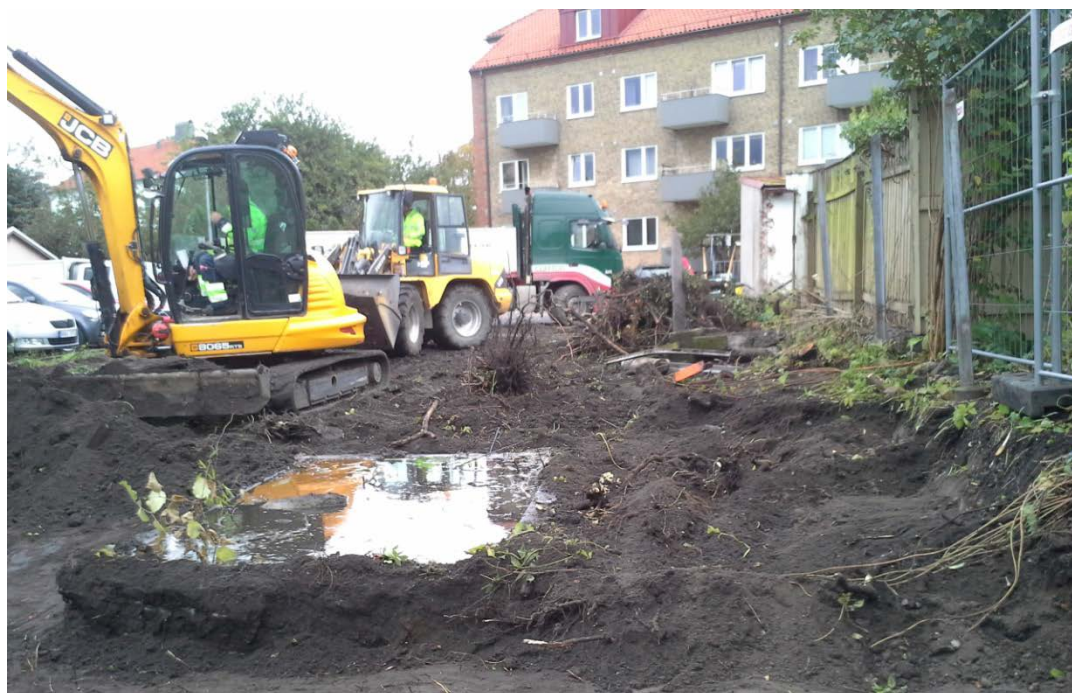
Figur 4. Mellan näckrosdammen och staketet schaktades ett långt rörschakt där en sektionsritning kunde uppföras. Rörschaktet är ännu ej schaktat på bilden. Fotografiet taget från söder mot Lilla Östergatan.
