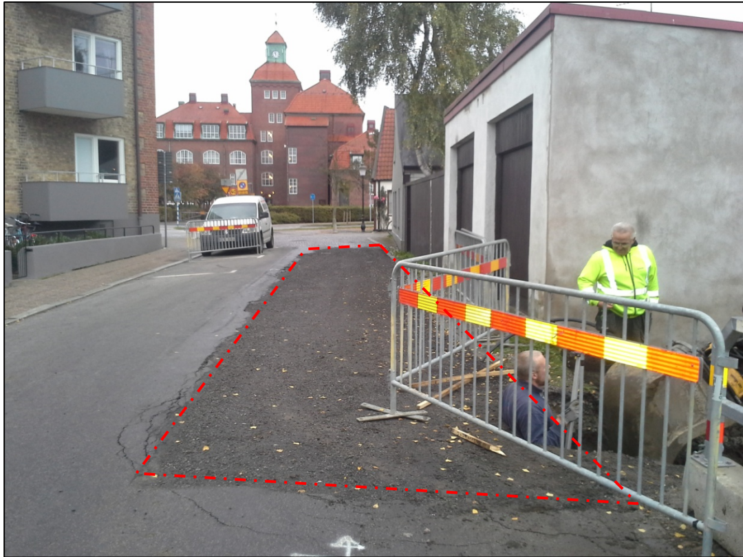
Figur 5. Inför planerad husbyggnation skulle en inkoppling av vatten och avlopp till det kommunala ledningsnätet göras och det schaktades en större yta ned till en nivå av allra minst 1,40 m under dagens marknivå (röd markering). Markingreppet skedde utan arkeologisk övervakning och området bör vara jämförbart med medeltidens Lilla Östergatan eller tomtmark strax intill gatan. Fotografiet taget från väster.
