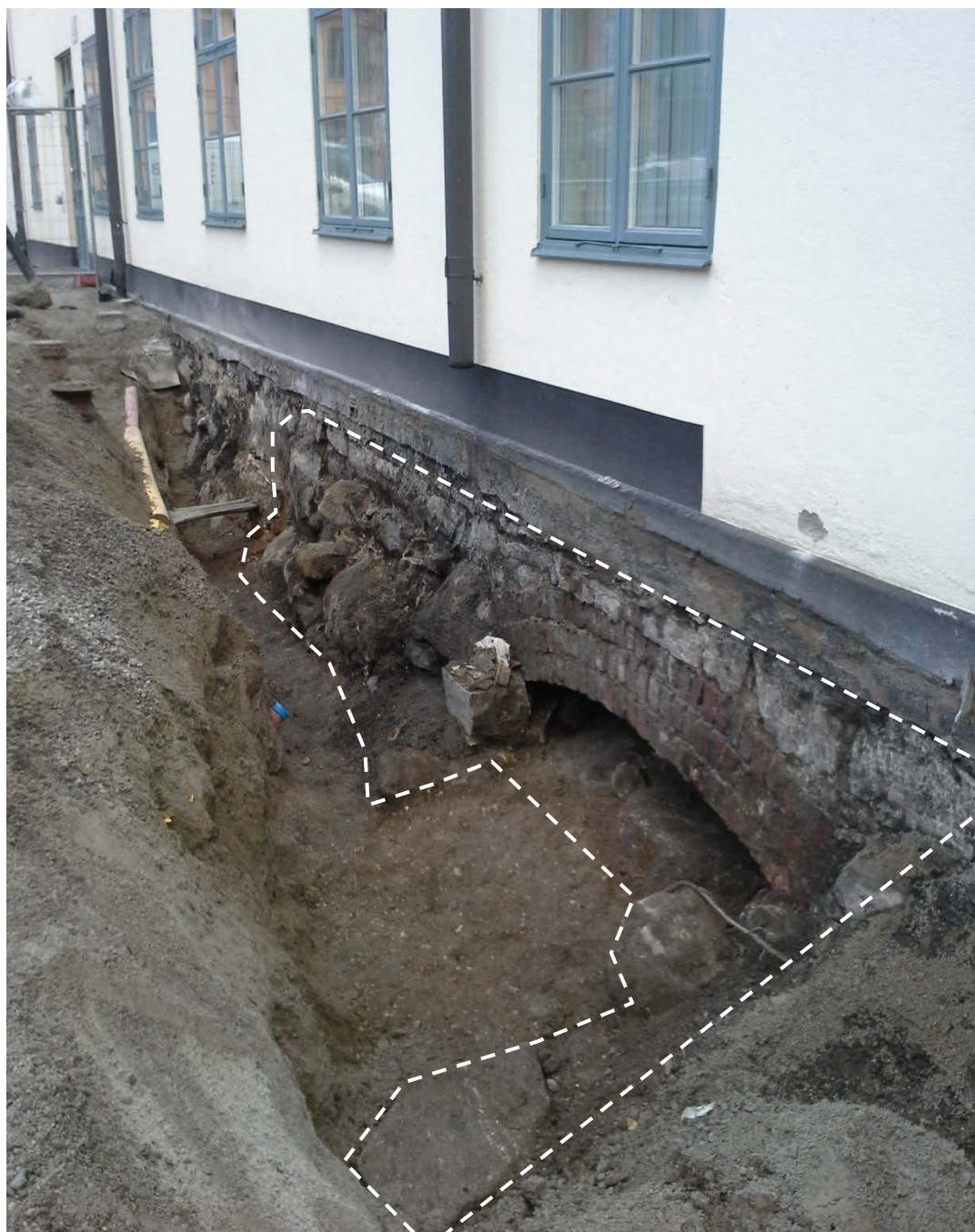
Figur 9. Ett tegelvalv med stora gråstenar under och däremellan ett hålrum. Möjlig del av en äldre byggnad. Större grundstenar påträffades även norr om den befintliga byggnaden. Den vita streckade linjen visar var och hur en äldre byggnad är införlivad i den befintliga byggnaden som uppfördes år 1864.
