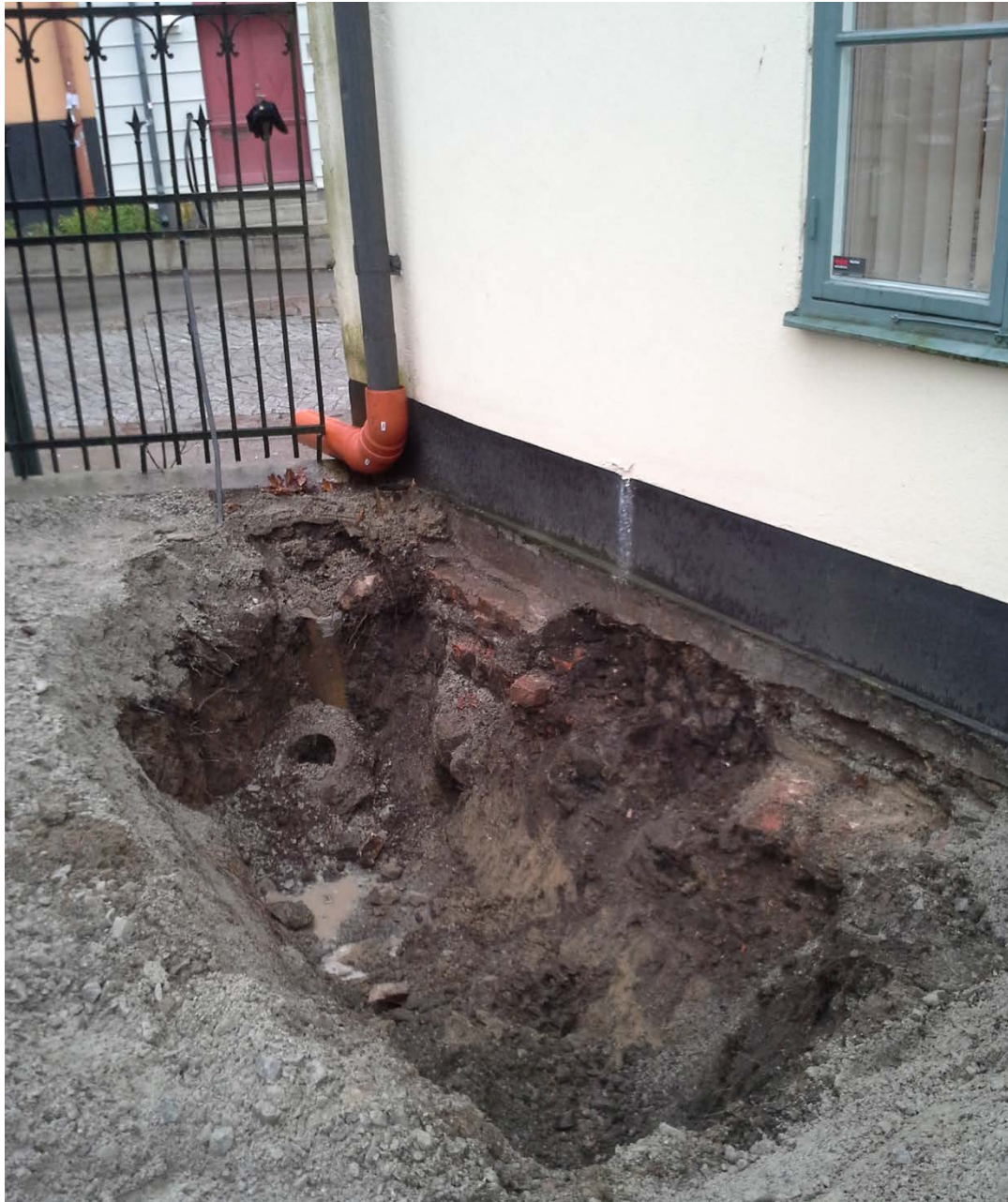
Figur 8. Till en början utfördes arbetet med dräneringen utan tillstånd, men därefter fanns arkeolog på plats. Fotografiet taget från nordväst i samband med att schaktet upptäcktes.
