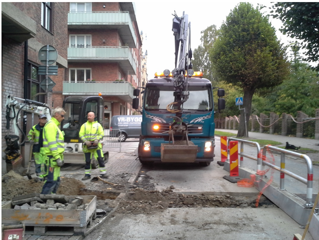
Figur 5. Schakt 3 grävdes utmed Östra Vallgatan 41 samt tvärs över gatan mot Botanicum 15. Fotografiet är taget från söder.
