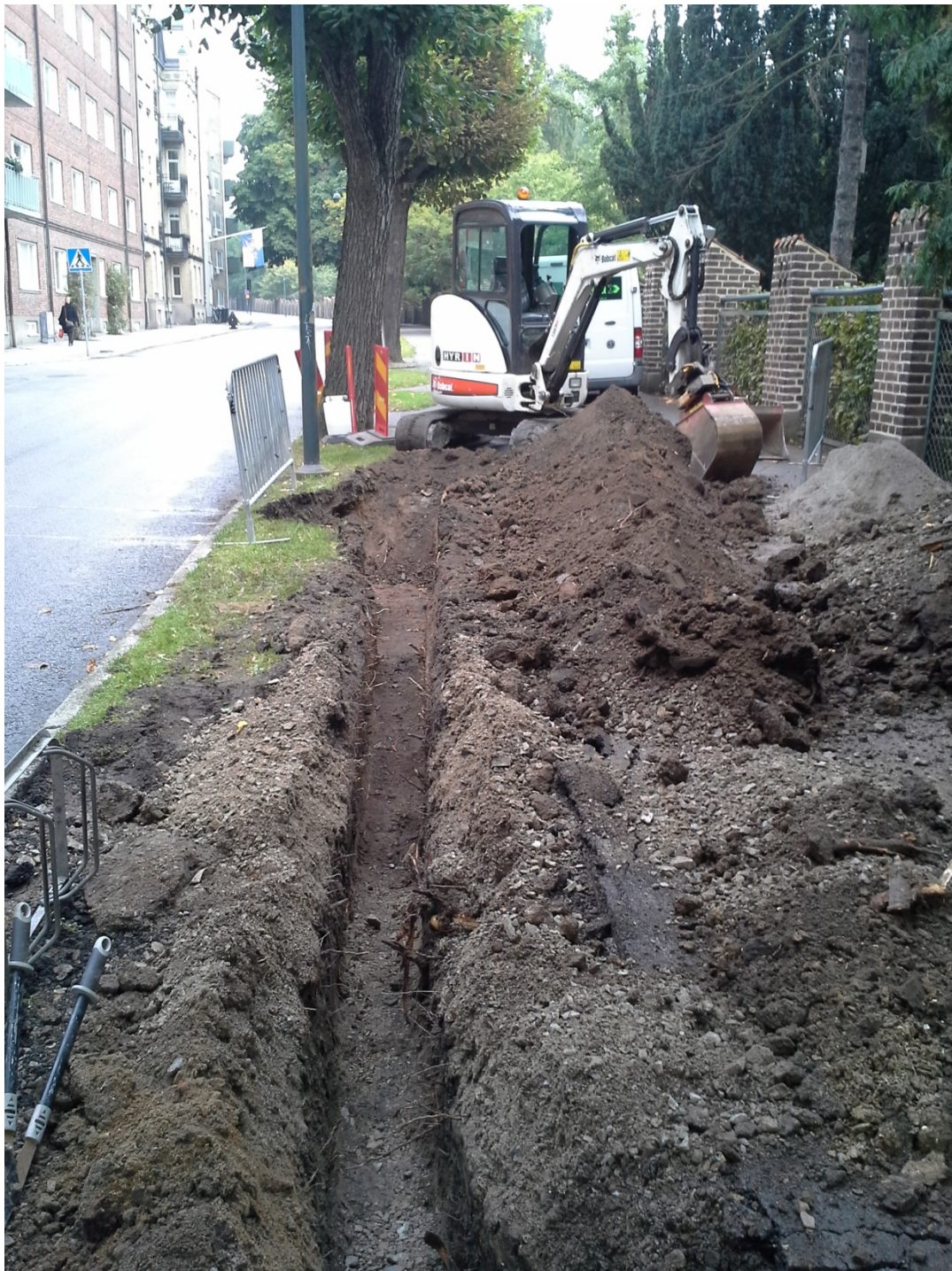
Figur 4. Schakt 2 grävdes i trottoaren utanför Östra Vallgatan 14 längs med Östra Vallgatans östra sida. Fotografiet är taget från söder.
