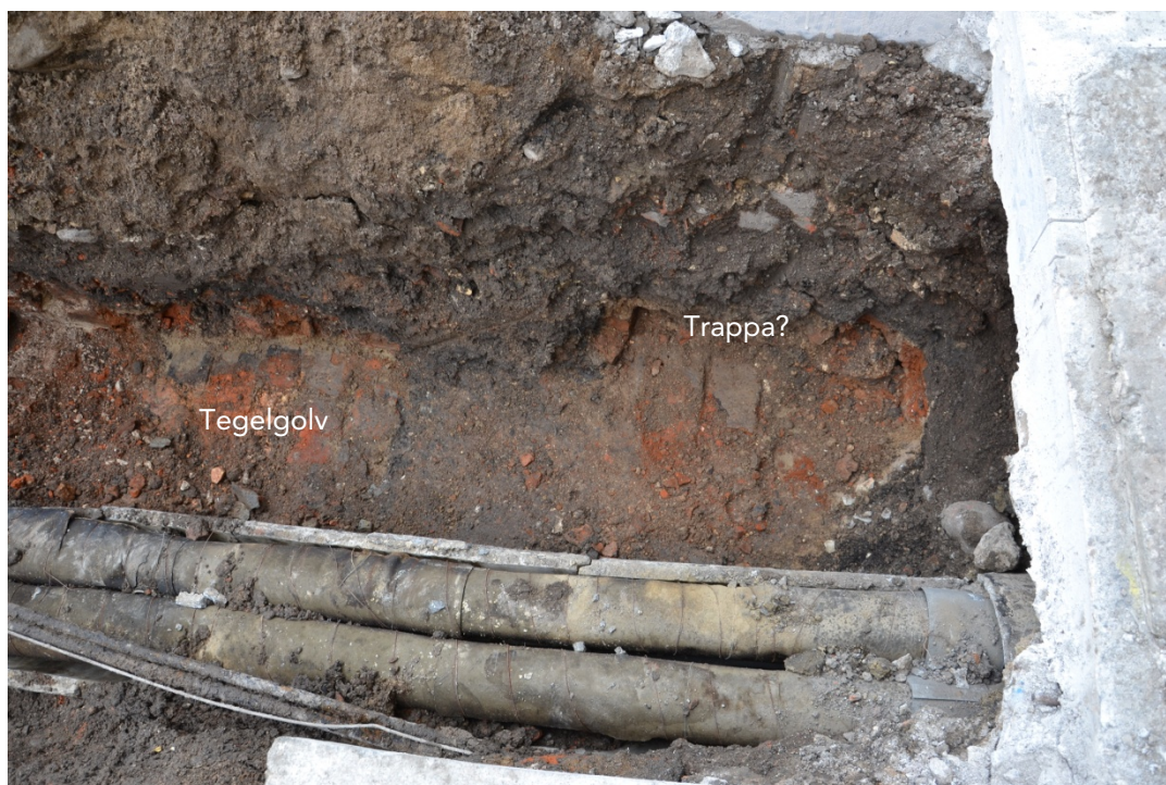
Figur 19. Ett tegelgolv samt delar av en mur eller trappa i den västra delen av Schakt 2 mot den västra fastigheten.
