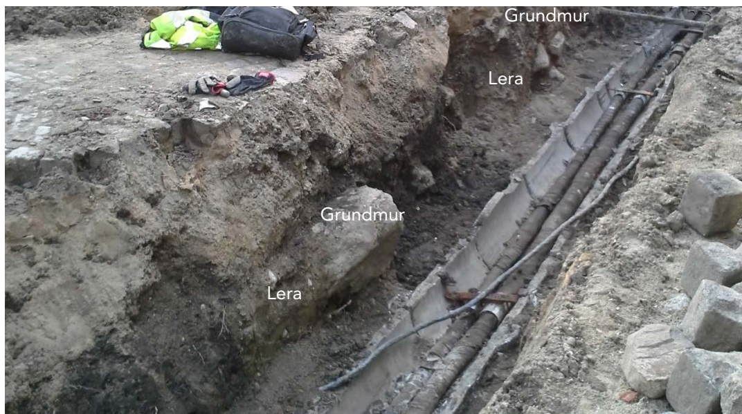
Figur 18. Ett kompakt lager av gul stabil lera packades kring grundmurar i Schakt 2, troligen för att murarna inte var grundlagda på moränlera utan högre upp.
