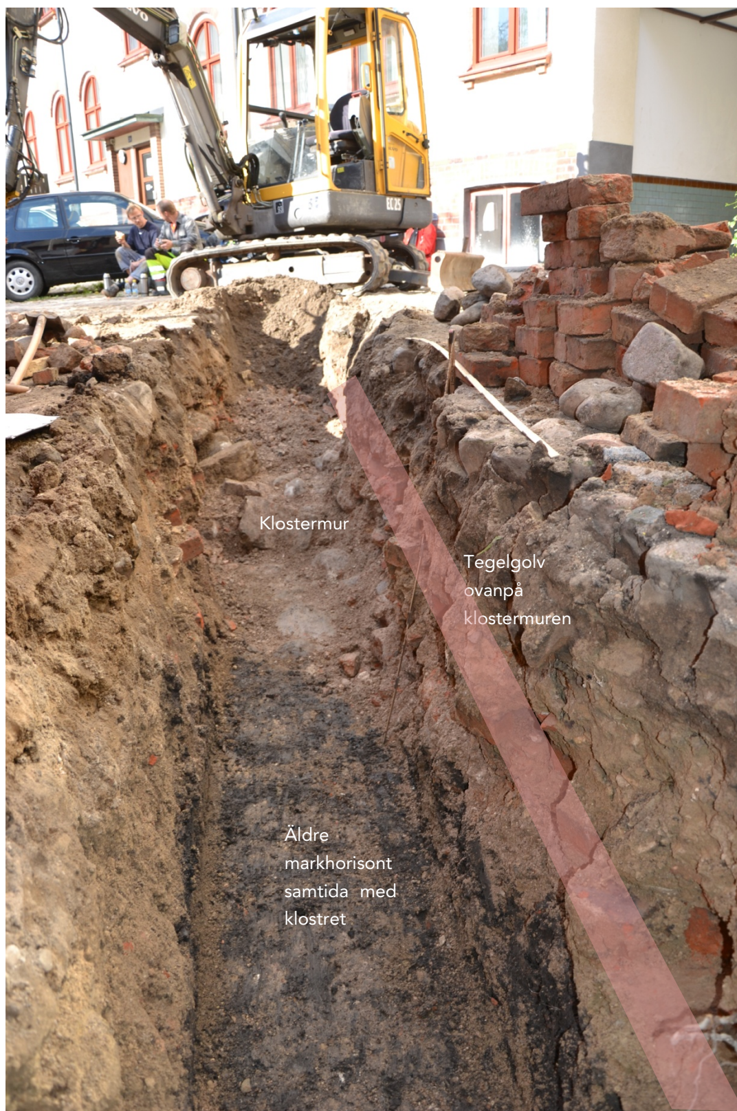
Figur 16. Schakt 1. Äldre markhorisont norr om den gamla klostermuren. Ett tegelgolv lades över raseringsmassorna och den äldre muren. Fotografiet taget från norr.
