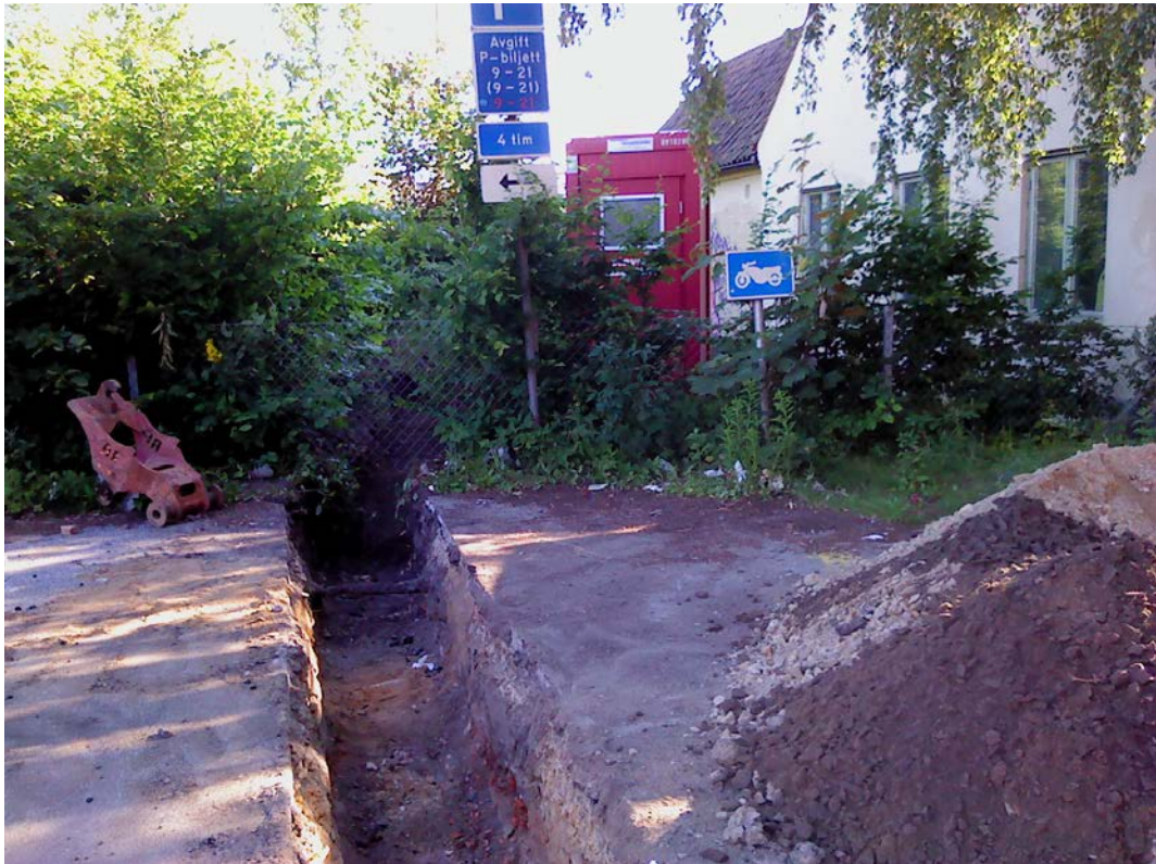
Figur 32. Mycket buskage och växtlighet i schaktningsområdet vid Banmästarebostaden. Växtligheten har troligen bidragit till att torka ut delar av lämningarna. Fotografiet taget från söder.
