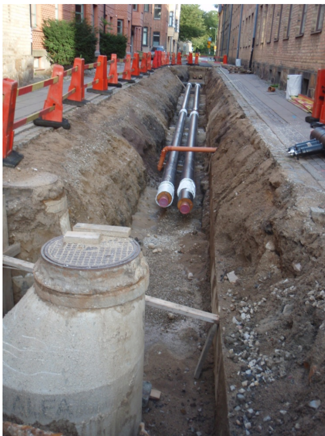
Figur 11. Svanegatan med den nya fjärrvärmedragningen intill den gamla kulverten. Fotografi från öster.
