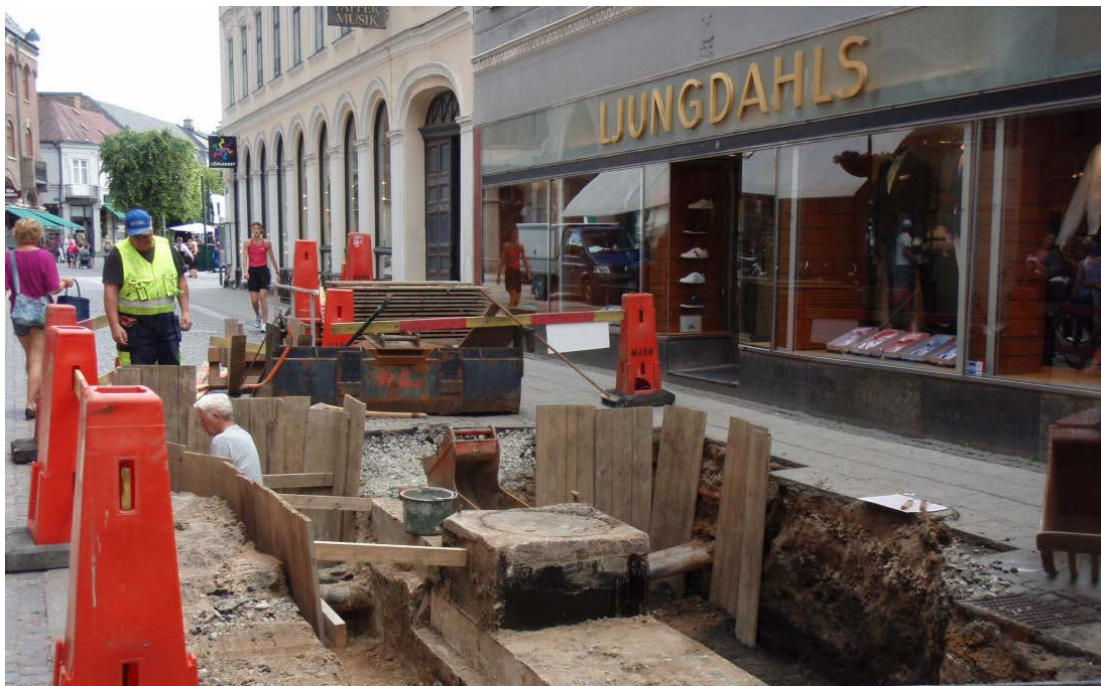
Figur 10. Fjärrvärmeschaktet utanför Ljungdahls herrekipering på Lilla Fiskaregatan.
