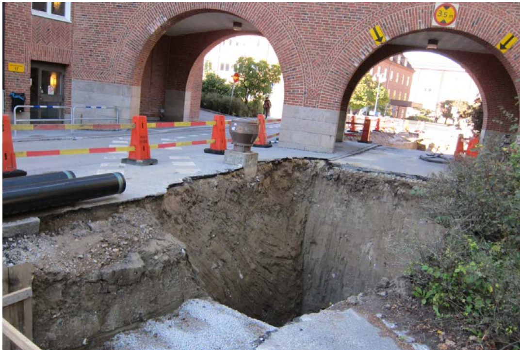
Figur 15. Fjärrkyla vid kv Eskil 20, Lund. Fotografi från sydöst.
