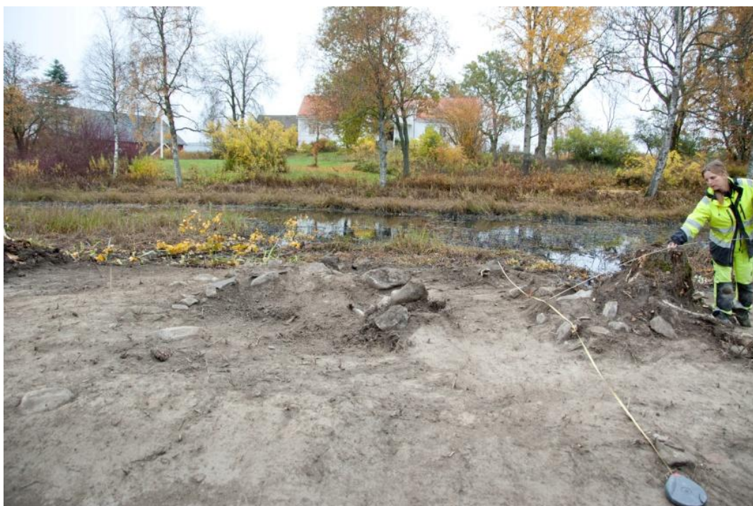
Figur 3. Schakt 2 med lusthusområdet intill dammkanten i siktlinje med huvudbyggnaden i norr. Aja Guldåker dokumenterar stenkonstruktionen som lusthuset vilat på. Foto Anne Kaurin, fotografi från söder.
