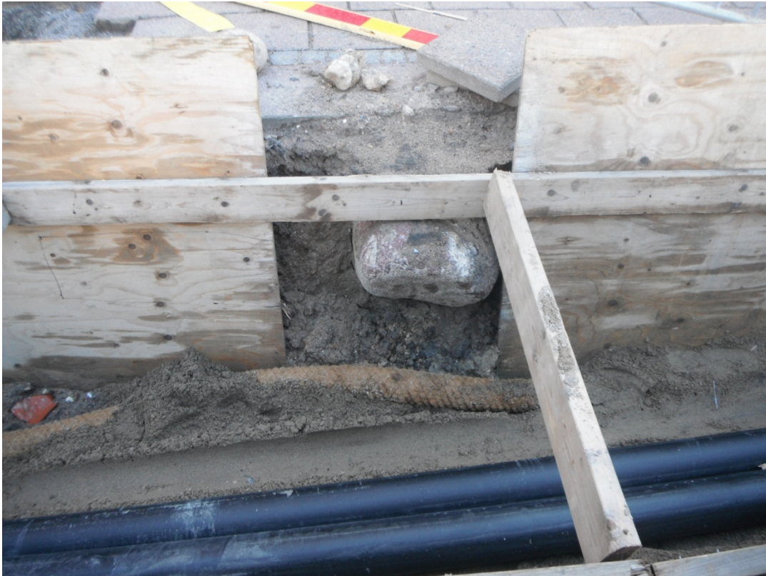
Figur 3. En av grundstenarna som påträffades läts vara, medan de som låg där fjärrvärmerören skulle dras, togs bort.
