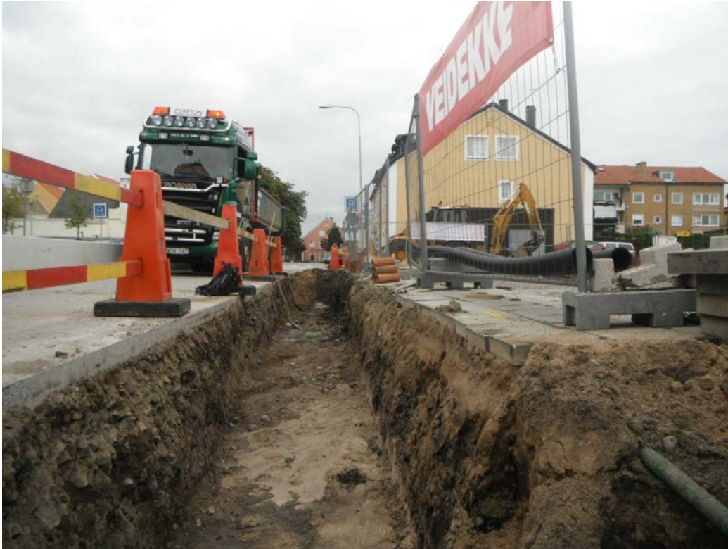
Figur 2. Undersökningschaktets västra del, sett från väster. Västergatan är belägen till vänster på fotografiet och kv Sjöjungfrun 11 till höger.
