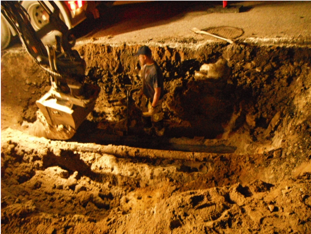
Figur 4. Den norra delen av undersökningsområdet med befintliga rör i botten.
