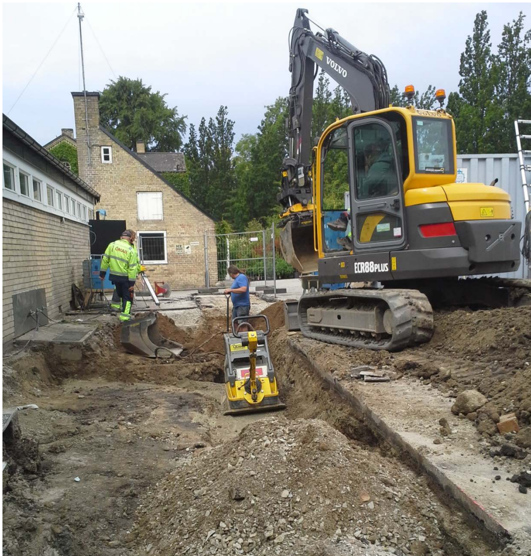
Figur 5. Schaktningsarbeten norr om befintlig personalbyggnad. Fotografi taget från öster.
