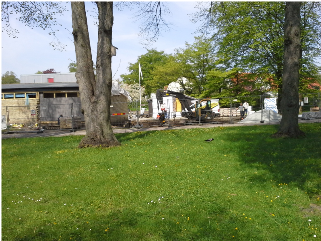
Figur 3. Utbyggnad av personalutrymmen. Schaktningsområdet öster och norr om befintlig byggnad. Fotografi taget från söder.
