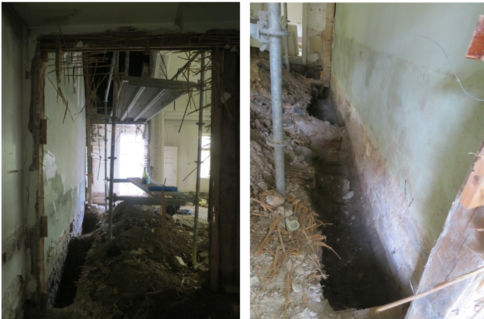
Figur 7. Den norra delen av kyrksalen, kantbalk. Till vänster översikt tagen från sydväst, till höger detalj av kantbalk tagen från sydöst.
