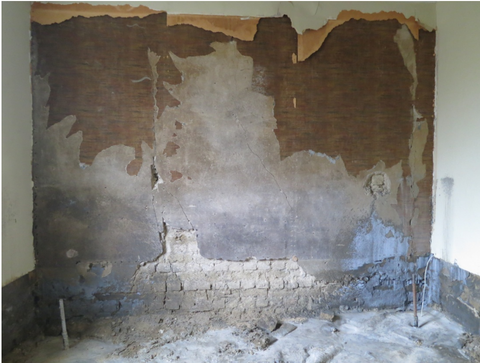
Figur 10. Den sydöstra väggen. Fotografi från norr.
