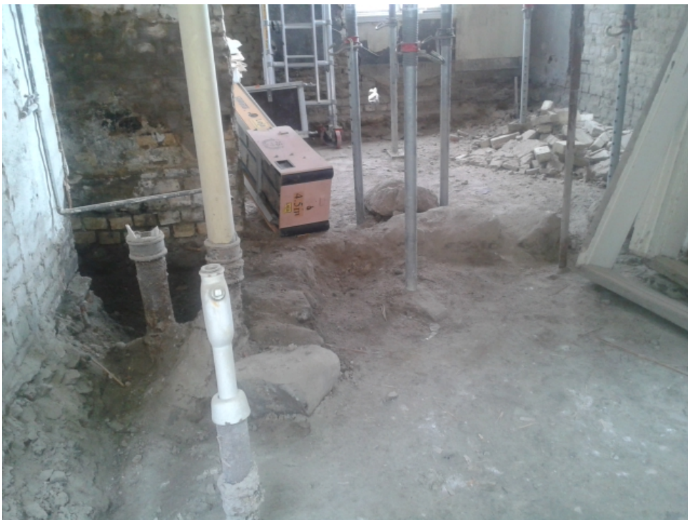
Figur 11. Blottade grundstenar till mellanväggar, i byggnadens södra del. Fotografi från väster.
