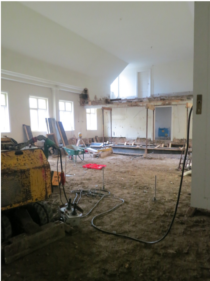
Figur 9. Översikt över grävningsarbetena i kyrksalen. Fotografi från norr.
