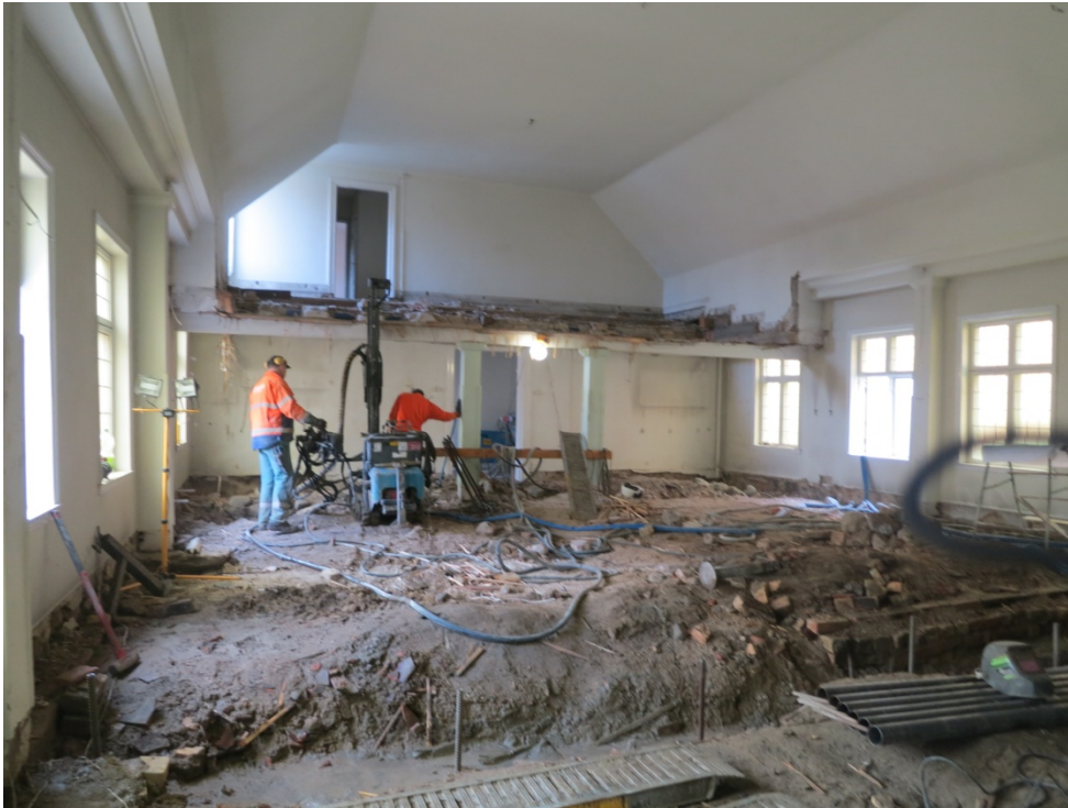
Figur 6. Påning i kyrksalen, fotografi från söder.
