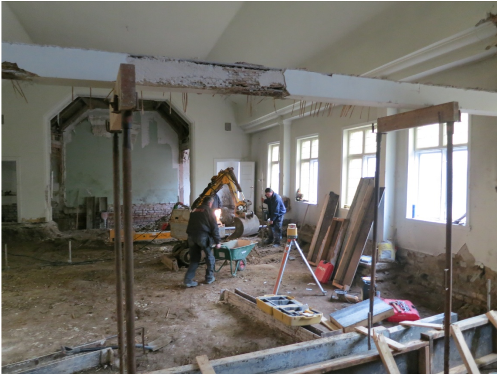
Figur 8. Översikt över grävningsarbetena i kyrksalen. Fotografi från söder.
