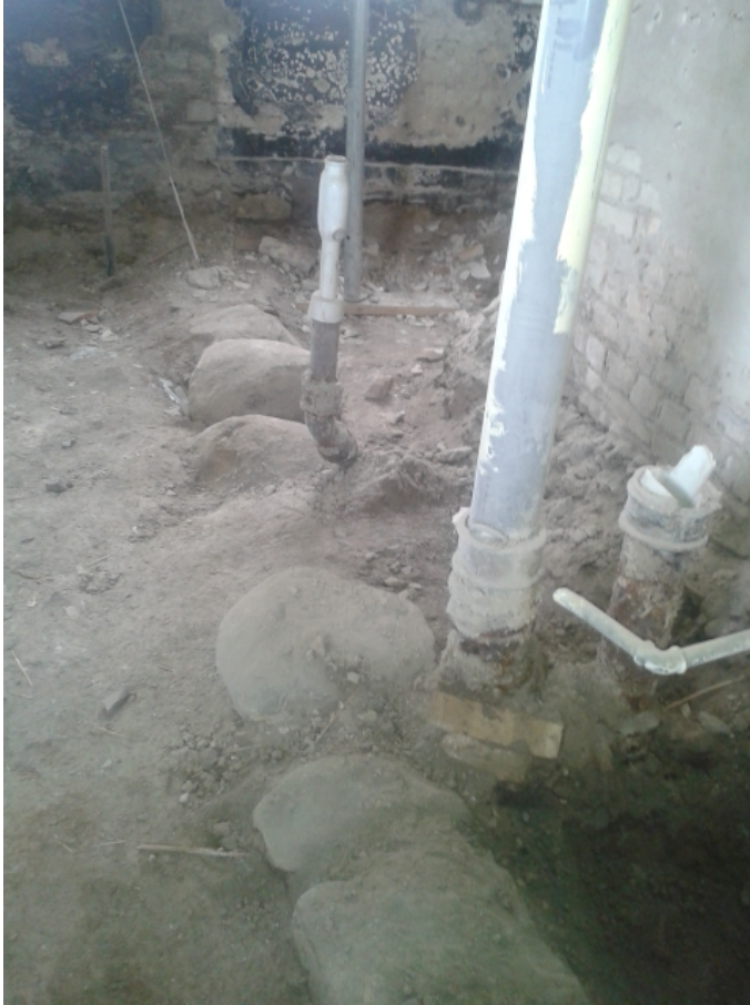
Figur 12. Blottade grundstenar till mellanväggar, i byggnadens södra del. Fotografi från öster.
