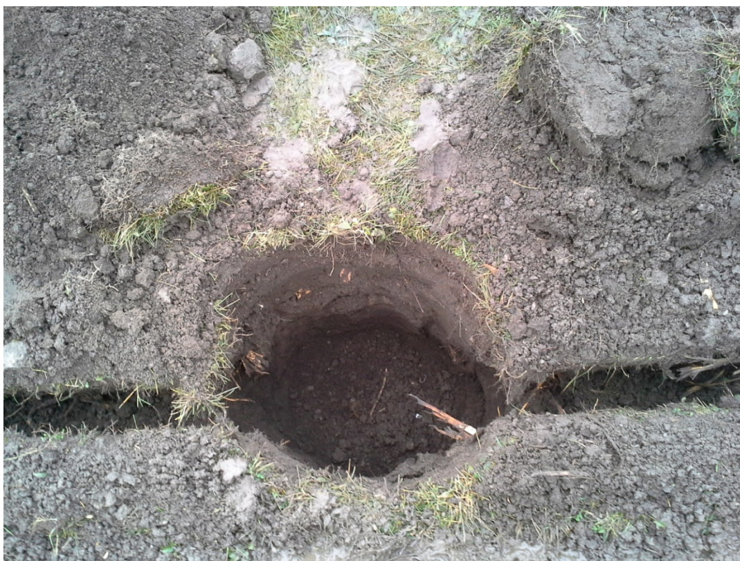
Figur 3. Fotografi från undersökningen. Nedgrävning för fundament till belysningsstolpe samt kabelschakt. Fotografi från öster.
