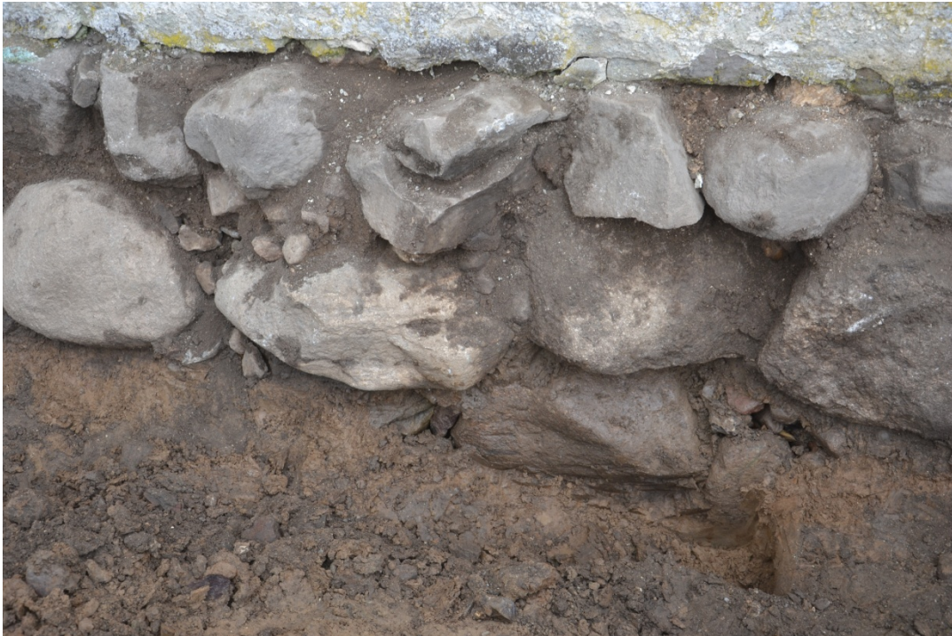
Figur 4. Grundmurar i 3 skift i det norra schaktet. Fotografiet är taget från norr.
