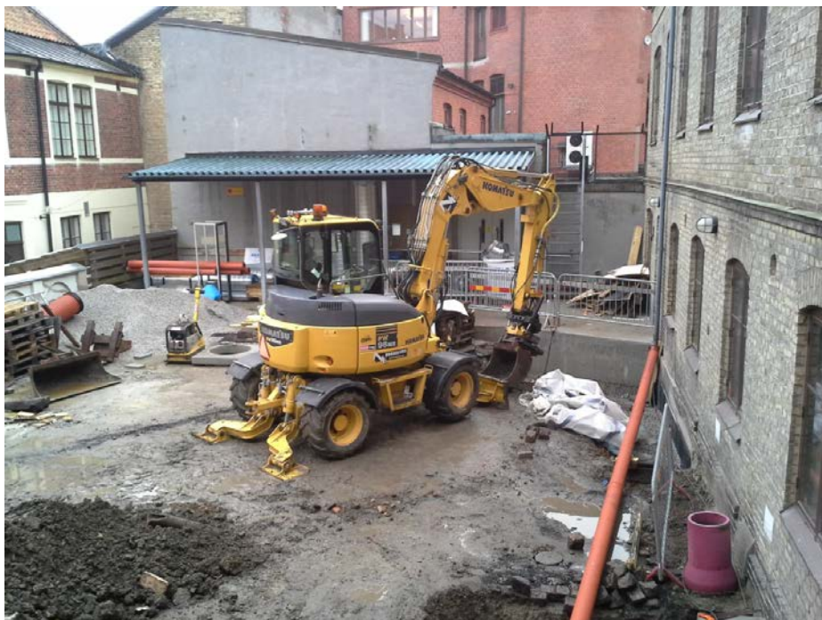
Figur 13. Innergården på kv Döbeln 3 där ledningar drogs. Fotografi från norr.
