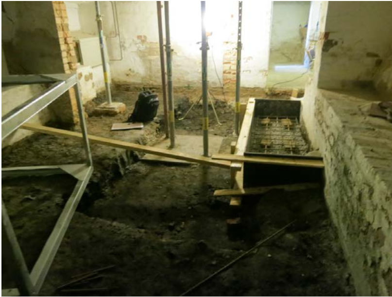
Figur 8. Källare B, fotografi från öster.
