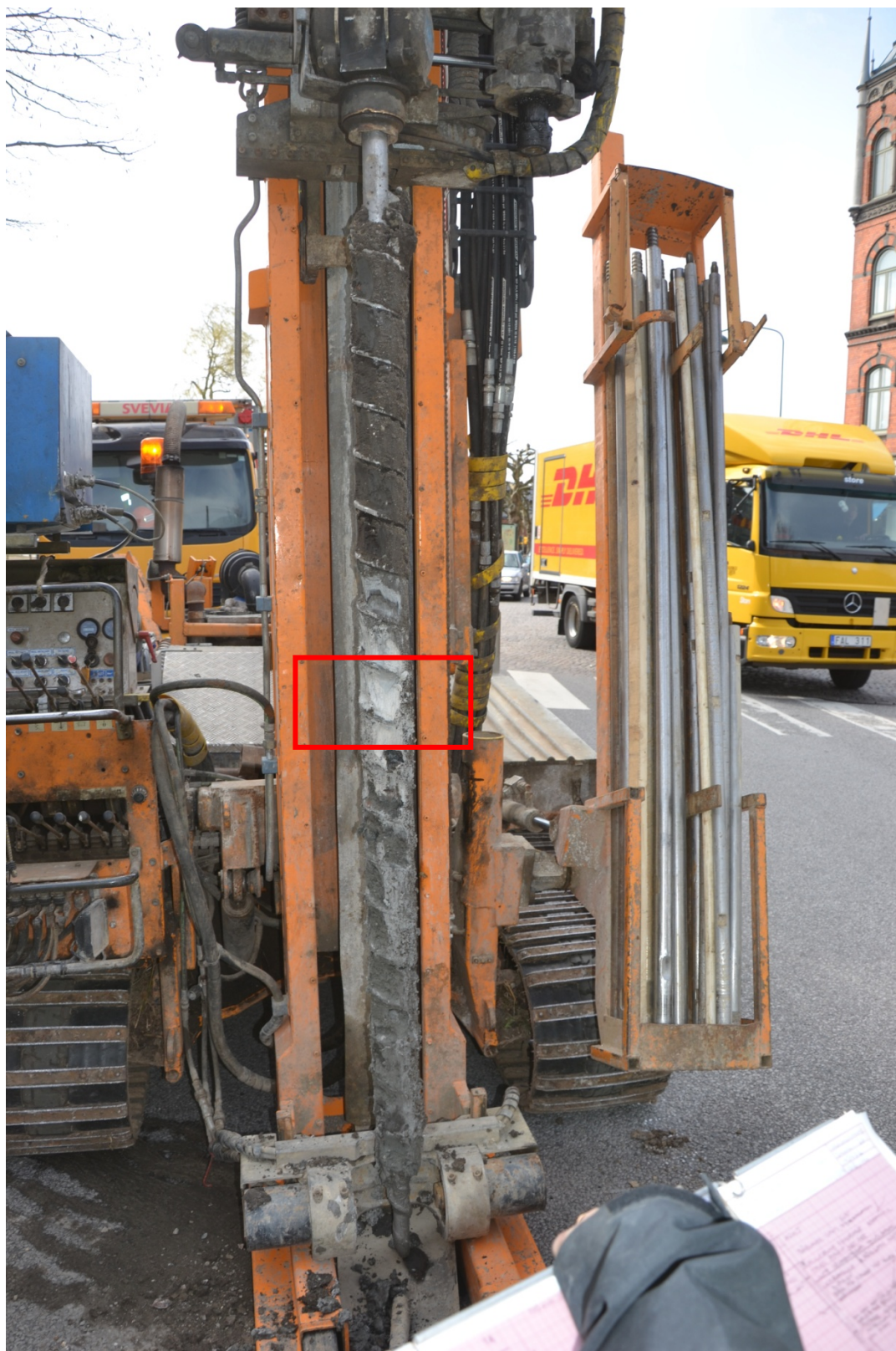
Figur 9. Borrprov 2 med det kalkhaltiga lagret markerat med en röd ruta på bilden. Fotografiet taget mot sydväst.
