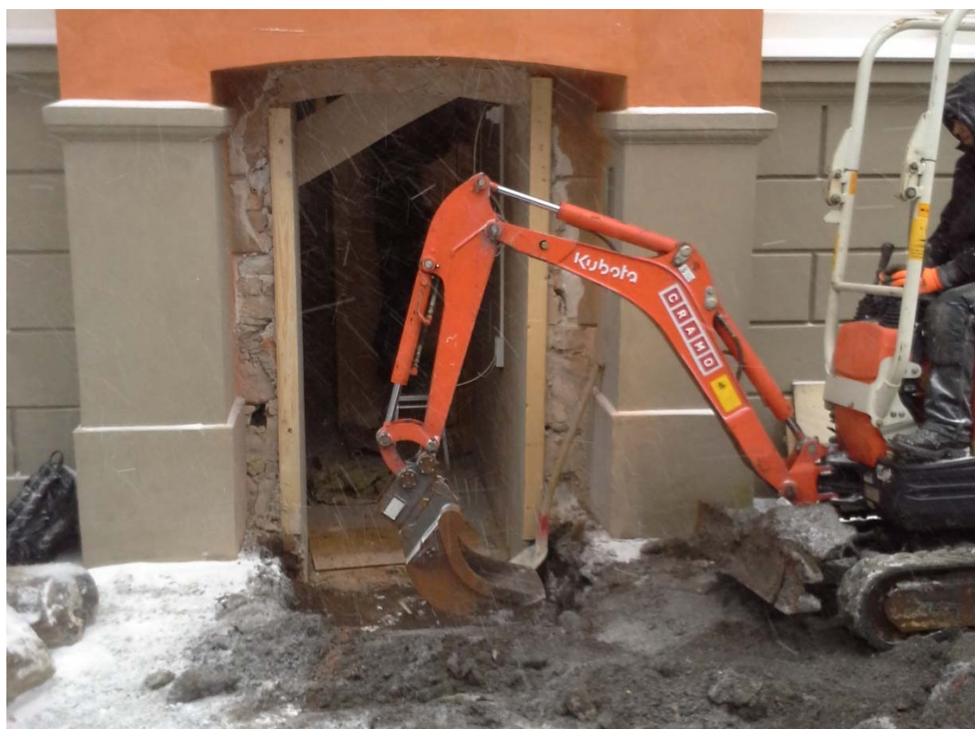
Figur 5. Ny öppning i Herrehuset. Fotografiet taget från norr.
