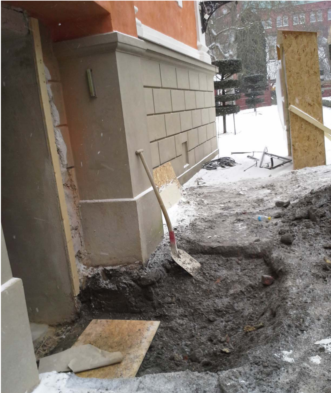
Figur 6. Schaktning för utrymningsväg på Herrehusets norra gavel. Fotografiet taget från öst.
