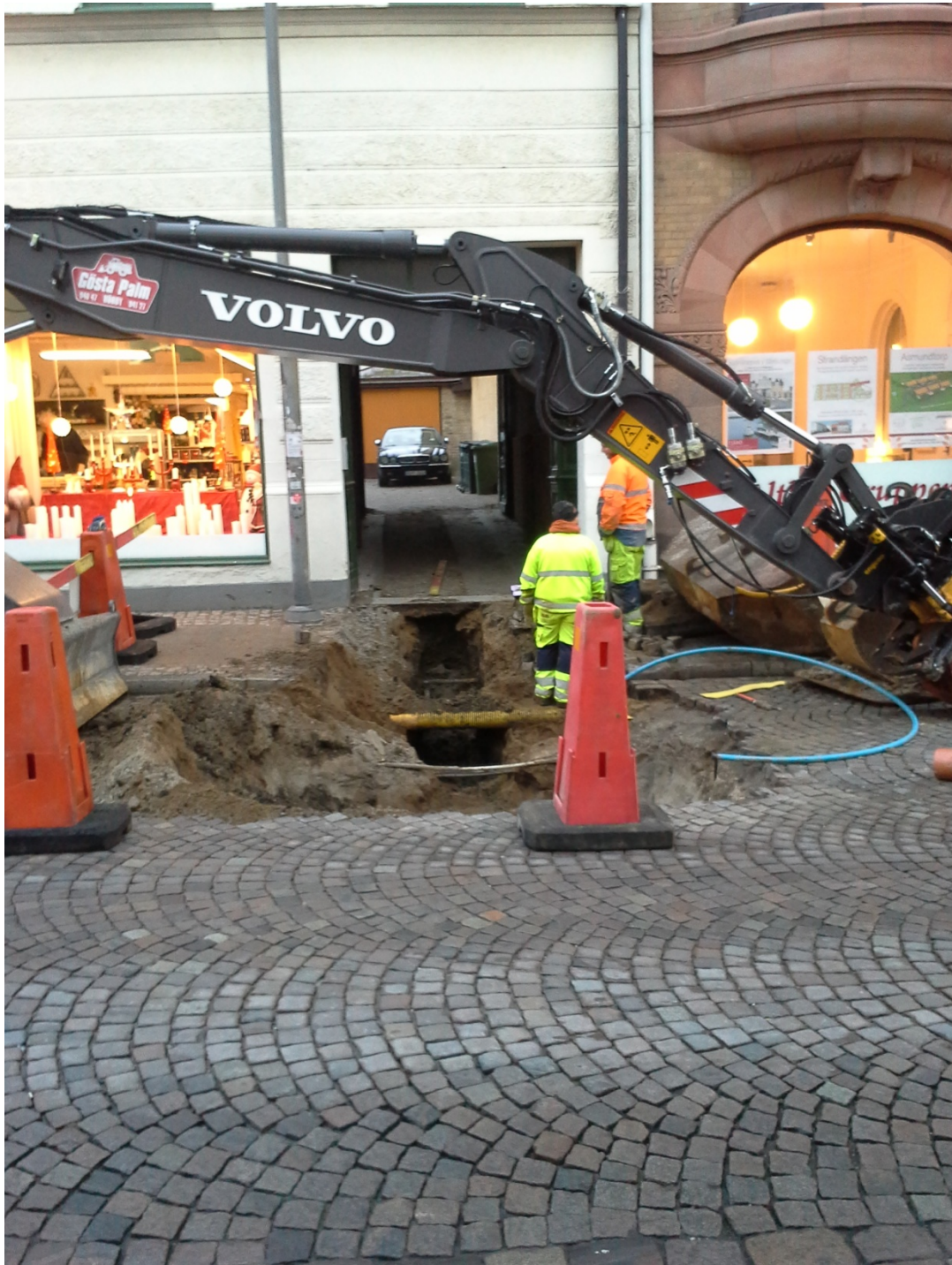
Figur 4. Området för schaktningsarbeten intill fastighet kv Paradis 61. Fotografiet taget från väst.
