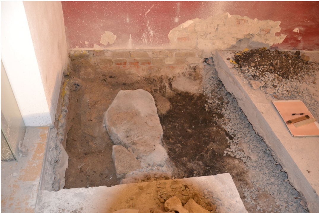
Figur 5. Hissgropen i Herrehuset där lämningar efter en mellanvägg påträffades. Fotografiet taget från söder.
