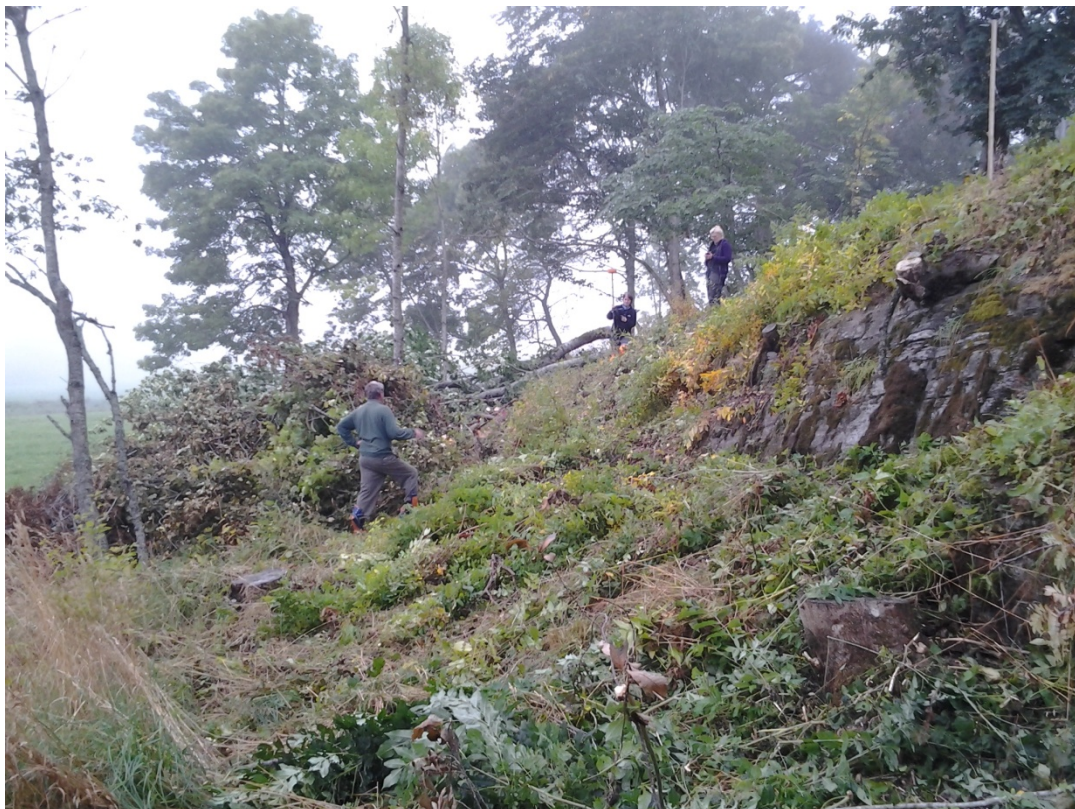
Figur 29. Odd röjer bland grenar inför schaktning, Inger Marie mäter med GPS och Brit övervakar arbetet från 1:a terrass. Höjdskillnaderna och sluttningarna gjorde det svårt för grävmaskinen att komma fram i terrängen. Fotografiet taget från öster, Kulturen 2013.
