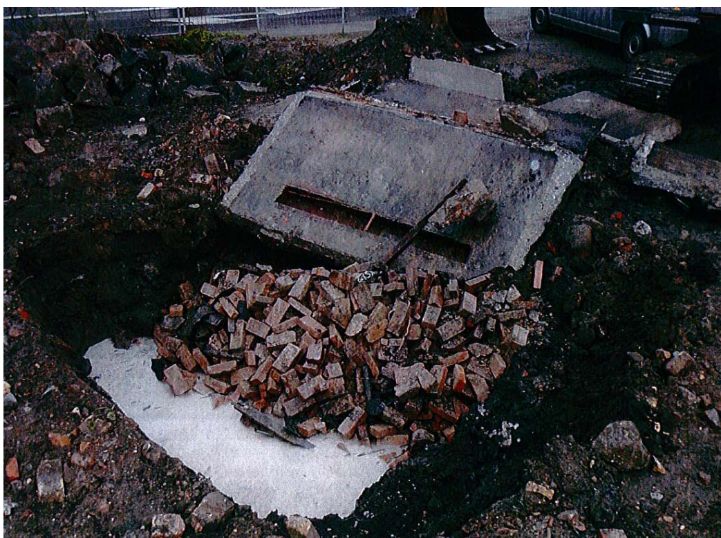
Figur 41. Grop F, vatten och tegelsten fyllde den före detta smörjgropen, dom därför inte gick att dokumentera varken i plan eller sektion.
