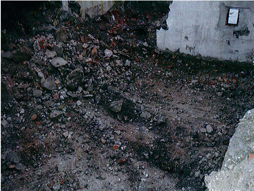
Figur 30. Källare C efter slutgiltig rivning. Betonggolvet revs innan källaren fylldes med stenkross. Fotografi från öster.
