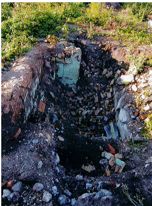
Figur 26. Källare B, innan rivning. Fotografi från norr.
