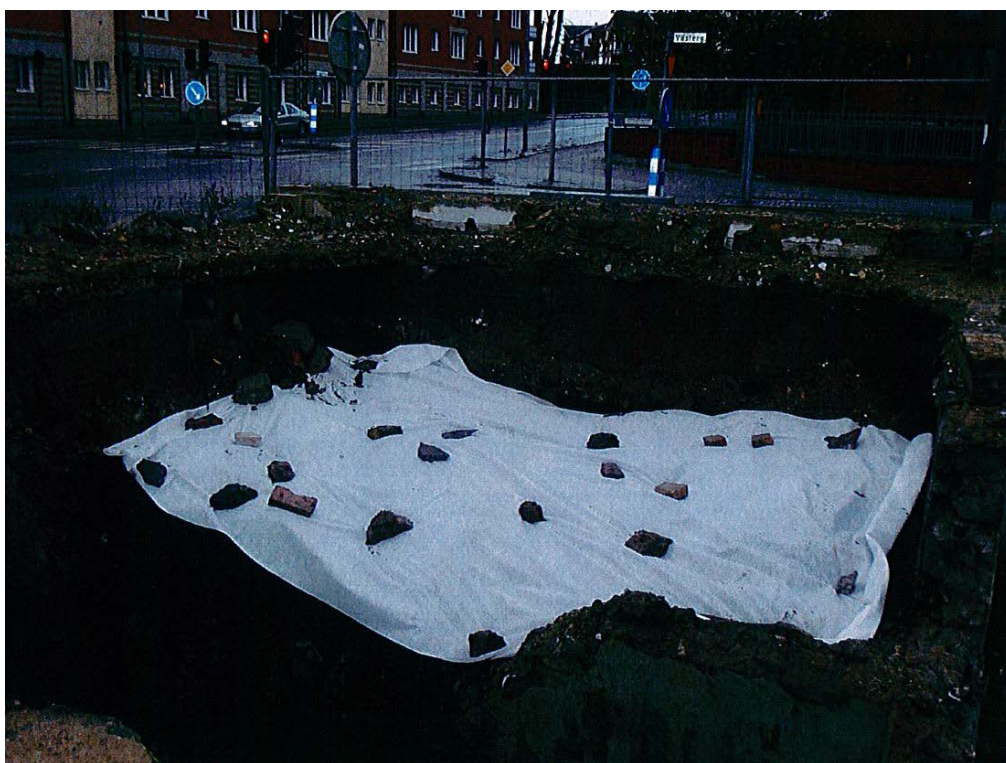
Figur 29. Det bevarade kulturlagret i källare C täcktes med geotextil innan stenkross fylldes på. Fotografi från sydöst.
