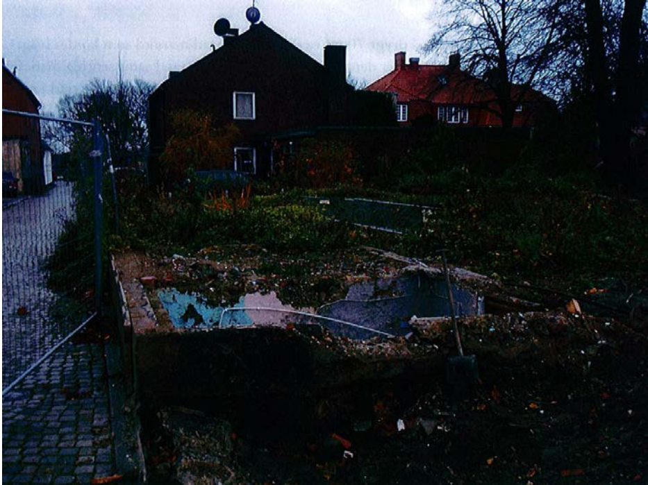
Figur 23. Källare A, efter rivning ner till golvbjälklag, men innan fullständig rivning. Fotografi från norr.
