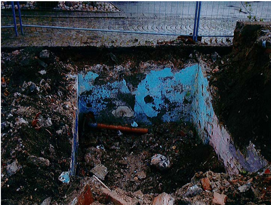
Figur 24. Källare A efter att murarna rivits till +2,20 m ö h, men innan den fylldes med stenkross. Fotografi från väster.
