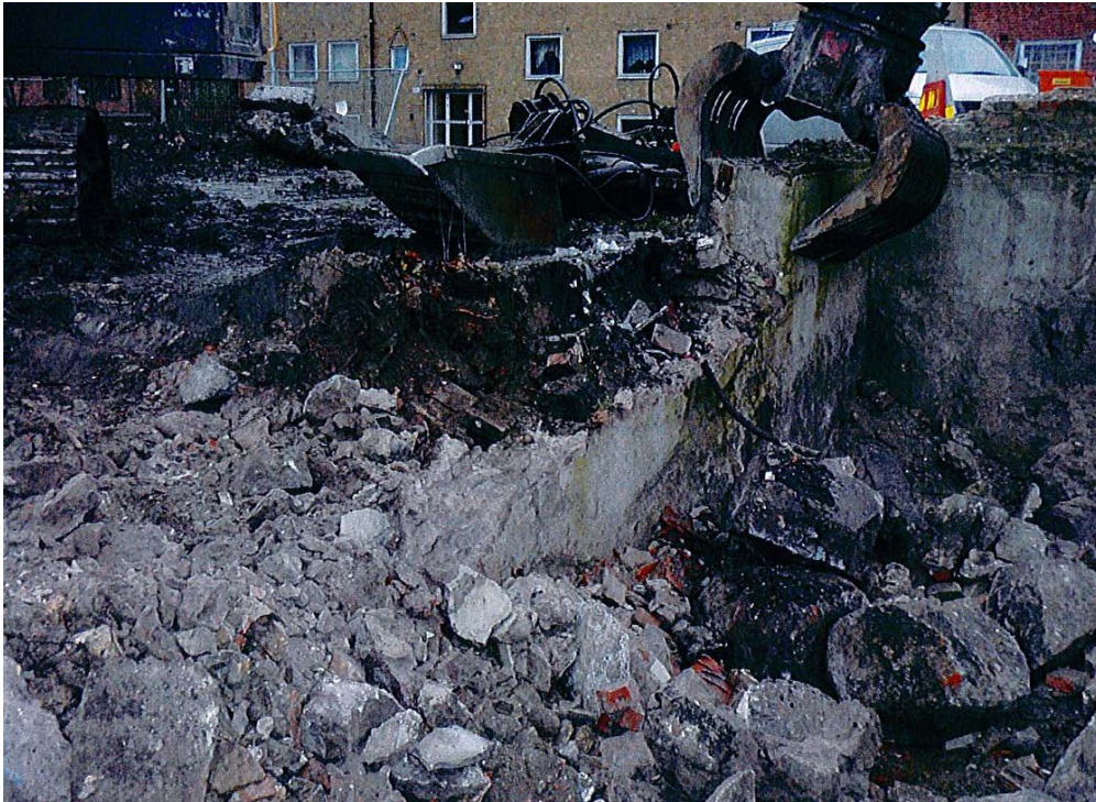
Figur 32. Källare C under rivning. För att inte skada omkringliggande kulturlager revs källarmurarna försiktigt ned till +2,20 m ö h. Fotografi från nordöst.
