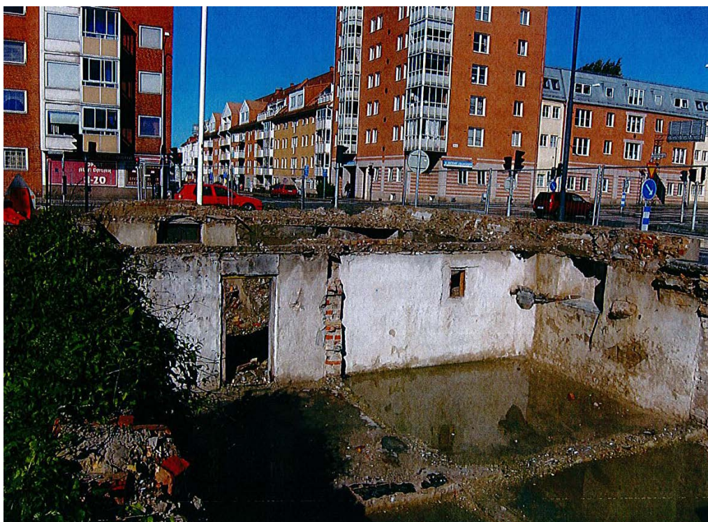
Figur 28. Källare C, efter rivning ner till golvbjälklag, innan slutgiltig rivning. Fotografi från öster.
