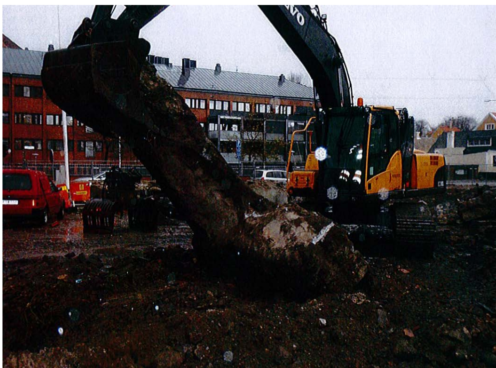
Figur 36. Grop E, betongklumpen. Fotografi från sydväst.
