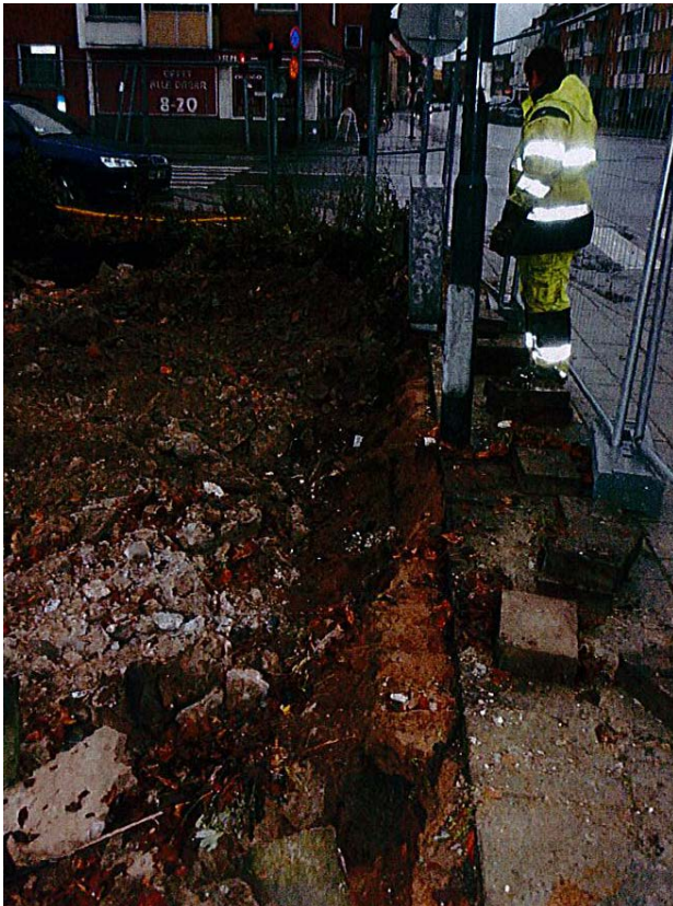
Figur 31. Källare C, efter rivningen och igenfyllningen med stenkross. Fotografi från öster.
