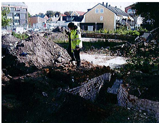
Figur 10. Källare D från väster, efter schaktning.
