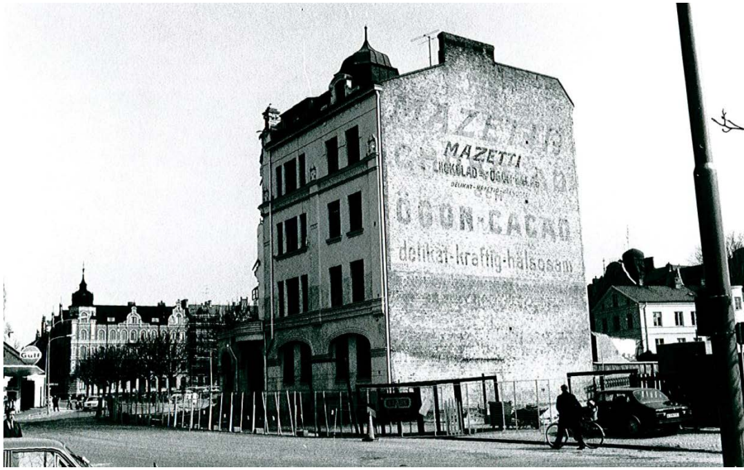
Figur 3. Kv Bytarebacken 1 (nuvarande Kv Bytarebacken 29) under rivning 1976. Fotografiet är taget från sydväst. Kulturens LB-arkiv, 1345:13.
