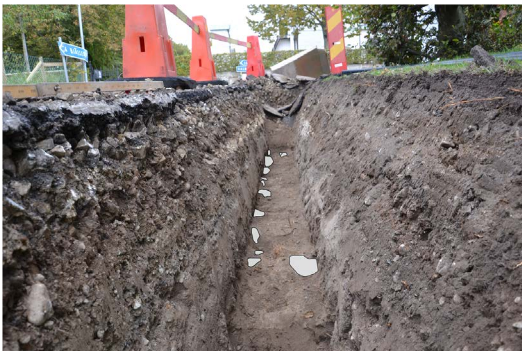
Figur 8. Schakt del 3 av schaktet med stenraden, som är färglagd med grått, centralt i fotografiet. Fotografiet är taget från söder.
