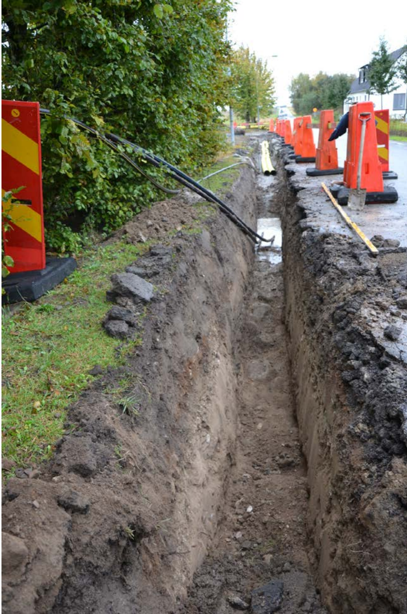
Figur 7. Schakt del 2 av schaktet med stenraden centralt i bild. Fotografiet är taget från norr.
