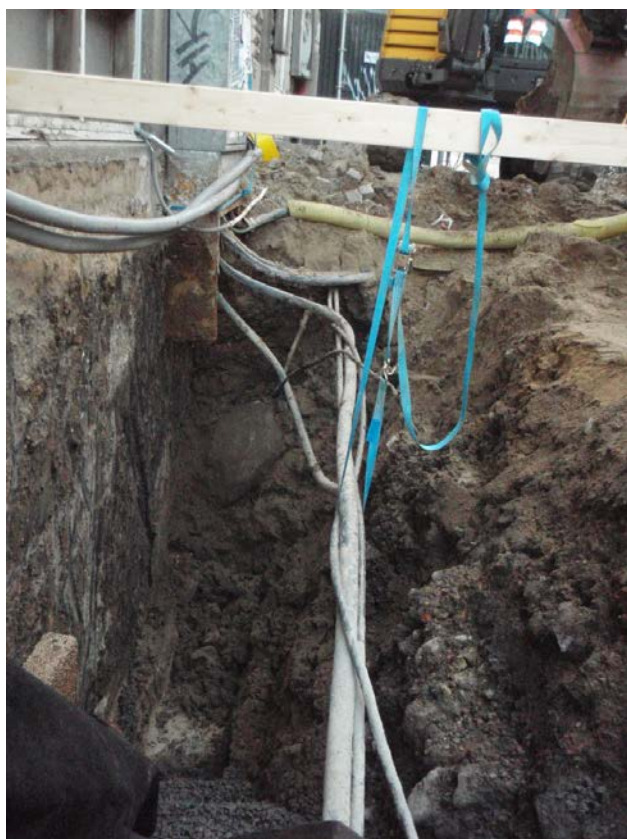
Figur 7. I samband med schaktningen för grundmurstättningen uppstod problem med befintliga ledningar och ledningsskåp, vilket försenade arbetena. Alldeles utanför Saluhallens källvägg påträffades kraftiga grundmursstenar vilka inte kunde bevaras utan togs bort. I schaktväggen syns en av stenarna markerad med en orange pil.
