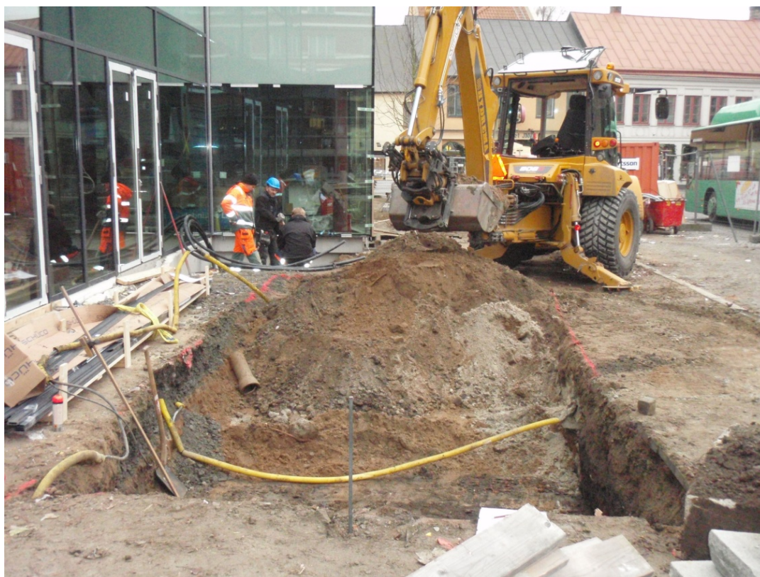
Figur 5. Schaktningsarbete för den norra trädplanteringsgropen.
