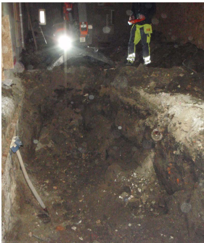
Figur 3. Schaktning för rulltrappa inne i den befintliga delen av Saluhallen. De trånga utrymmena och den dåliga tillgängligheten gjorde att en olämplig maskin användes, vilket medförde att planschaktning inte kunde genomföras.
