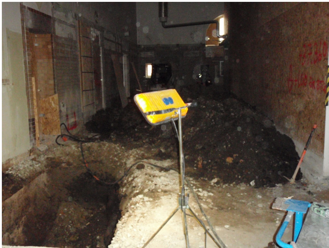
Figur 4. Förhållandena vid schaktningen inne i den befintliga delen av Saluhallen var besvärliga. Till vänster i bild kan schaktet för rulltrappan ses. Resterande delar av utrymmet sänktes med ca 0,30 – 0,35 m.
