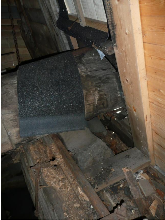
Före åtgärd, sölsten utan kontakt med axeln.
