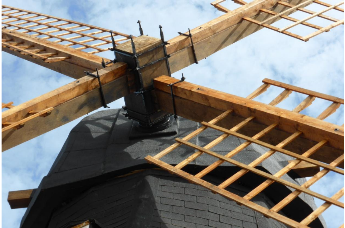
2013 ny axel med nya vingbalkar och återanvända vingspetsar, ny avrinning runt axelgenomföring
