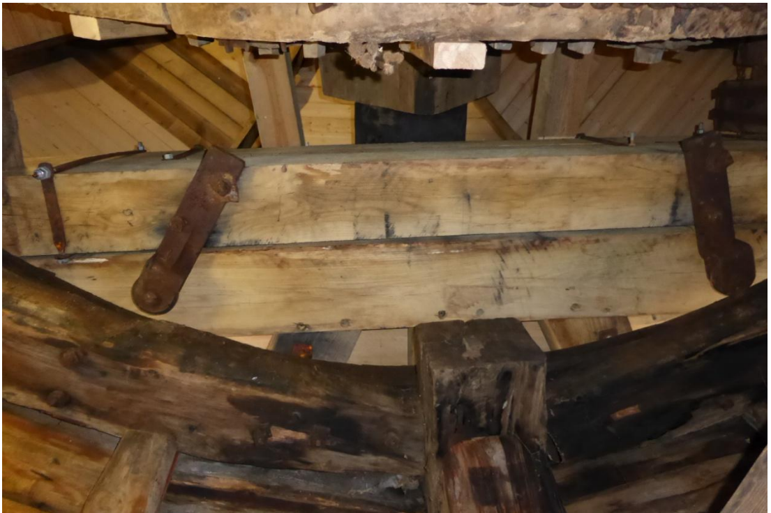
Nytt virke i upplag och utstickare
