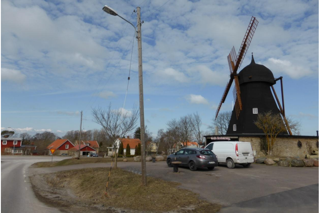
Kvarnen i Grönhögen, på sockeln en segelbana eller omgång, koniska delen är bölet eller kvarnkroppen, hättan med vingarna och de horisontella utstickarna.
