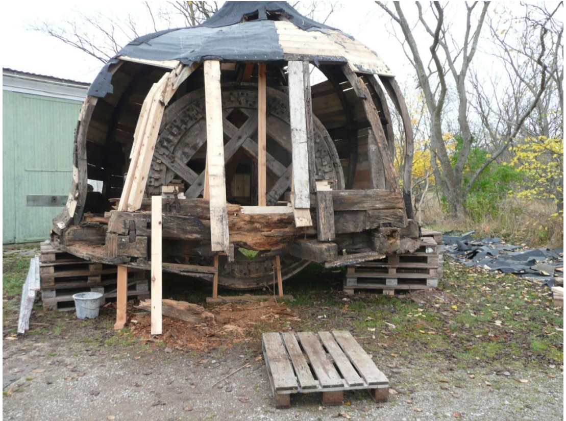
Hättan nedtagen, rötskadad stomme
