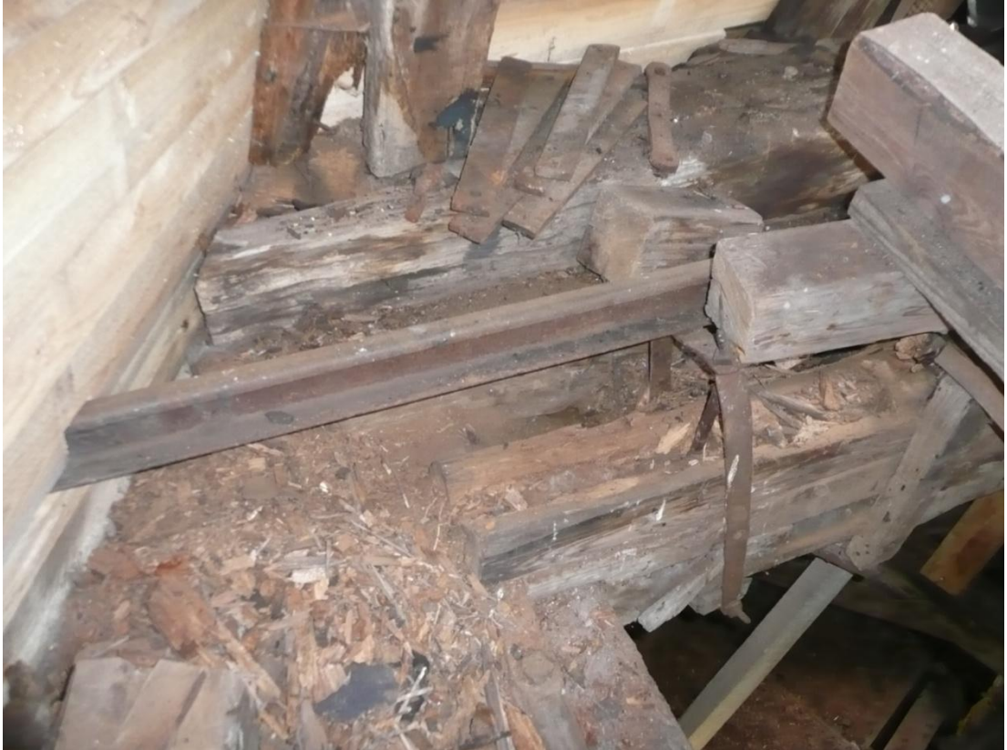
Före åtgärd, rötskador i underlag till axeln, utstickare ersatt av rälsbit
