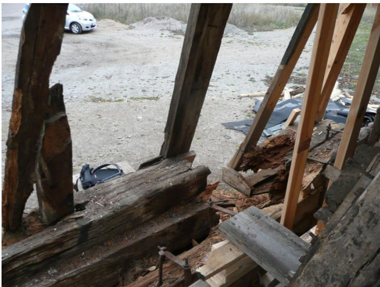
Rötskador i upplaget
