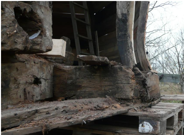
Nederkant hätta före åtgärd
