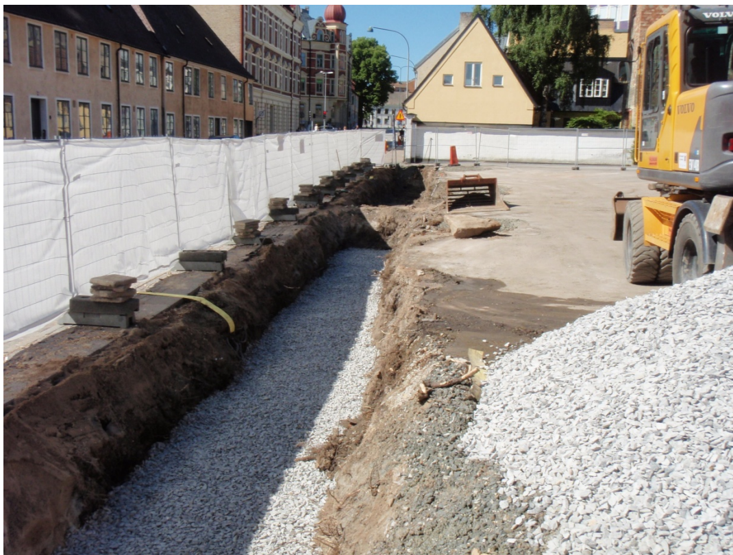
Figur 5. Schaktet grävdes från söder till norr längs Bredgatan. Bredgatan ligger till vänster om skyddsstängslet, fotografiet är taget från söder.
