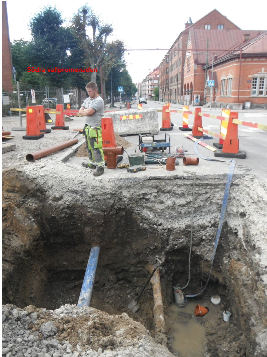
Figur 4. Rörgravar i gatan. De klippta lindarna på bilden visar var den Södra vallpromenaden gick tidigare, i området för den medeltida stadsvallen.
