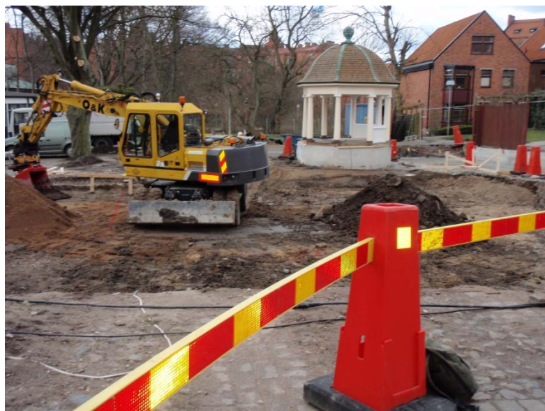
Figur 8. Schaktning för grundläggning. Fotografi från öster.
