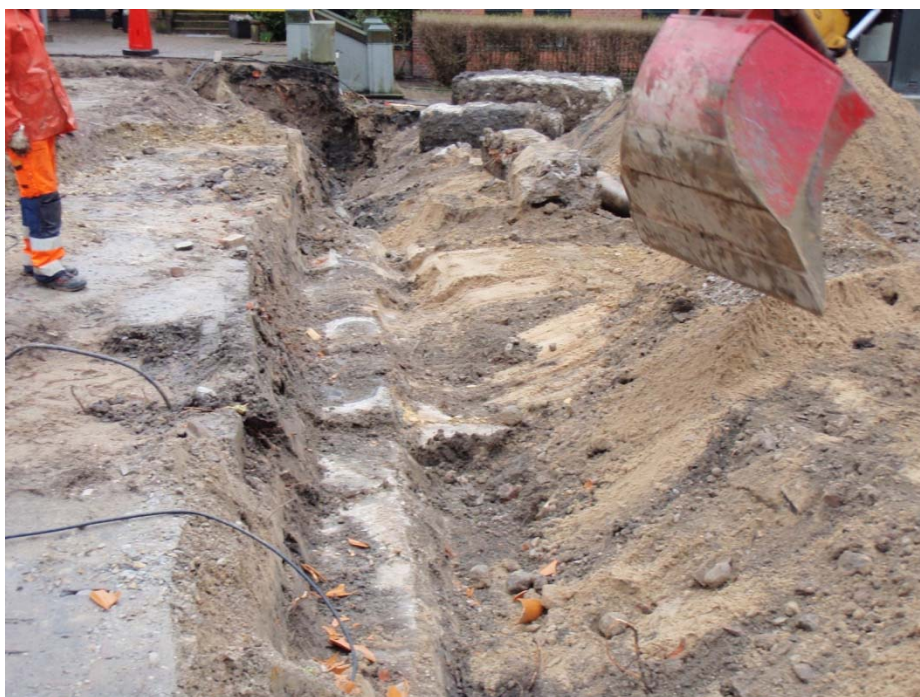
Figur 7. Upptagning av betongfundament. Fotografi från söder.
