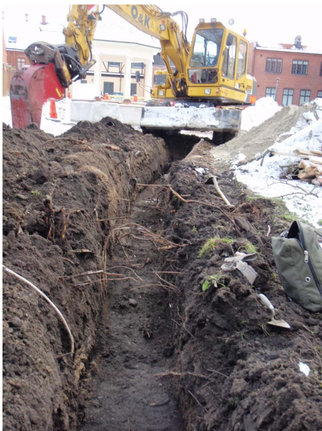
Figur 9. Schaktning för elkabel. Fotografi från väster.
