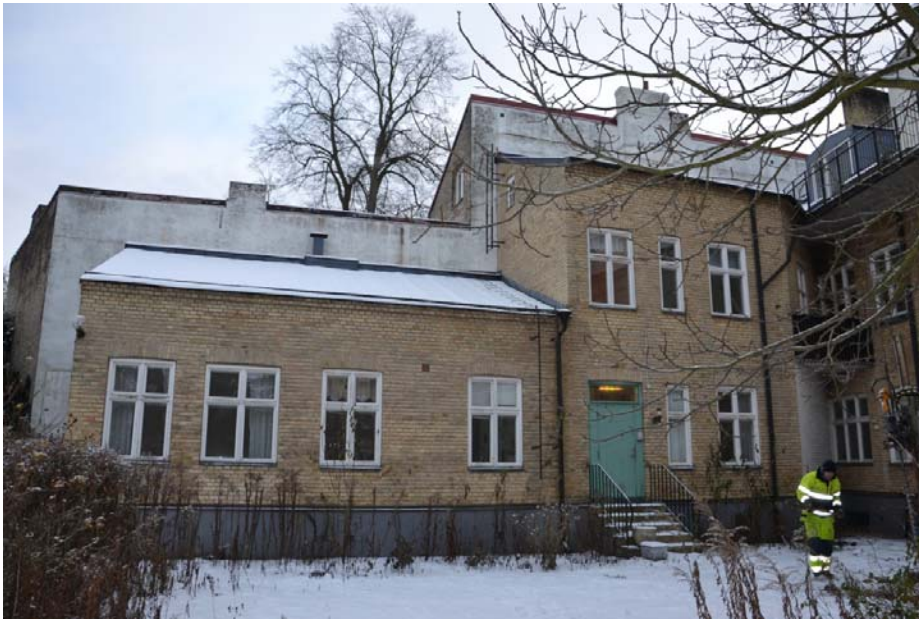
Figur 6. Kv Billegården 21, Lund. Det för rivning aktuella huset, från väster.
