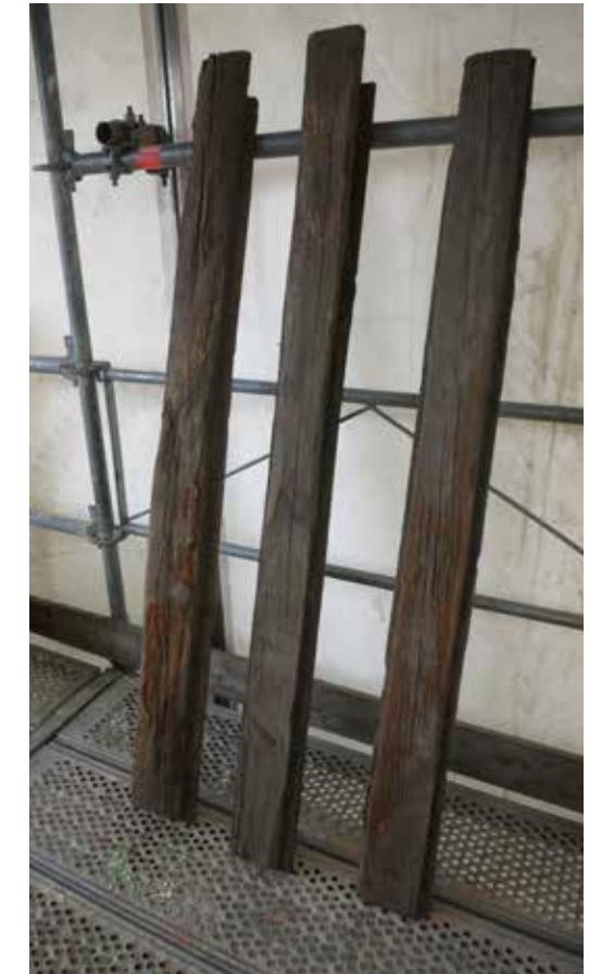
Äldre takbrädor som möjligen kan vara ursprungliga då deras ålder överensstämmer med stugans ålder, vilket fastställts genom dendrokronologisk analys. Foto Gunilla Gardelin.
