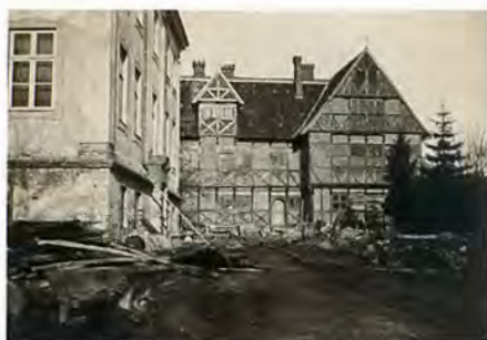
Borgarhuset under byggnad 1891.
