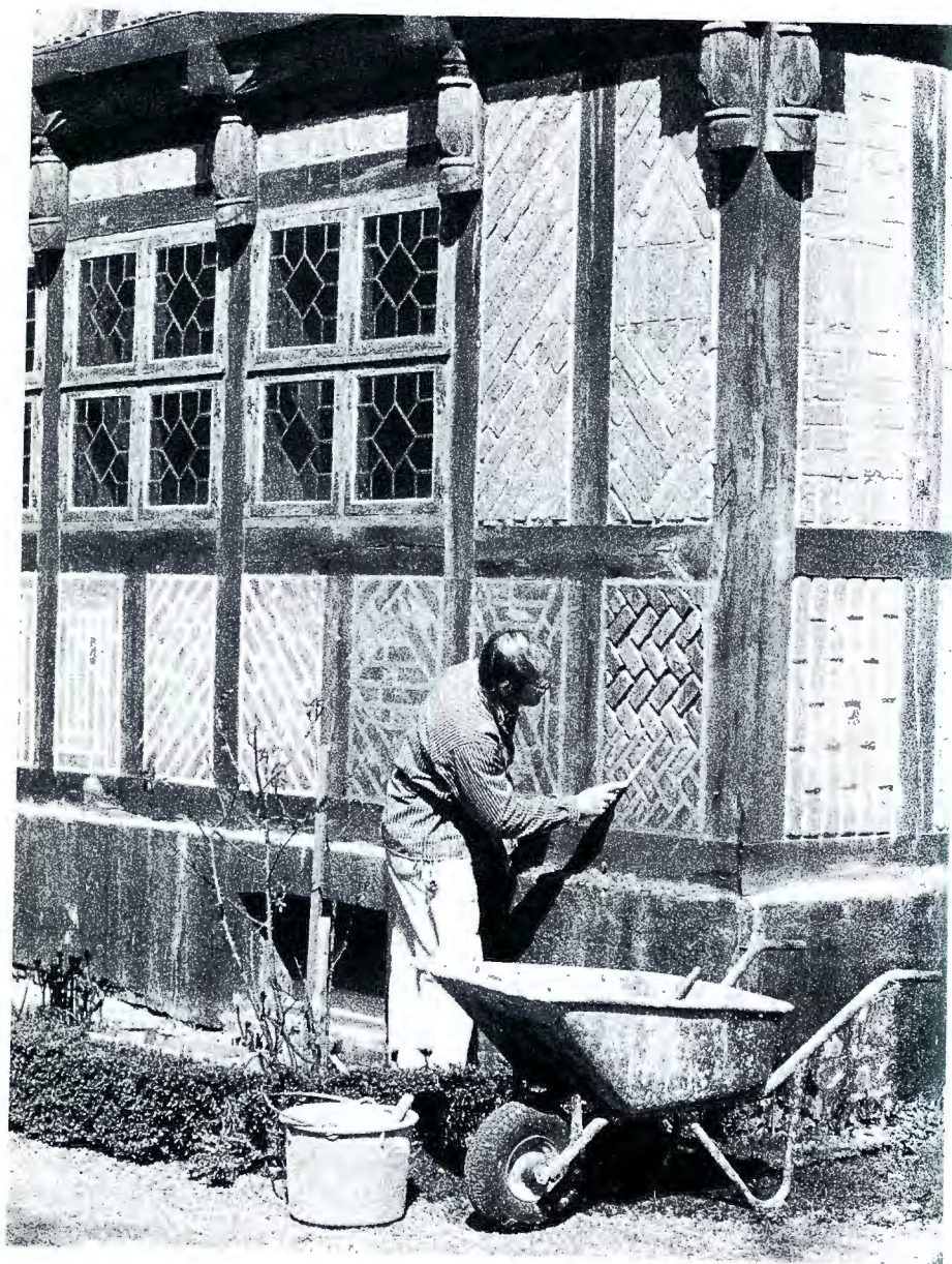
Hus och utställningar vittrar med åren ... Borgarhusets yttre under varsam renovering. Åke Johansson fogar om fasaderna, våren 1980.
