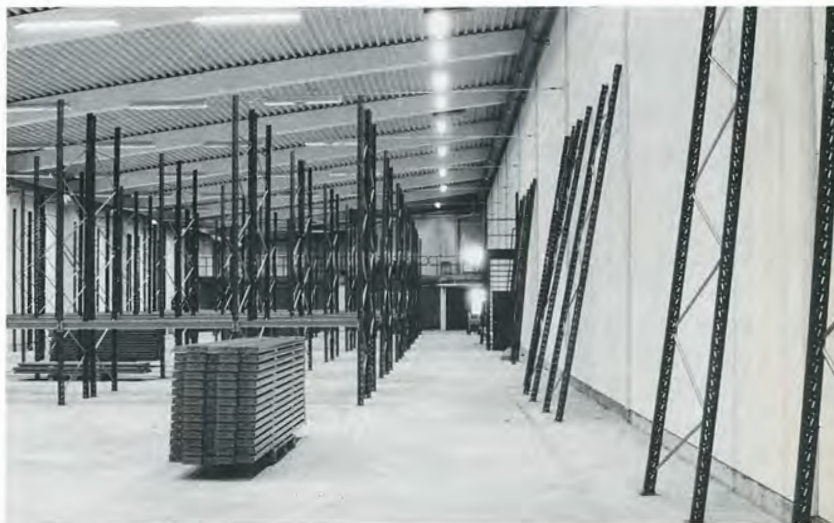
3. Montering av pallställ i höglagret.
