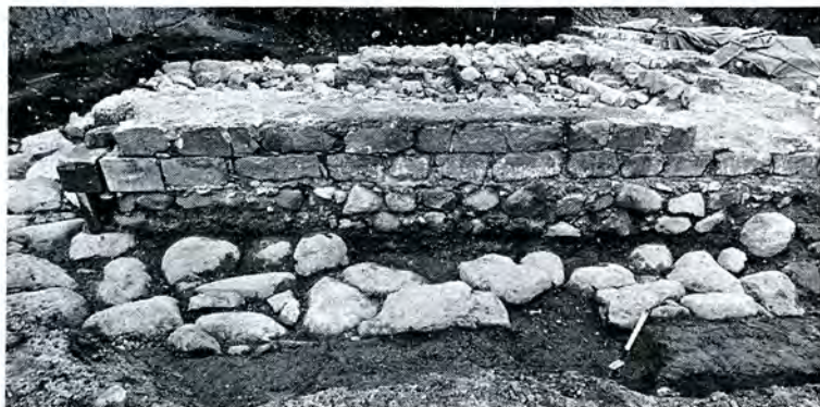
4. Södra tornmuren från senare delen av 1200-talet utgör ett exempel på de bäst bevarade delarna av kyrkans murverk. De stora stenarna i förgrunden är från kyrkans äldre byggnadsskeden. Foto R. Hedvall.
