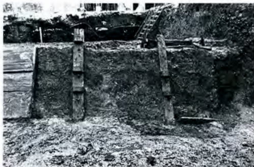
8. Två av de snedställda stolparna med uthuggna klackar. Såsom framgår av bilden är den högra stolpen neddriven i en medeltida avfallsgrop.
