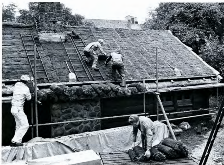
9. Kulturens hantverkare i färd med att lägga Onsjöstugans torvtak.
