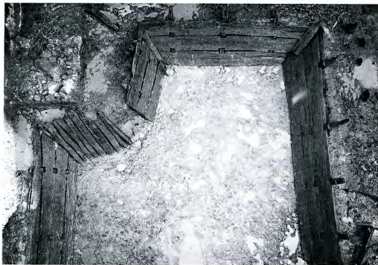
6. Fiskdammen sedd från luften.
