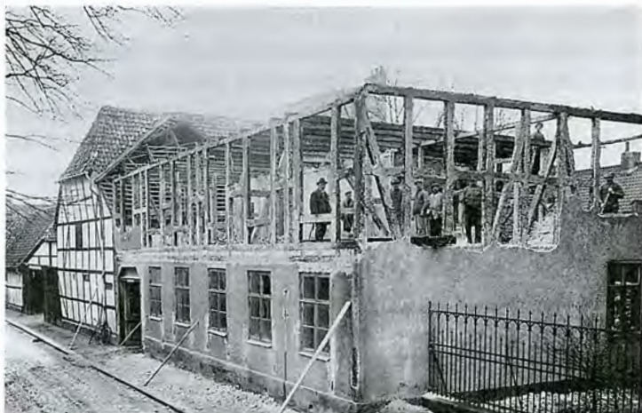
Arbetslaget med förmannen till vänster har ställt upp för fotografering under nedtagningen av Thomanderska huset. Kulturens arkiv.
