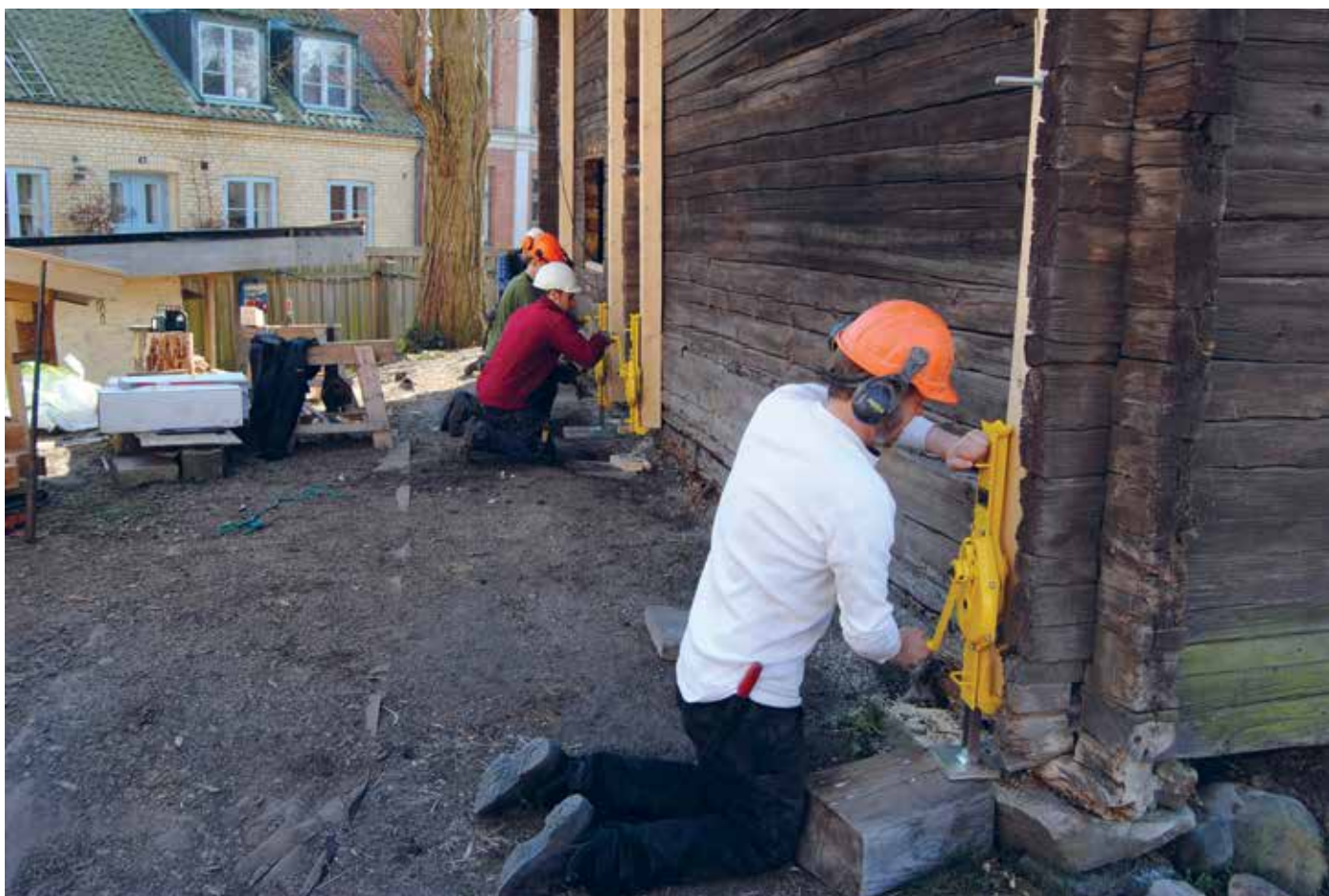
Under restaureringen av Måketorpsboden lyftes byggnadens försiktigt för att de nedersta skadade timmerlagren skulle kunna bytas ut. Foto: Gunilla Gardelin/Kulturen
