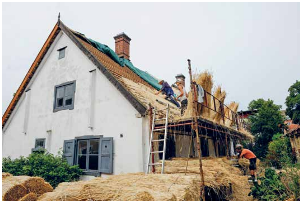
Restaurering i form av halmtackstäckning på Västra Vrams prästgård. Foto: Viveca Ohlsson/Kulturen
