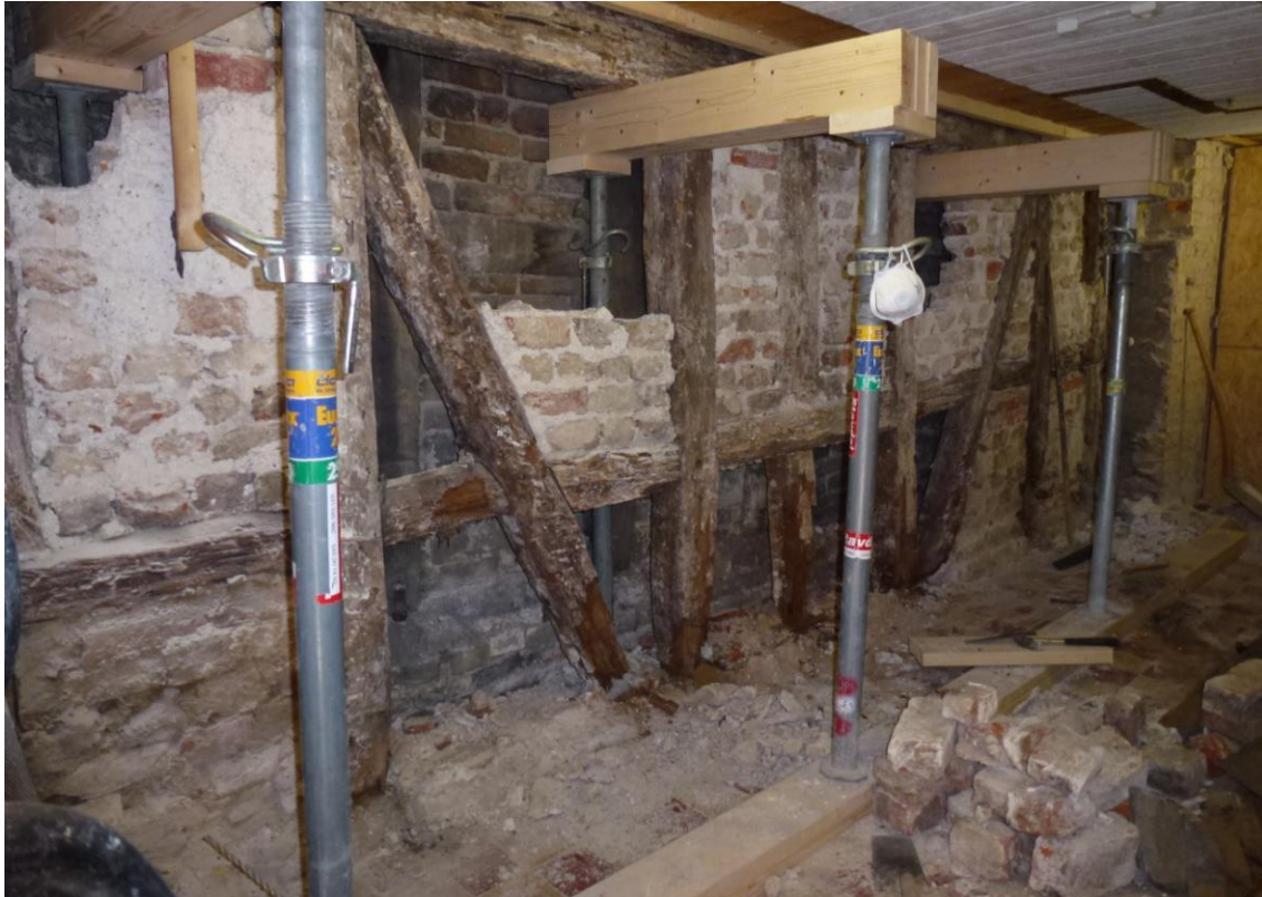
Figur 8. Under arbete. Lejden stämpades upp och fyllningarna i de under facken plockades ned samt i de övre för stämpningen. Eftersom stolparna var kraftigt rötskadade så sjönk de ner och släppte från lejden, varför man blev senare tvungen att även plocka ner de övre fyllningarna.
