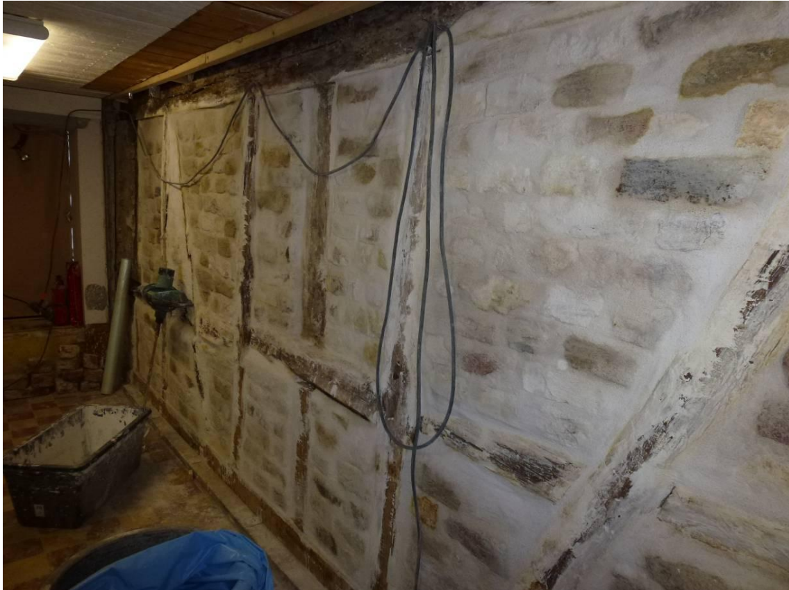
Figur 14. Efter åtgärder. Vy mot Kyrkogatan i öster.
