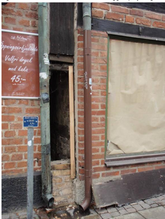
Figur 2. Fasaden vid Kyrkogatan. Mellan fastigheterna Glädjen 15 (till höger i bild) och Glädjen 4 finns ett smalt gatt om ca 40 cm. Gattet är täckt med bräder och en skiva som här plockats ner. Gattet rensades från jord och gammal puts för att jord inte ska ligga emot fotträet. Figur 3. Mellan glädjen 4 (till vänster) och Glädjen 15 (till höger) kan man se korsvirket och spritputsen längst till höger i bild.
