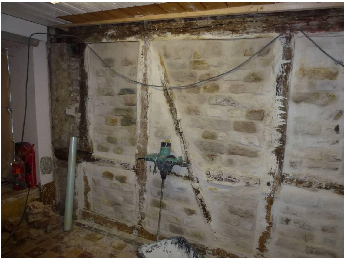
Figur 15. Efter åtgärder. Den östra delen av väggpartiet. Längst i öster är lersten bevarad.
