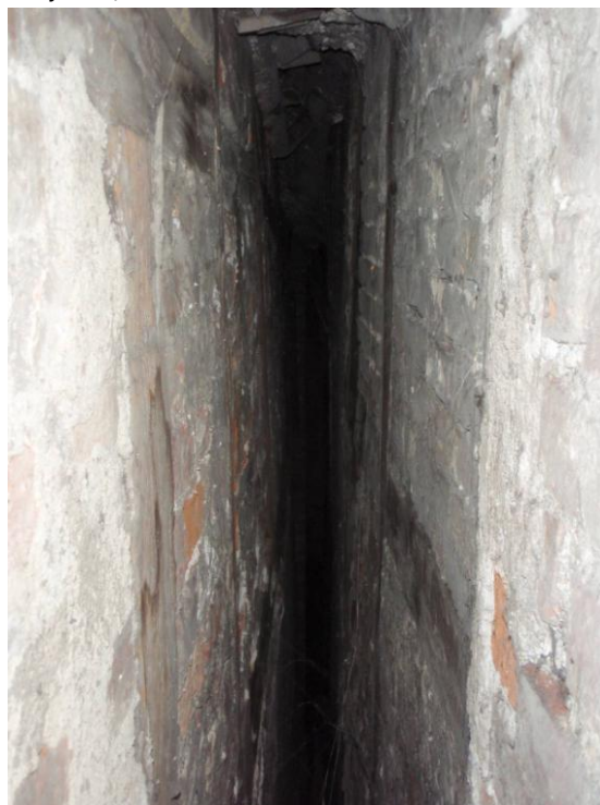
Figur 2. Fasaden vid Kyrkogatan. Mellan fastigheterna Glädjen 15 (till höger i bild) och Glädjen 4 finns ett smalt gatt om ca 40 cm. Gattet är täckt med bräder och en skiva som här plockats ner. Gattet rensades från jord och gammal puts för att jord inte ska ligga emot fotträet. Figur 3. Mellan glädjen 4 (till vänster) och Glädjen 15 (till höger) kan man se korsvirket och spritputsen längst till höger i bild.
