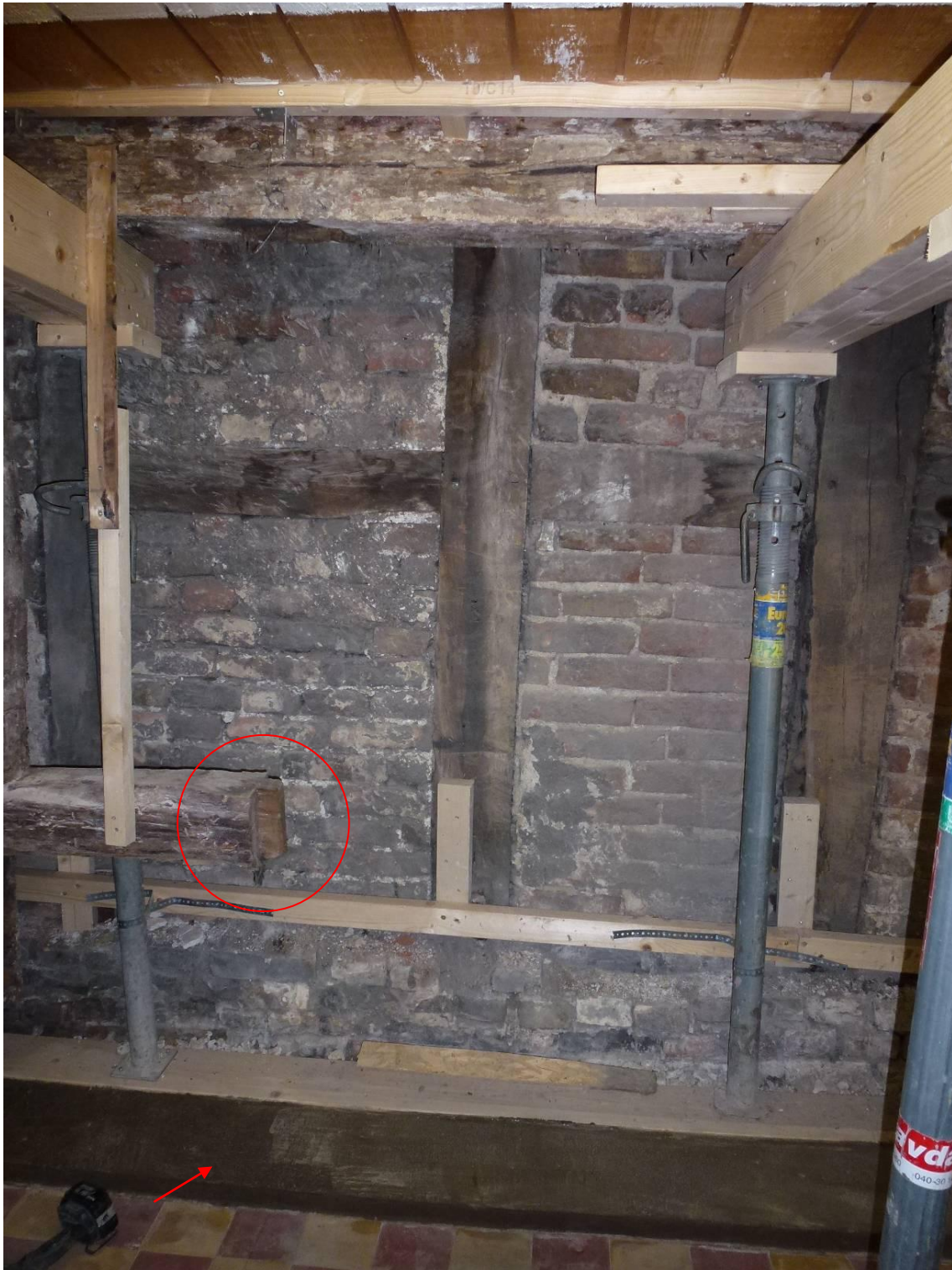
Figur 13. Här har hela korsvirkesväggen plockats ner förutom stolpe och löshult nr 0. Den nya grundsulan (markerad med pil) har gjutits. I löshulten till vänster i bild (inringad) ser man tappen för ifästning i stolpe 1:1. Den vägg man ser på bilden är ytterväggen, den norra gavelfasaden, på Glädjen 4 som ligger söder om Glädjen 15.
