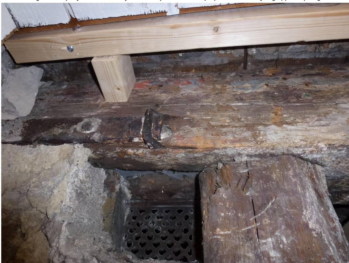
Figur 7. Under arbete. Detalj av korsvirke. I det sydöstra hörnet finns en ventil. Korsvirkesstolpen har sannolikt flyttats något västerut eftersom den inte är fäst med tapp i lejden och där ventilen sitter finns ett urtag för tapp. Observera färgspåren på lejden och takbrädorna.
