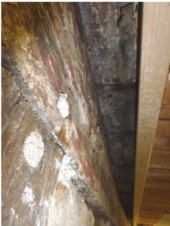
Figur 20. På bilden ser man en korsvirkesstolpe, lejden och takbrädor. Längst till höger i bild nyare tak som fanns i rummet. På lejden finns spår av röd slamfärg och ljust blå färg. Även takbrädorna har spår av färger i blåa nyanser.
