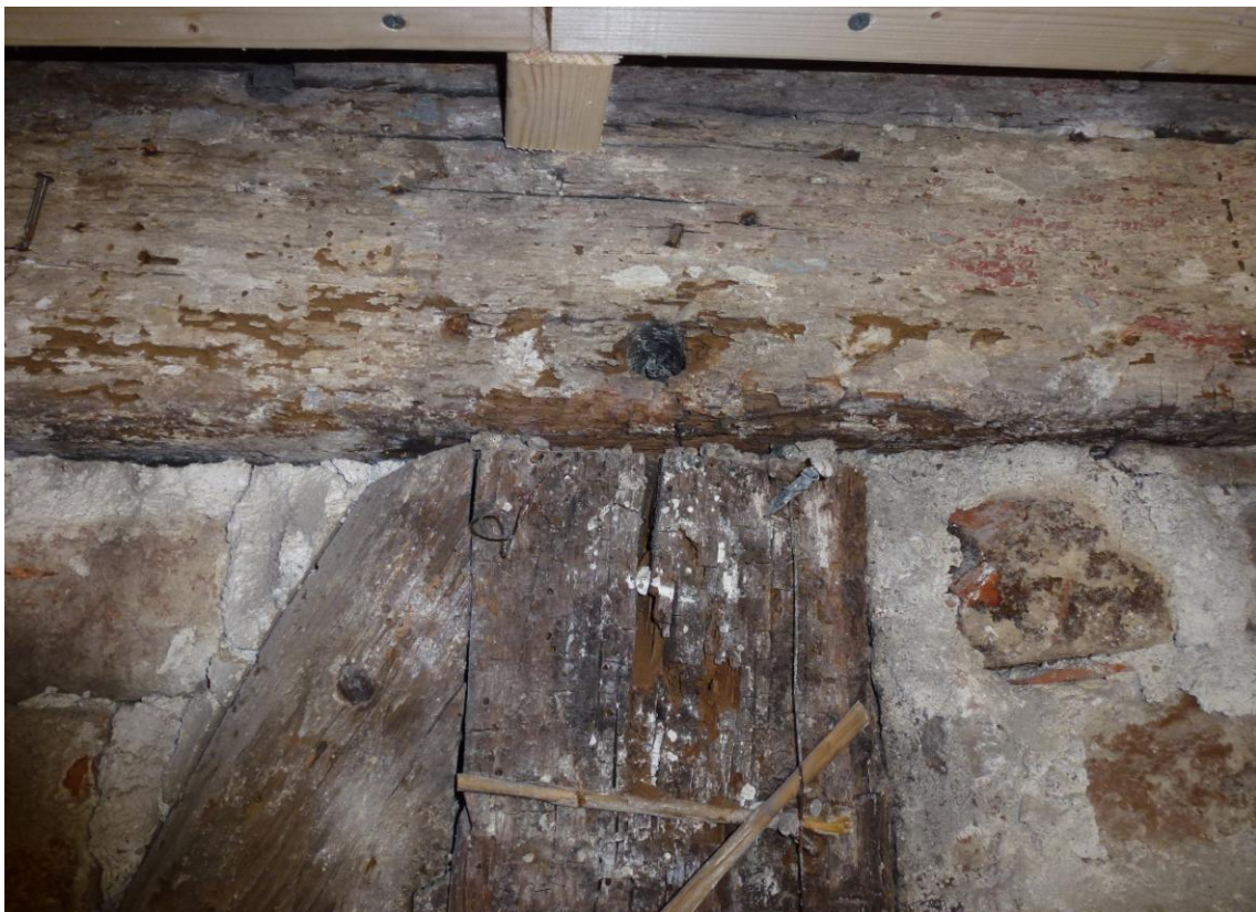
Figur 11. På några stolpar fanns reveteringsmatta i form av vass och ståltråd kvar.
