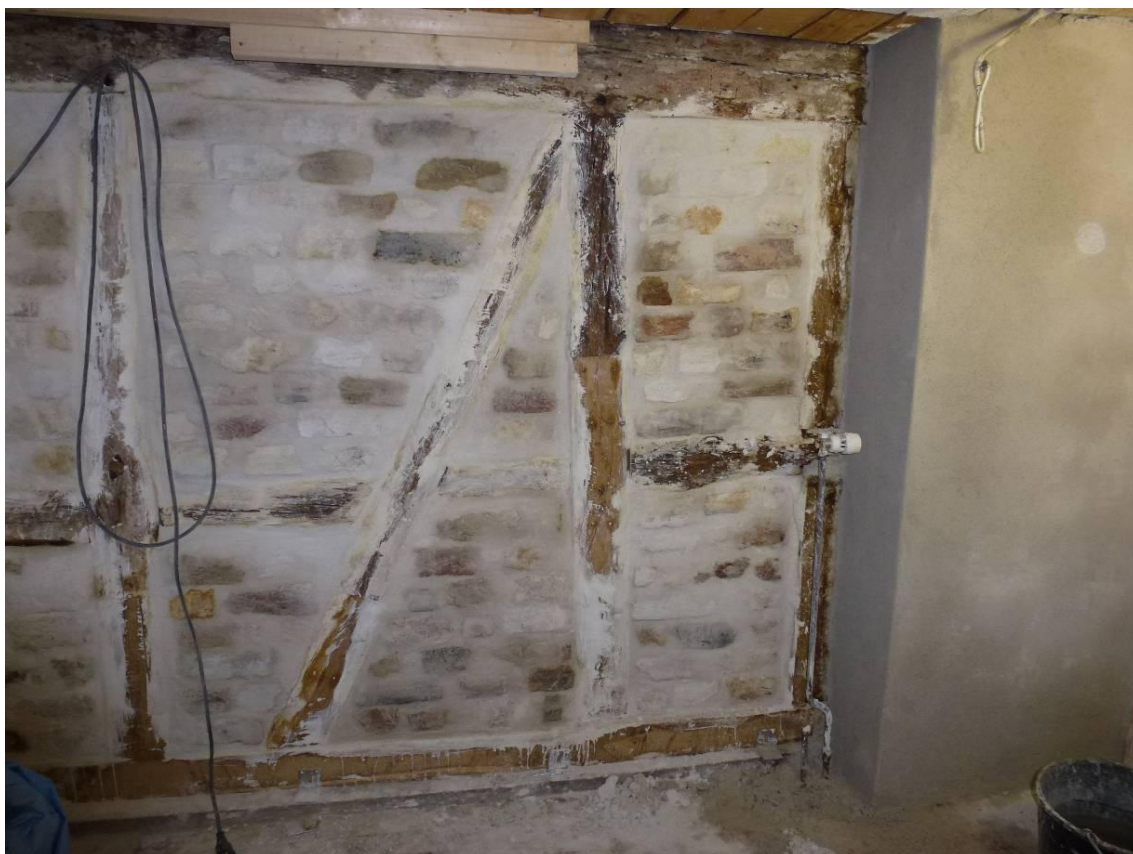
Figur 16. Efter åtgärder. Den västra delen av väggpartiet. Murstocken i tegel har också putsats.
