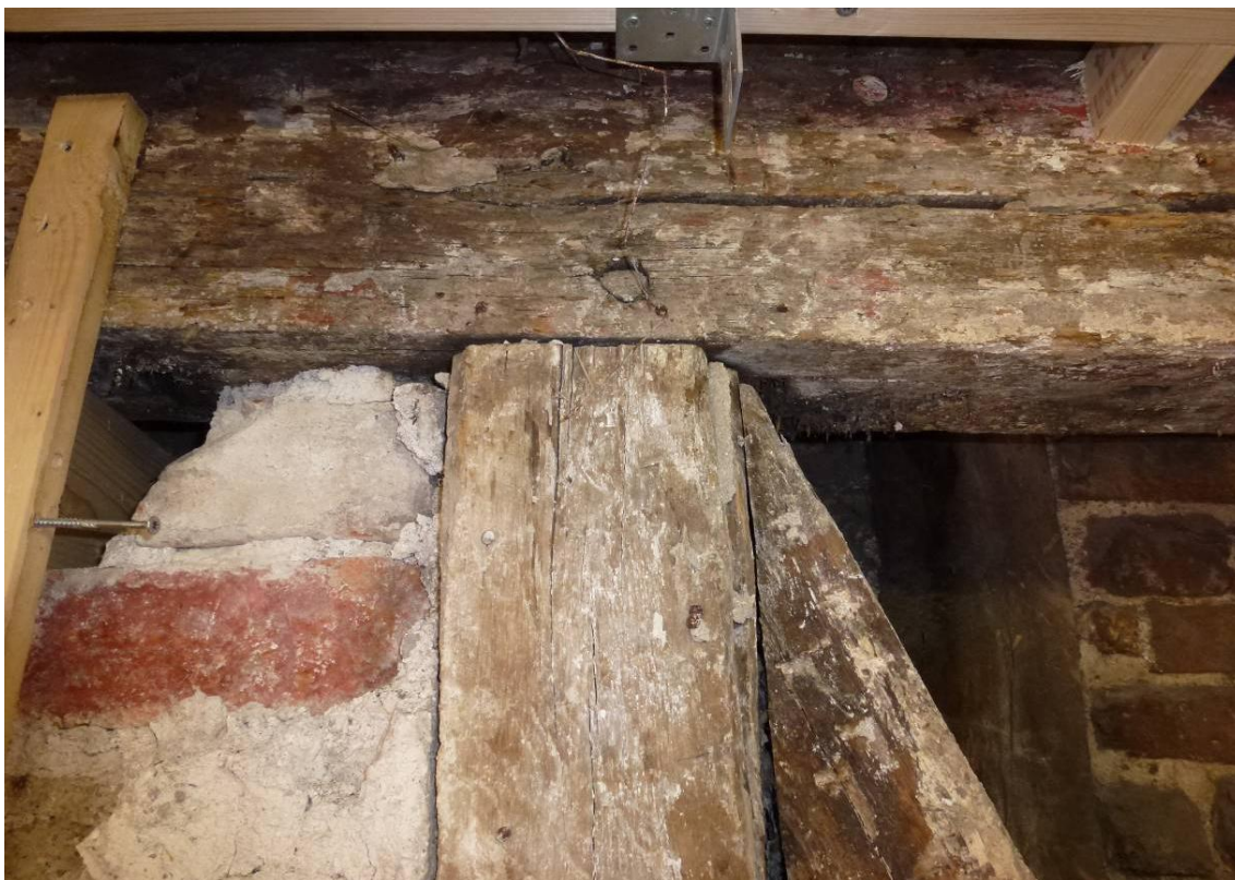
Figur 6. Under arbete. Detalj av korsvirket. Stolpen är fäst med tapp i lejden och dubb genom tappen (den runda tappen syns men de flesta var avruttnade). Observera den röda färgen på lejden och spår av papp samt kalk på virket. I bakgrunden syns fasaden av Glädjen 4. Det nya virket som synspå bilden är tillfällig uppstämpling.
