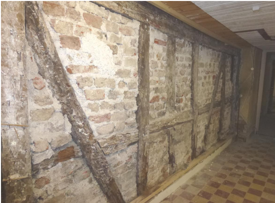
Figur 4. Före åtgärder, insidan av den aktuella väggen. Vy mot gården i väster. Huggspåren för puts är tydliga i stolparna, på stolpen längst till vänster i bild syns även spår av reveteringsmatta. På golvet fanns en sentida gjuten syll, den vita gjutningen som syns på bilden. Gjutningen togs bort.
