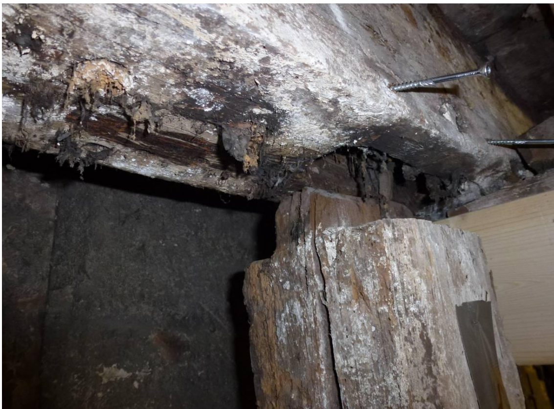
Figur 9. Bilden visar en stolpe med tapp som släppt från lejden. Till vänster i bild syns även hål och avbrutna lerstakar i lejden.
