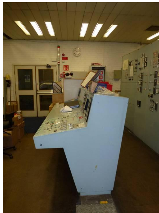
Interiör från pannhallen. Pelarstomme i betong med innerväggar mönstermurade med håltegel placerade så att de bildar ett mönster. Dörren är markerad genom en utkragande betongomfattning och glasbetong ger ljusgenomsläpp och lätt genomsiktighet. Till höger: Ursprungligt manöverbord från 1970-talet. Ny teknik har tillkommit.
