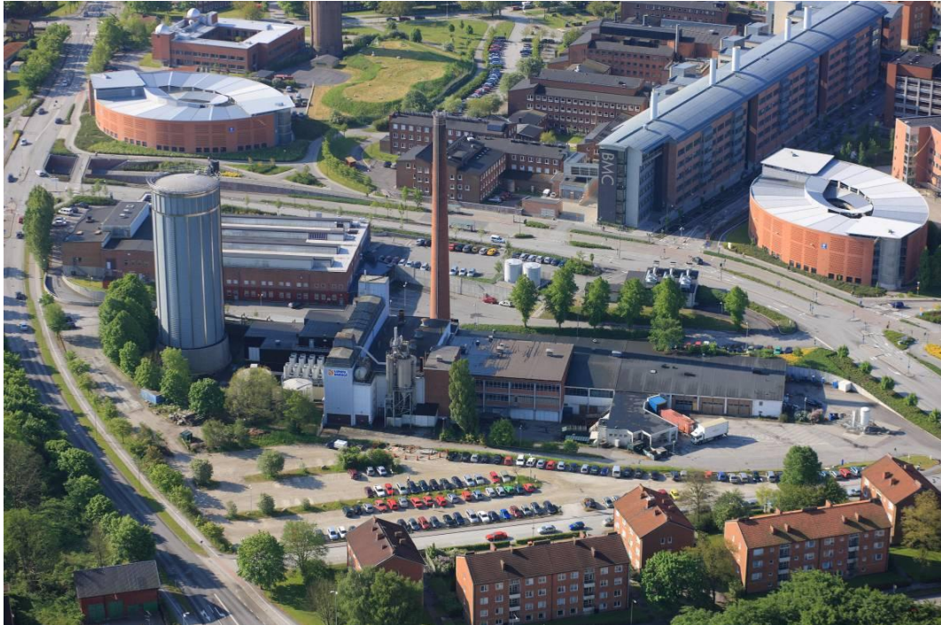
Foto: Kraftringen Produktion AB. Den höga skorstenen är en tydlig siluett i Lund från flera väderstreck när man blickar in mot staden samt när man befinner sig i staden. Öster är till vänster i bild.
