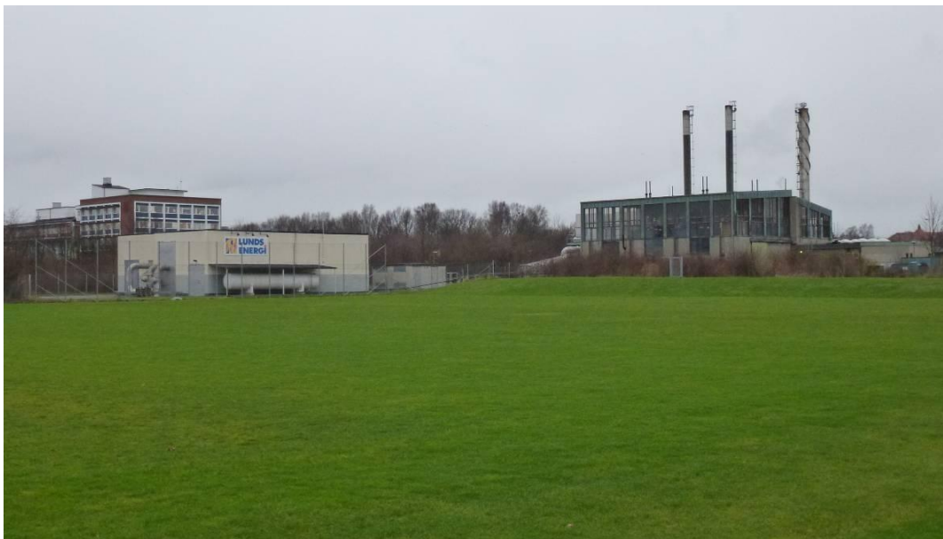
Värmepumpanläggning uppförd 1982. Till höger i bild värmeverket ritat av Hans Westman. Vy från Västanväg i söder.
