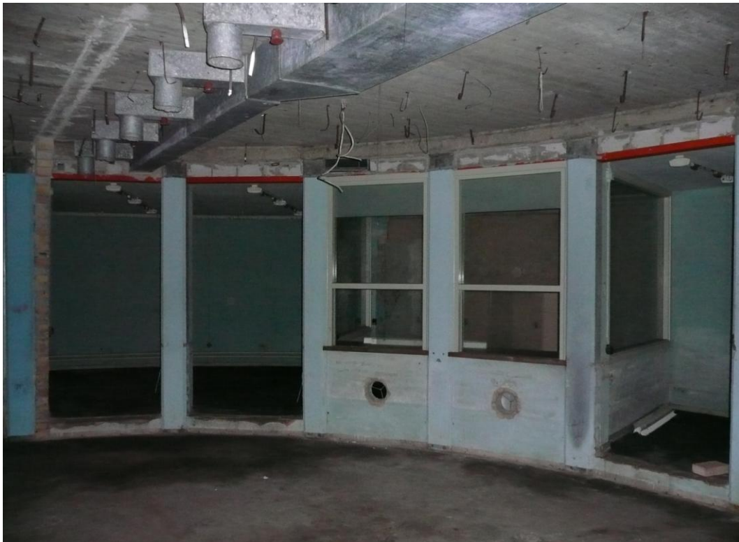
Ledningscentralen i Lund Interiör foto: Henrik Borg, Kulturen, 2009.
