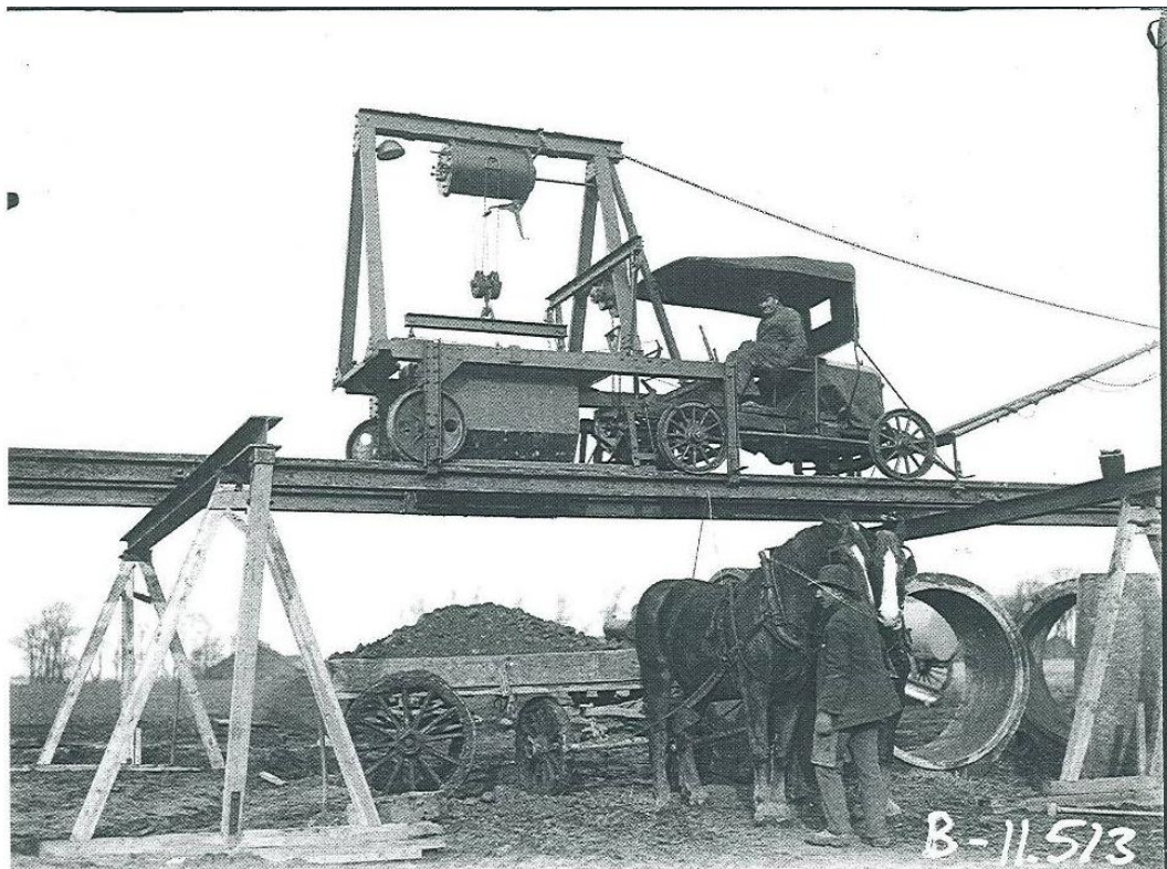
"Lund. Laggande av avloppsledning. Läggningsfordon sänker ner tippvagn." Foto E. Grothén, årtal okänt. Källa: Kulturen arkiv B-11.513.
