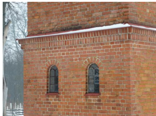
Toppeladugård transformatorstation. Dekorativ fasad med runbågiga spröjsade gjutjärnsfönster.
