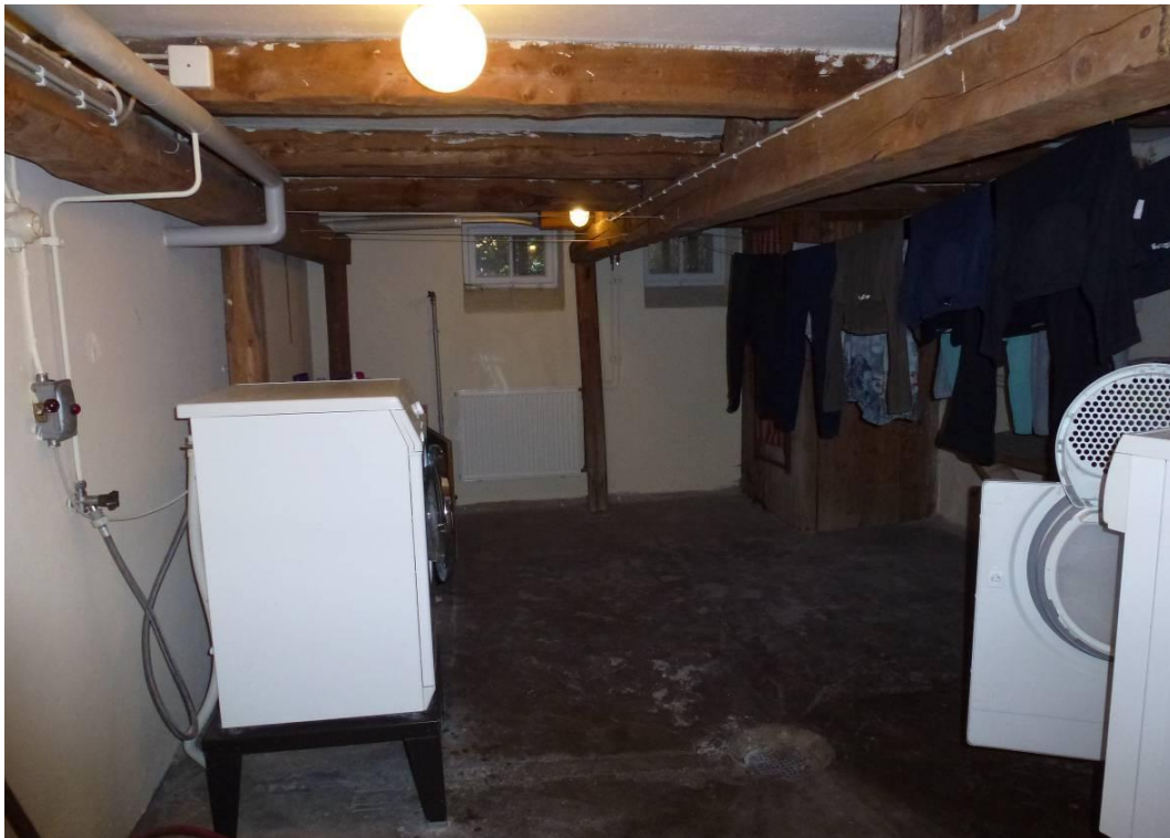
Magle Lilla Kyrkogata 17, Lund. Skyddsrum med förstärkt bjälklag från 1940. I det högra hörnet på bilden finns ett litet avskilt utrymme. Funktionen är okänd men en hypotes är att det var avsett som avträde. Till fönstren finns luckor i trä med en mjuk fog, för skydd och för att kunna stänga ut gas.
