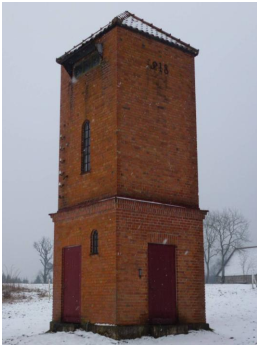
Toppeladugård transformatorstation. Dekorativ fasad med runbågiga spröjsade gjutjärnsfönster.
