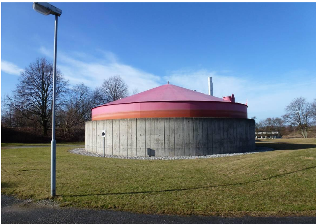
Gasklocka. Cylinderformad anläggning i betong och rödmålad plåt. Den röda färgen är vald för att ge ett traditionellt uttryck. Vid rötningen bildas biogas. Biogasen samlas upp och lagras i en såkallad gasklocka för att på så sätt utjämna de variationer i biogasproduktionen som kan förekomma. Den röda toppen kan röra sig flera meter i höjdled.
