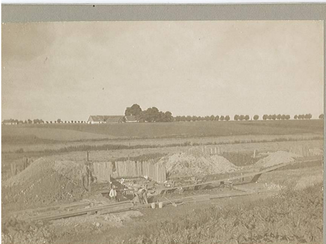
1906. Ovan: Vattenledningen passerar kloaken vid andelsmejeriet i Lund. Nedan: Schaktning för maskinhuset mitt på ängen rinner Höje å, i bakgrunden en gård tillhörande Flackarp. Inom den spåntade fyrkanten skall pumpbrunnen sänkas. Källa: Kulturens arkiv.
