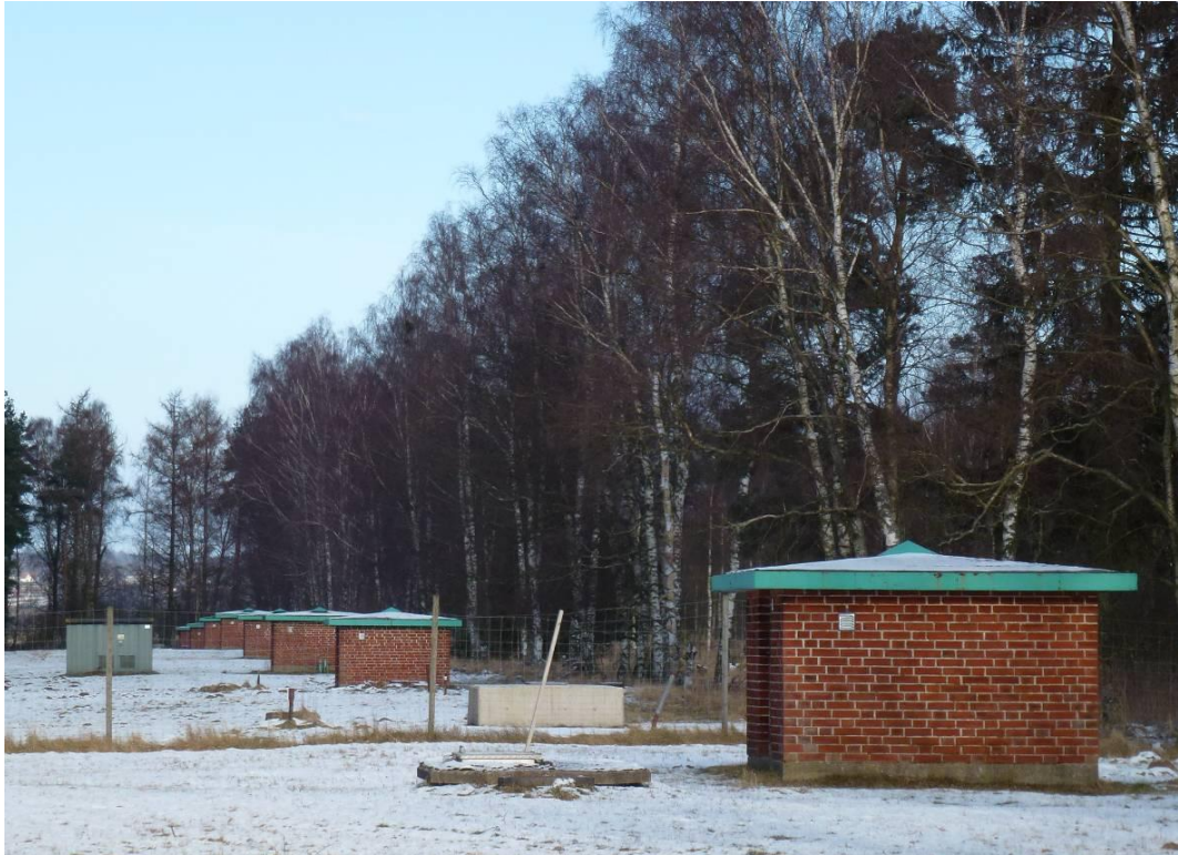
Vattenverket i Vomb. En rad med de första brunnarna med tegelfasader och grönmålade tak. En brunn är ersatt med en lägre överbyggnad i betong. Till vänster i bild finns en nätstation som ersatt en tidigare utomhustransformator.
