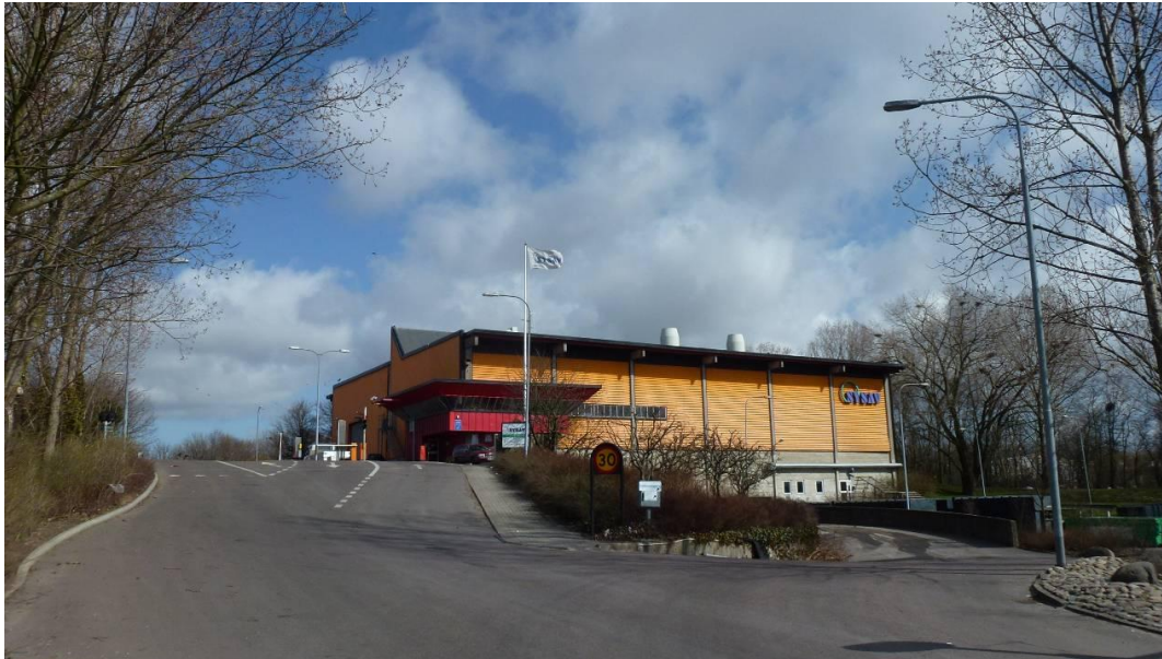
SYSAV avfallsstation. Byggnad ritad av Karl Koistinen arkitektkontor 1979.
