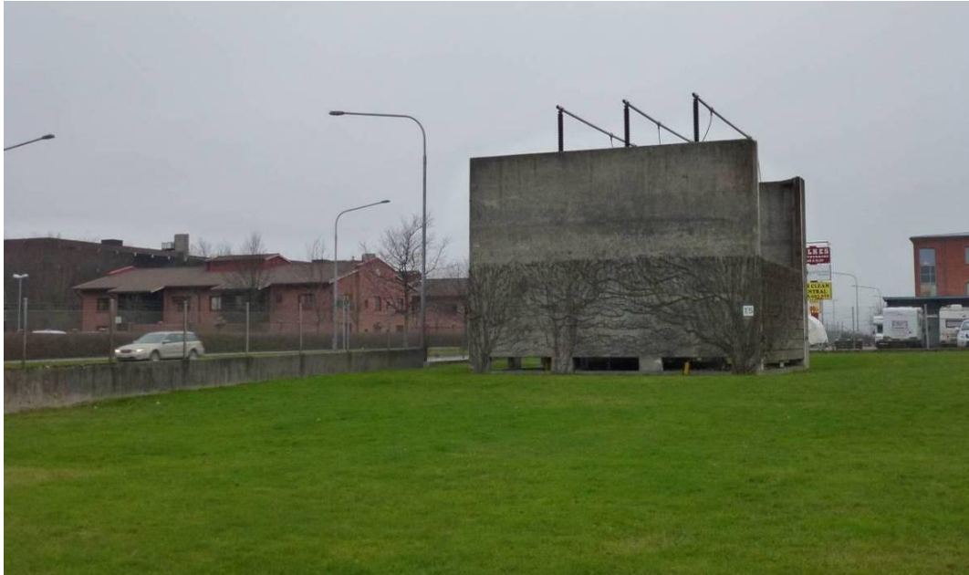
Ställverk med splitterskydd i betong. Betongblocken vilar på pelare. Delar av splitterskydden har återanvänts under staketet till vänster i bild.
