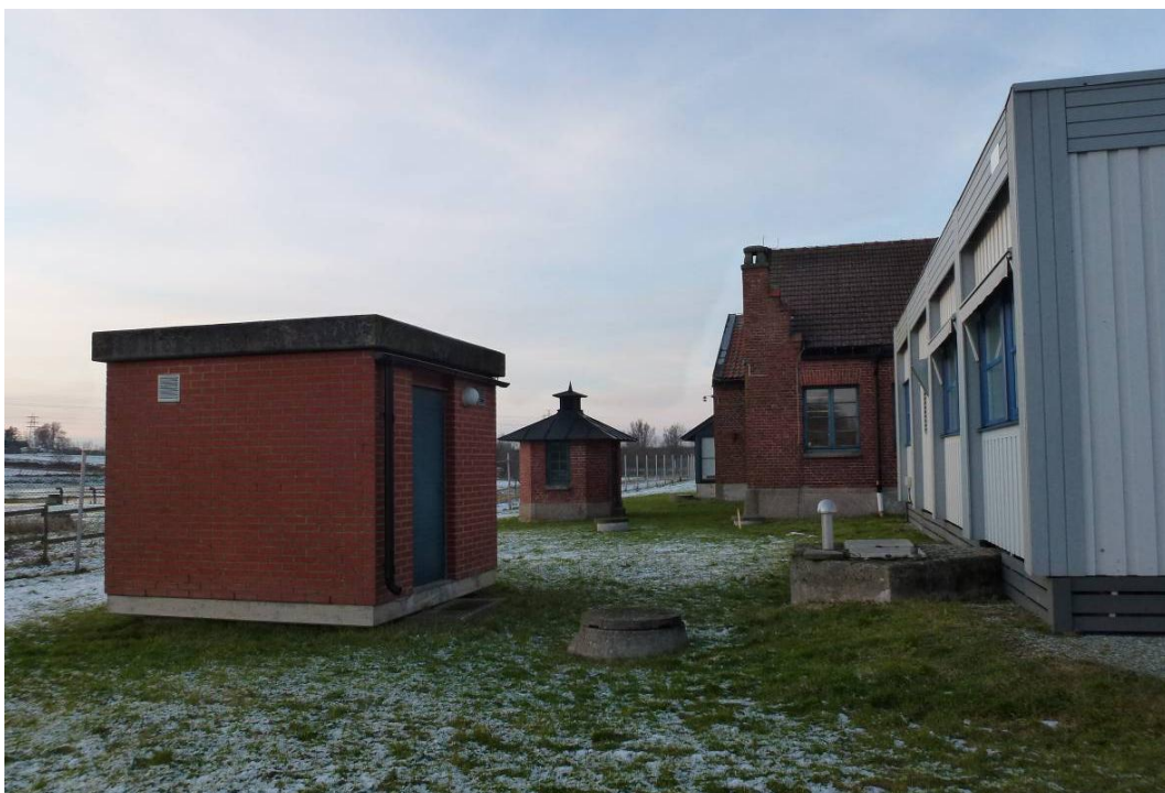
Källby vattenverk. Det mindre pumphuset med brunnshuset i fonden. Till höger i bild maskinhuset och en gråfärgad tillfällig barack med personalutrymmen.
