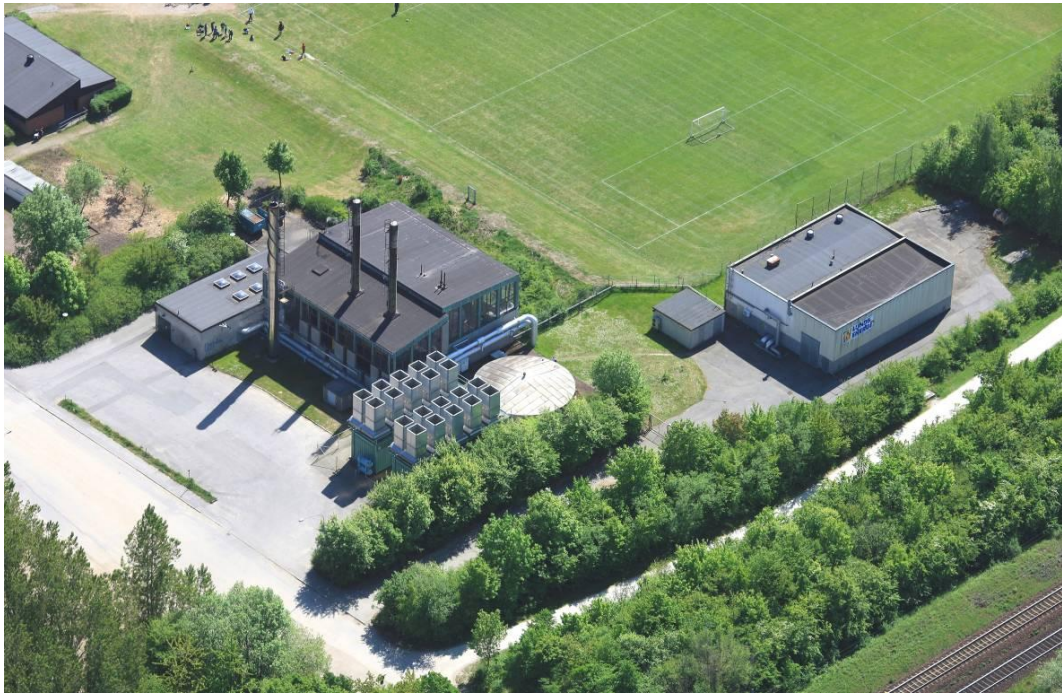
Foto: Krafttringen Produktion AB. Värmeverket ritat av Hans Westman till vänster i bild. Till höger i bild värmepumpanläggningen från 1982.
