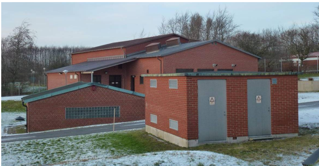
Källby vattenverk. I förgrunden nätstationen. I nivån nedanför vägen står pumpstationen med fönsterband i gaveln. I bakgrunden den stora tryckstegningsstationen från 1987, tillbyggd 1991 och senare.
