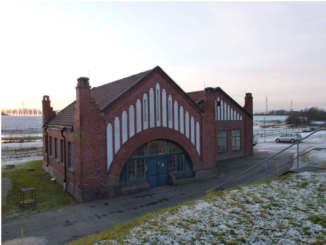
Källby vattenverk. Maskinhuset, bakom byggnaden rinner Höje å. Byggnaden är markerad som kulturhistoriskt värdefulla i Bevaringsprogrammet Lund utanför vallarna del II (s.145).
