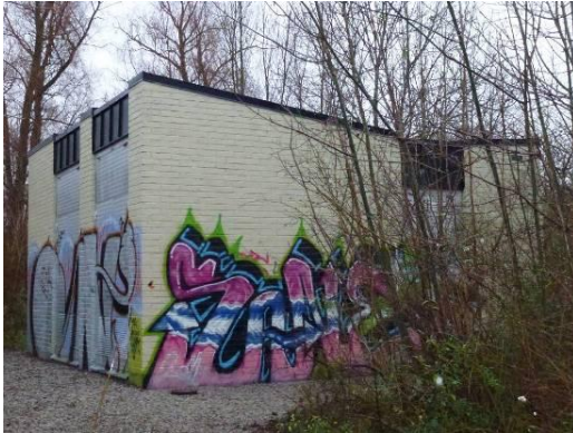
Till vänster: Thulehemsvägen, Mårtens Fälad, gult fasadtegel som målats ljusgult och motfallstak. Till höger: Klostergården, rödmålat tegel, motfallstak med taksarg och plåtskoningar i kopparplåt. Sockeln är klädd med Höganäsklinker. Även på Sunnaväg, Klostergården finns en nätstation i samma utförande.
