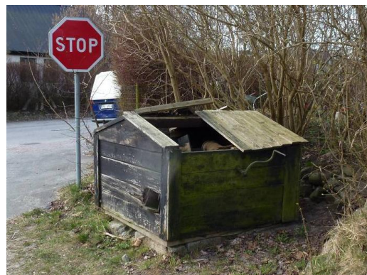
Till vänster: Tryckstegringsstation vid Dalby, Lundavägen. Till höger: Vattenbrunn i Torna Hällestad, Brunnsvägen/Byvägen. Vatten vevades upp i en hink. Vattnet hälldes genom rännan ut i den hink man bar med sig. Brunnen var i användning till 1950-talet, många i byn fick egen brunn på gården på 1940-talet. Byalaget planerar att restaurera eller rekonstruera brunnsöverbyggnaden. I byn har funnits tre brunnar av denna typ samt tre med hävstång.
