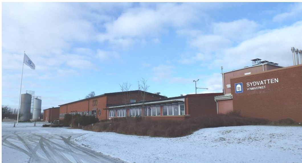
Vattenverket i Vomb. Maskinhusets ursprungliga del byggdes till under 1960-talet med den lägre delen till höger i bild.
