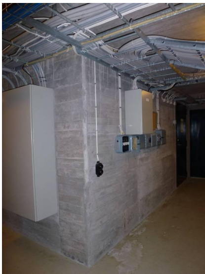
Interiören präglas av platsgjuten betong där gjutformens mönster av brädorna är synliga och tegel i rummen i markplan. Utrustning har flyttats under årens gång, av detta syns ofta spår i golv och tak.
