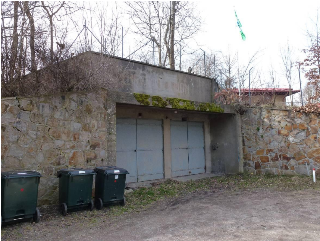
Brandstationen i Södra Sandby. Byggnaden är insprängd i marken. Väggar av gjuten betong och gråmålade ståldörrar. Ovan dörrarna går ännu att läsa Brandstation. Marken vid sidorna om stationen är murade i natursten med utskjutande fog.
