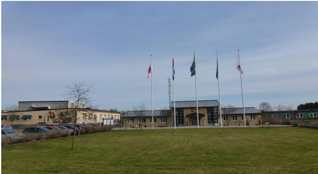
Entrébyggnaden vid MSB Revinge.
