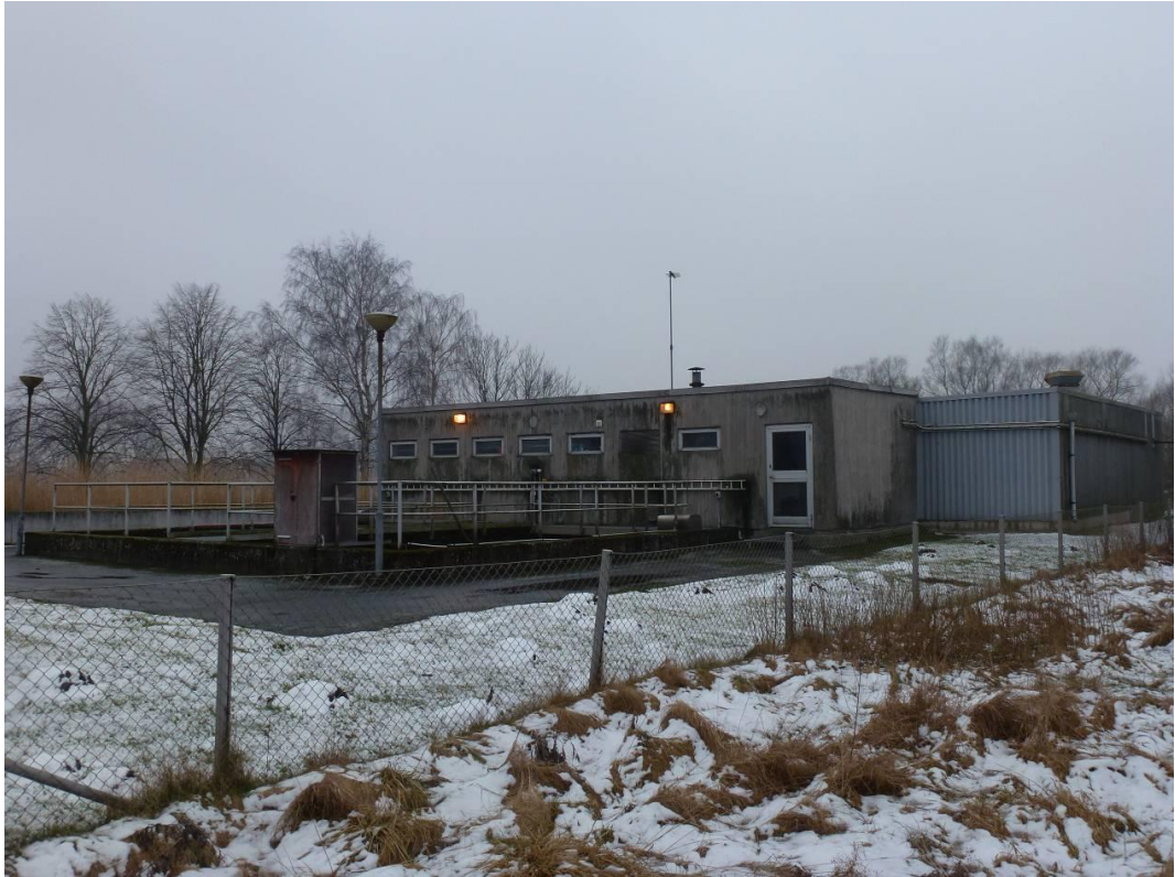
Reningsverket i Revinge, framför byggnaden finns bassängerna. Byggnad av betong med strama linjer och fönsterband.
