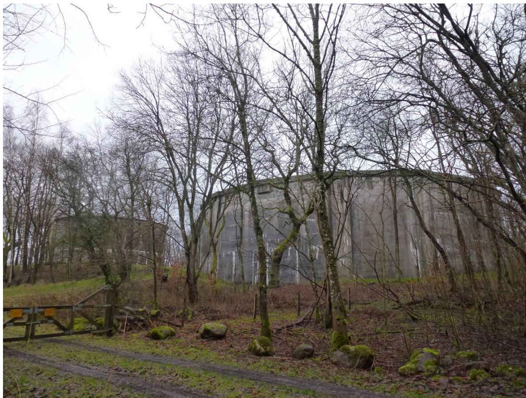
Vattenreservoarerna vid Norra Ugglarp. Den första reservoaren från 1948-1949 i bakgrunden.
