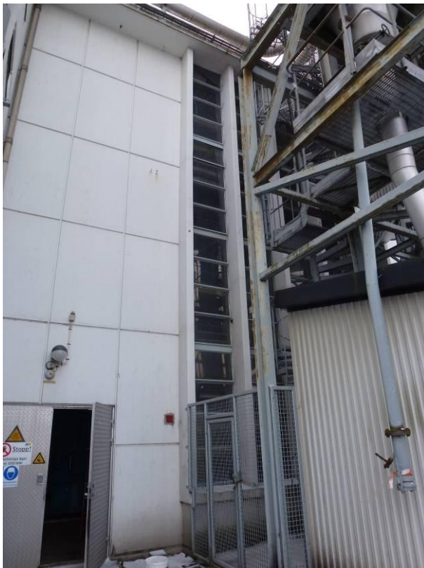
Den mellersta byggnadskroppen med höga vertikala fönsterband utvändigt inramade av utskjutande betongskivor.
