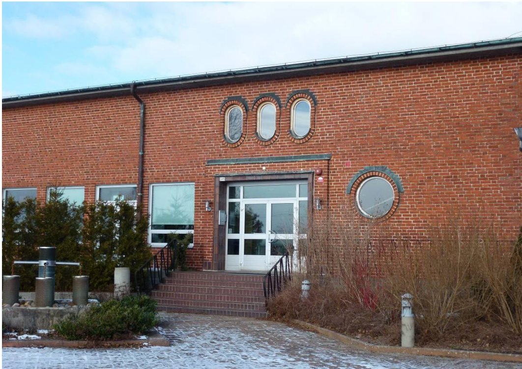
Vattenverket i Vomb. Huvudentrén är den ursprungliga entrén till Maskinhuset. Arkitekturen är typisk för sin tid med fina detaljer. Arkitekturen signalerar stolthet över den för tiden nya stora anläggningen. Fönster och dörrar är idag ersatta.
