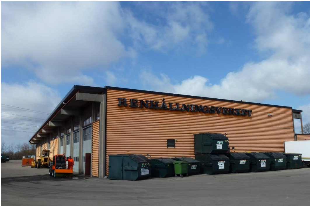
Byggnaden vid Lunds renhållningsverk är uppförd med pelarbalkar i betong och fasad av orange korrugerad plåt. En enkel funktionell och stilig byggnad.
