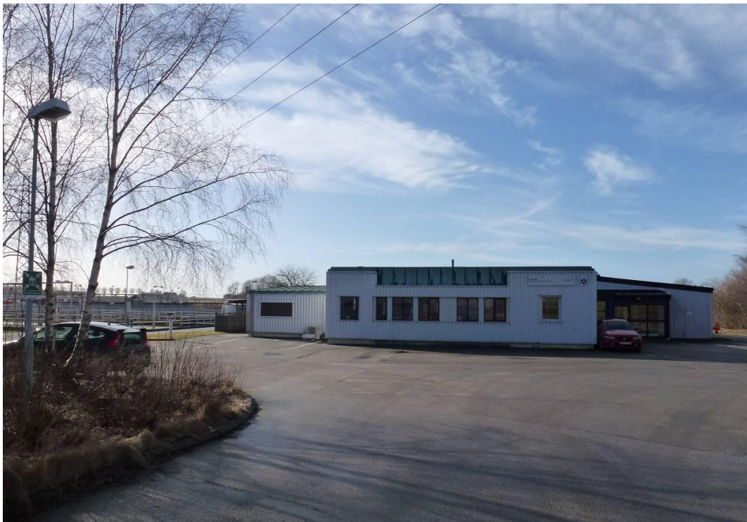
Huvudbyggnaden, kontoret. Den rektangulära delen som vänder sig mot inkörsporten är uppförd på 1940-talet med stomme i Siporexblock, taksarg och fönsterdetaljer i kopparplåt. Fasaderna är idag till stor del klädda med vit korrugerad plåt. Byggnaden har senare byggts till med en vinkelbyggd länga mot den befintliga byggnaden. I byggnaden finns fuktproblem och utredning pågår om byggnaden måste rivas. Till vänster i bild bassänger från 1960 och 1970-talen.
