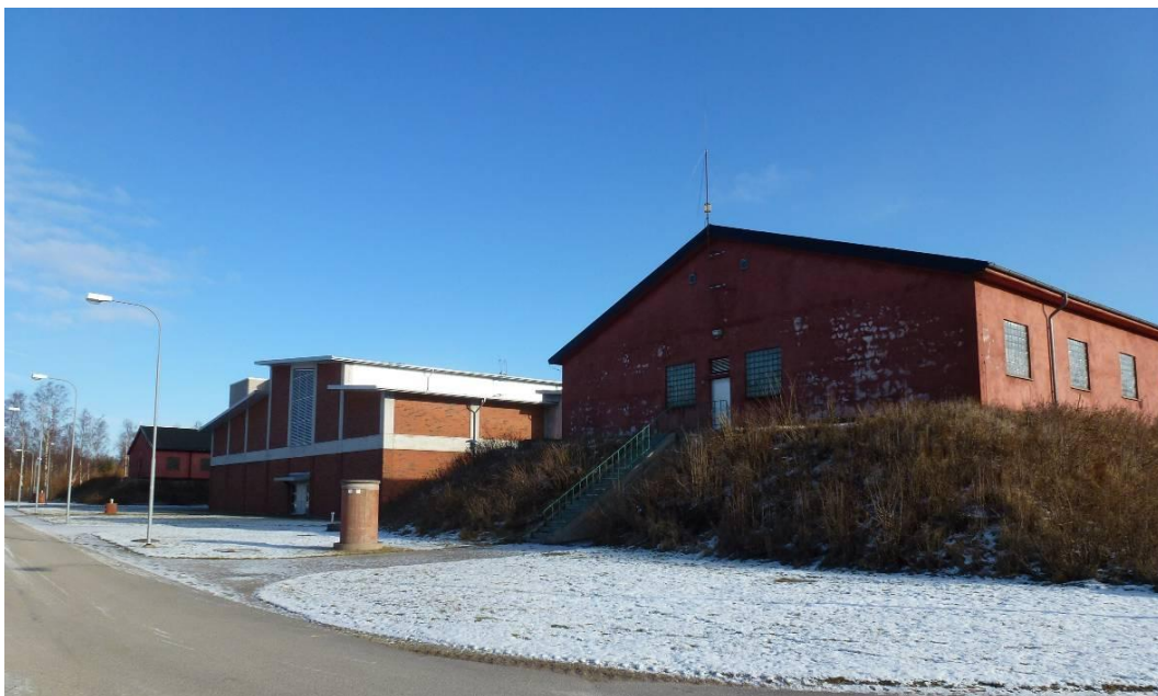
Vattenverket i Vomb. Från vänster i bild, den norra järnfilterbyggnaden, avhärdningsanläggningen och den södra järnfilterbyggnaden.
