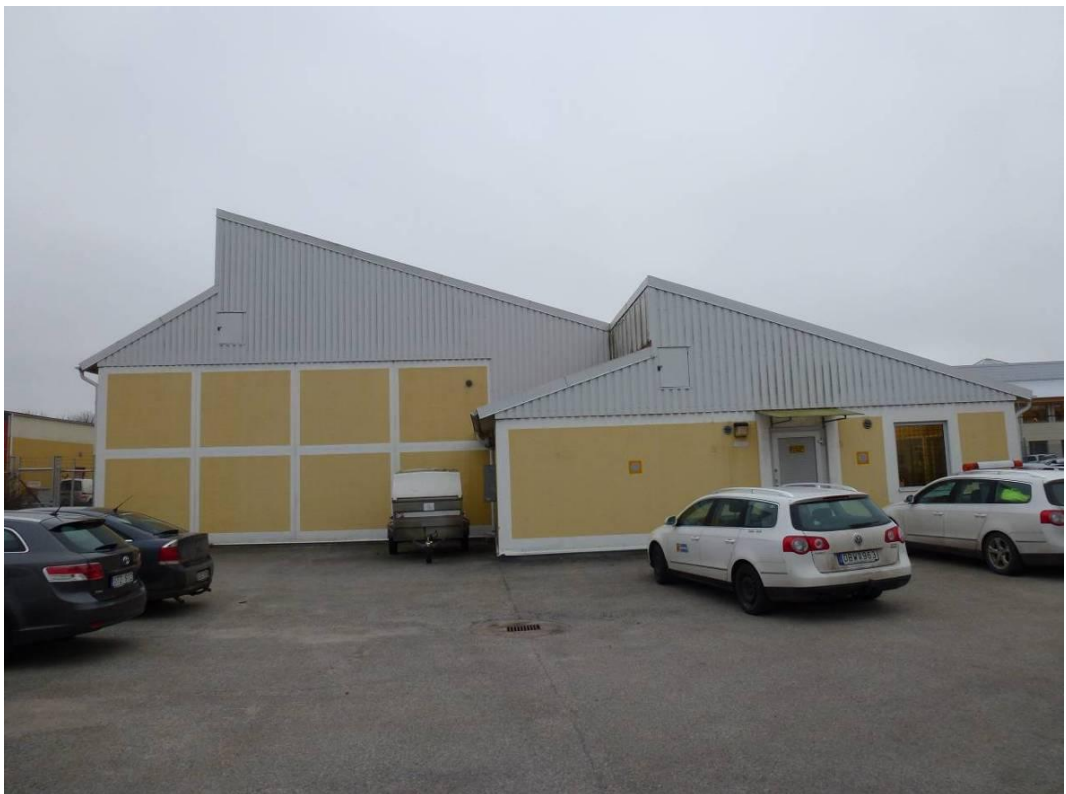
Södra mottagningsstationen Byggnaden uppfördes 1995. Här finns transformatorer och ställverk.
