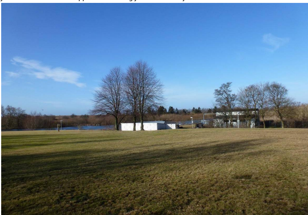
Området präglas av en tydlig parkkaraktär, vy mot nordost och Höje å. På bilden syns förrådsbyggnaden från 1920/30-talet samt kloranläggning från 1970-talet.
