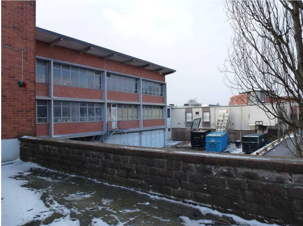
Naturstensmurar och den västra byggnaden. Byggnaden karaktäriseras av fasadtegel i kombination med utskjutande betonglistverk och fönsterband med tunna bågar samt den kraftigt utskjutande takfoten med synliga takbjälkar i betong.
