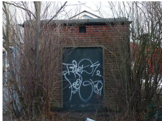
Till vänster: Ringvägen. Till höger: Åldermansgatan, Länsmannen 6. Denna nätstation har bevarad dörr. Teglet är rött räfflat, troligen Veberödstege.
