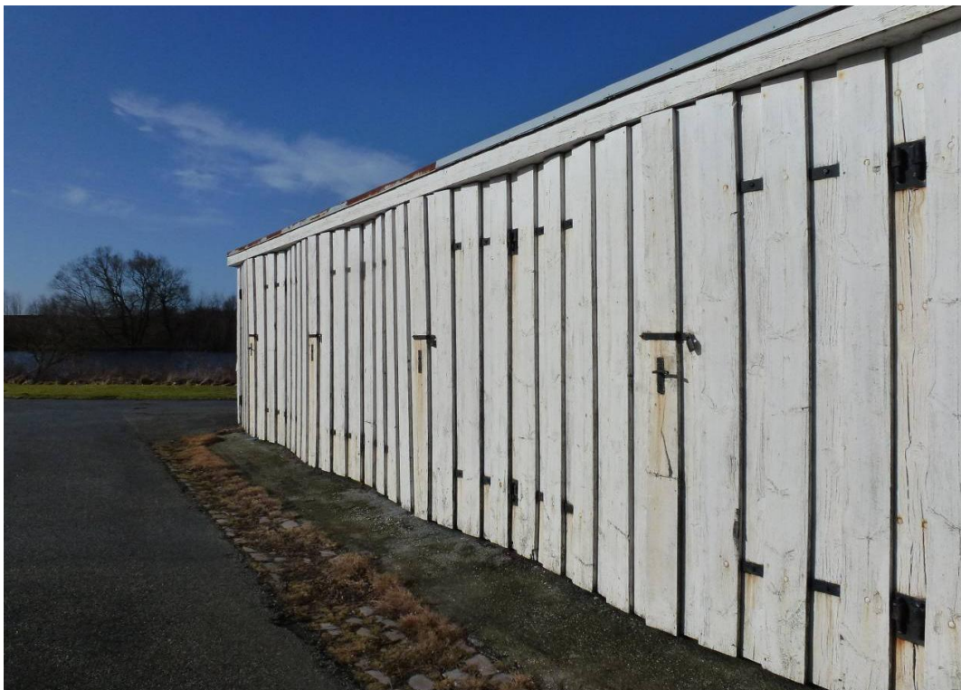
Förrådsbyggnaden från 1920/30-talet är klädd med kraftiga vitmålade cirkelsågade brädor. Portarna med bandgångjärn är noggrant snickrade. Byggnaden har en invändig stolpkonstruktion i trä samt pelare och I balkar i järn med en lyftanordning med en vajer. Invändigt finns även ett elaggregat, vilket inte är i funktion. Utanför löper en markränna lagd av kullersten. Byggnaden används som förråd men är något svåränvänd eftersom man inte kan köra in med dagens maskiner.
