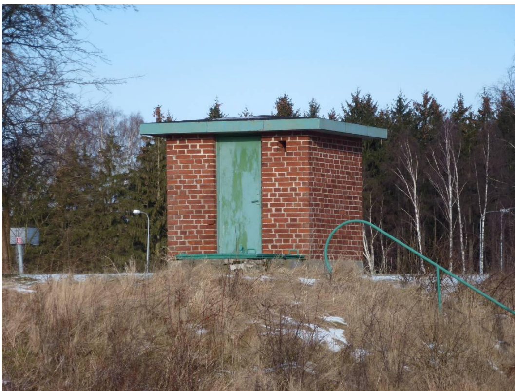
Vattenverket i Vomb. Lågreservoar och länspumpverk intill Maskinbyggnaden.
