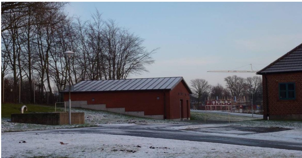
Källby vattenverk. Ventilkammaren, filterhuset skymtar till höger i bild.
