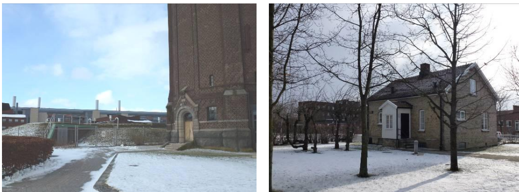
Markreservoarer vid gamla vattentornet. Till höger: Byggnaden uppfördes som tjänstebostad åt vaktmästaren
