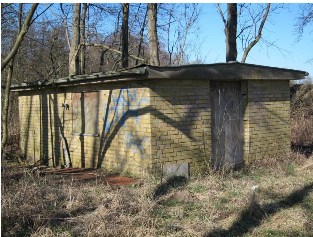
Pumphus vid sydvästra sidan av Rögle dammar. Byggnad i gult tegel med betongtak.
