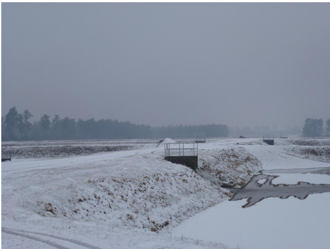
Infiltrationsdammar söder om vattenverket i Vomb.
