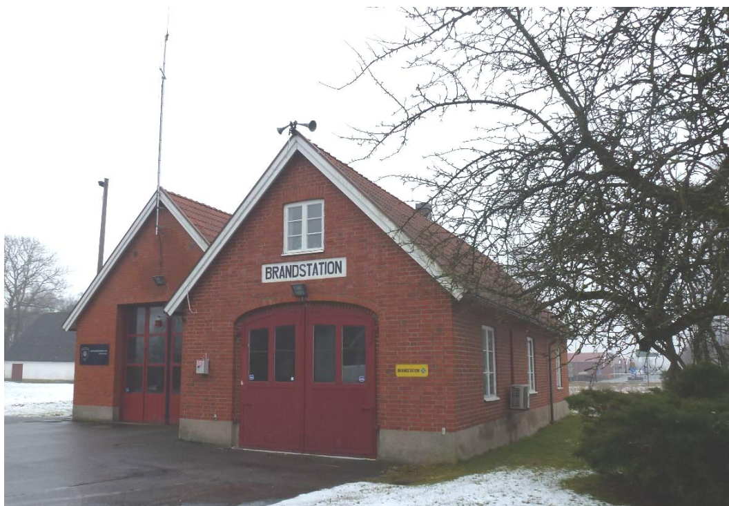
Revinge brandstation, den ursprungliga delen till höger i bild.
