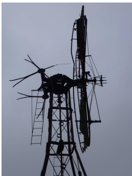
Vindturbin, Svarta hål, Revingehed. Vindturbinen är uppförd i järn med bultade infästningar. Från vindhjulet har många av skivorna i trä ramlat ner.
