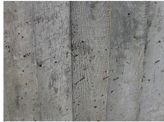
Till vänster: Vattenreservoarerna vid Norra Ugglarp. Den första reservoaren från 1948-1949 till vänster i bild. Till höger: Gjutformens bräddor ger mönster i betongen.
