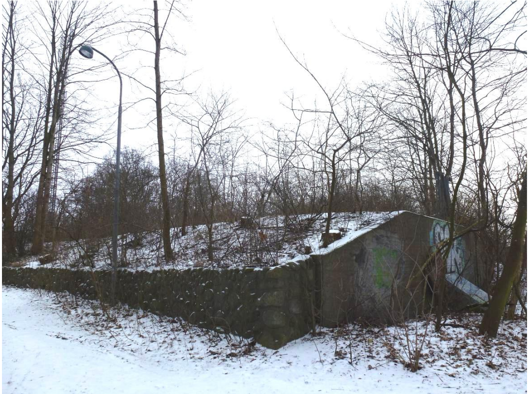
Ledningscentralen i Lund. Vy från sydväst.
