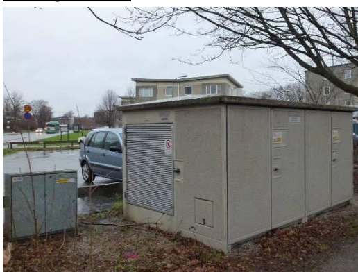
Till vänster: Råbyvägen. Nätstation i betongelement med tak av betongplatta. Kabelskåp till vänster i bild. Till höger: Sankt Petri Kyrkogata, intill folkbiblioteket. Betongstomme med plant tak. I stadskärnan har nätstationer målats gröna och klätts in med en pergola och växter för att inte ta en dominerande plats i kulturmiljön.
