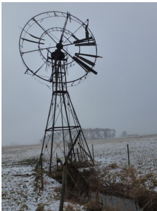
Vindturbin, Svarta hål, Revingehed. Vindturbinen är uppförd i järn med bultade infästningar. Från vindhjulet har många av skivorna i trä ramlat ner.
