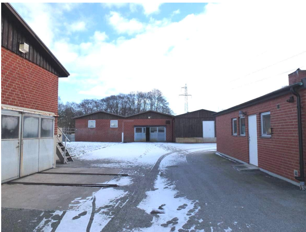
Veberöds reningsverk. Byggnaderna i rött tegel vilket är vanligt i Veberöd.
