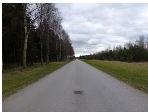
Till vänster: Längs med vattenledningen från Vomb mot Malmö och Lund finns många betongbrunnar på åkerarna. Till höger: Ängvägen leder fram till vattenverket, körbanan har fall mot mitten där det finns rännstensbrunnar med jämna mellanrum .
