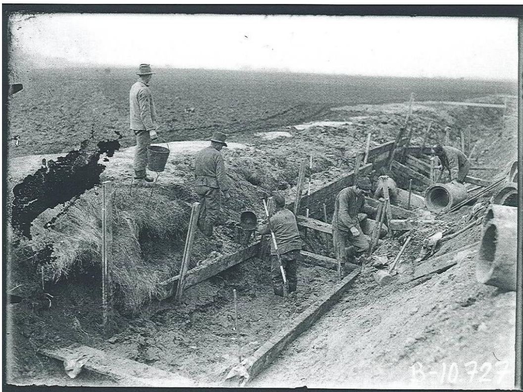
"Lund. Laggning av avloppsledning. Tätning av kulvertrör." Foto E. Grothén, årtal okänt. Källa: Kulturen arkiv B-10.727.
