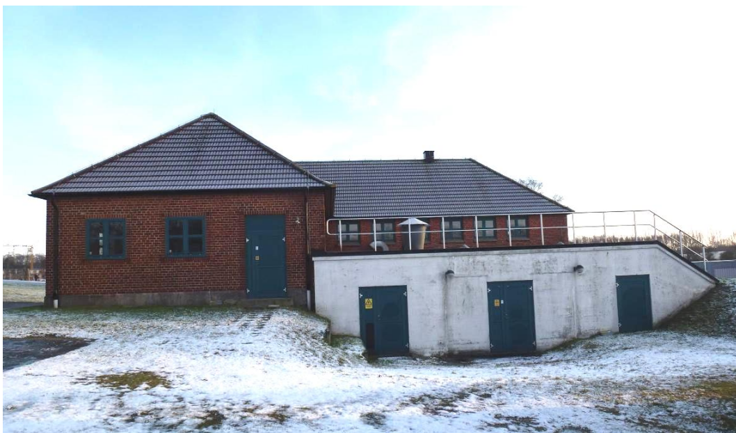
Källby vattenverk. Filterhuset. Byggnaden är markerad som kulturhistoriskt värdefulla i Bevaringsprogrammet Lund utanför vallarna del II (s.145).
