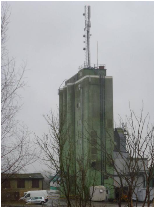
Mast på silon i Dalby.
