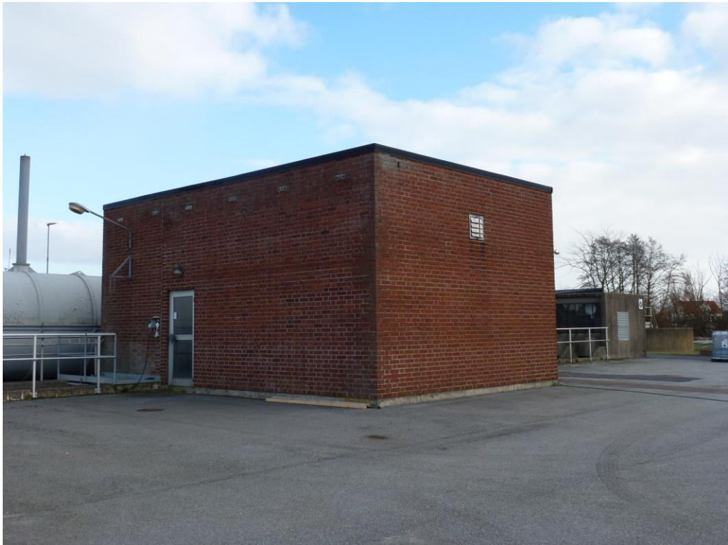
Södra Sandby reningsverk. Gasklockan. Till vänster i bild, byggnad för inkommande och i bakgrunden reservkraft.
