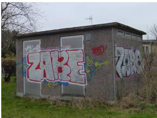
Till vänster: Lingonstigen. Stomme av betongelement med yta av sjösten. Flackt tak av betongelement. Interiör utrustning bevarad. Till höger: Drottensgatan. Fasaden är målad.
