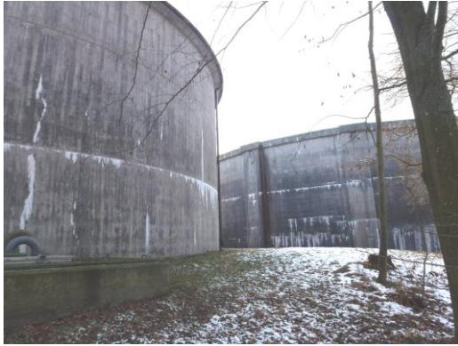
Till vänster: Vattenreservoarerna vid Norra Ugglarp. Den första reservoaren från 1948-1949 till vänster i bild. Till höger: Gjutformens bräddor ger mönster i betongen.
