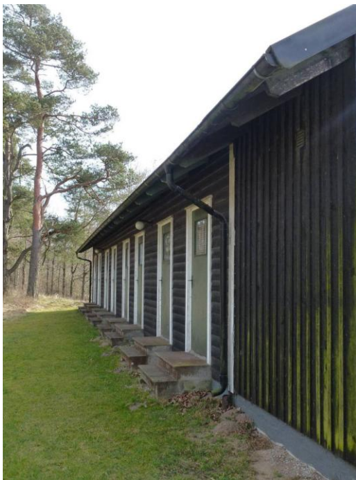
Gästlänga uppförd 1942 av arbetarkvinnorna. Den rymmer åtta sovrum med plats för ca 15 personer. Här finns inte värme men i varje rum finns en porslinsvask. Byggnad i brun liggande panel, delvis i locklistpanel, med pappklätt tak och grönmålade dörrar i skivmaterial. Framför varje dörr en cementtrappa.
