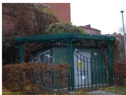
Till vänster: Råbyvägen. Nätstation i betongelement med tak av betongplatta. Kabelskåp till vänster i bild. Till höger: Sankt Petri Kyrkogata, intill folkbiblioteket. Betongstomme med plant tak. I stadskärnan har nätstationer målats gröna och klätts in med en pergola och växter för att inte ta en dominerande plats i kulturmiljön.
