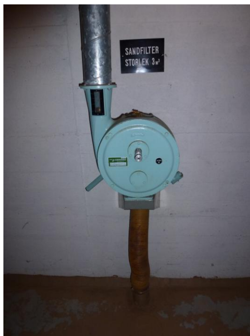
Skyddsrum från 1960-talet med den obligatoriska skylten vid ingången samt kombinerat el/handdrivet ventilationsaggregat. Tordönsvägen 4, Klostergården i Lund och byggår 1966-67
