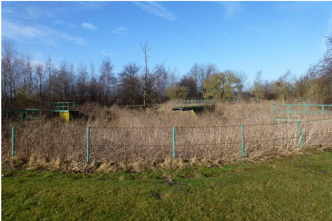
De två ursprungliga rötkamrarna vid Källby avloppsreningsverk finns bevarade men är inte i funktion.
