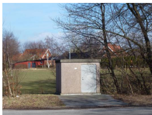
Vänster: Stora Råby, Stora Råby byaväg. Byggnad i plåt med yta av sjösten. Till höger: Stångby. Byggnad i betongelement med yta av sjösten. Flackt tälttak i betong.
