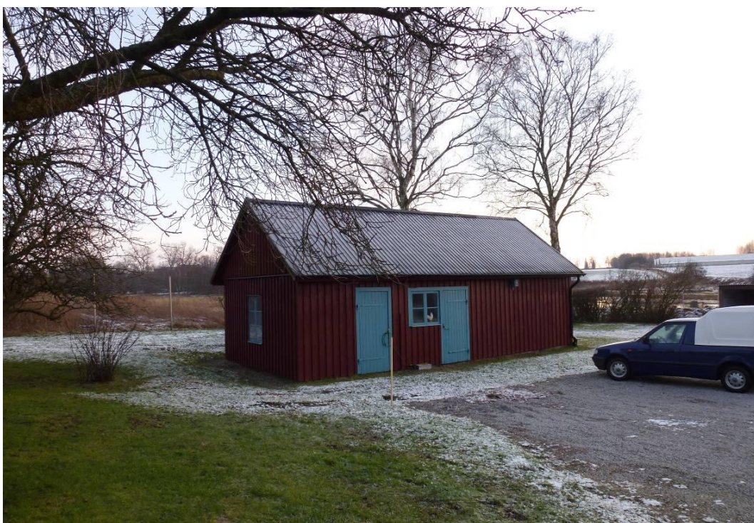
Källby vattenverk. Förrådet. Kring byggnaden finns stora träd och en del av strukturen av maskinmästarbostadens trädgård bevarad. Vy mot söder.
