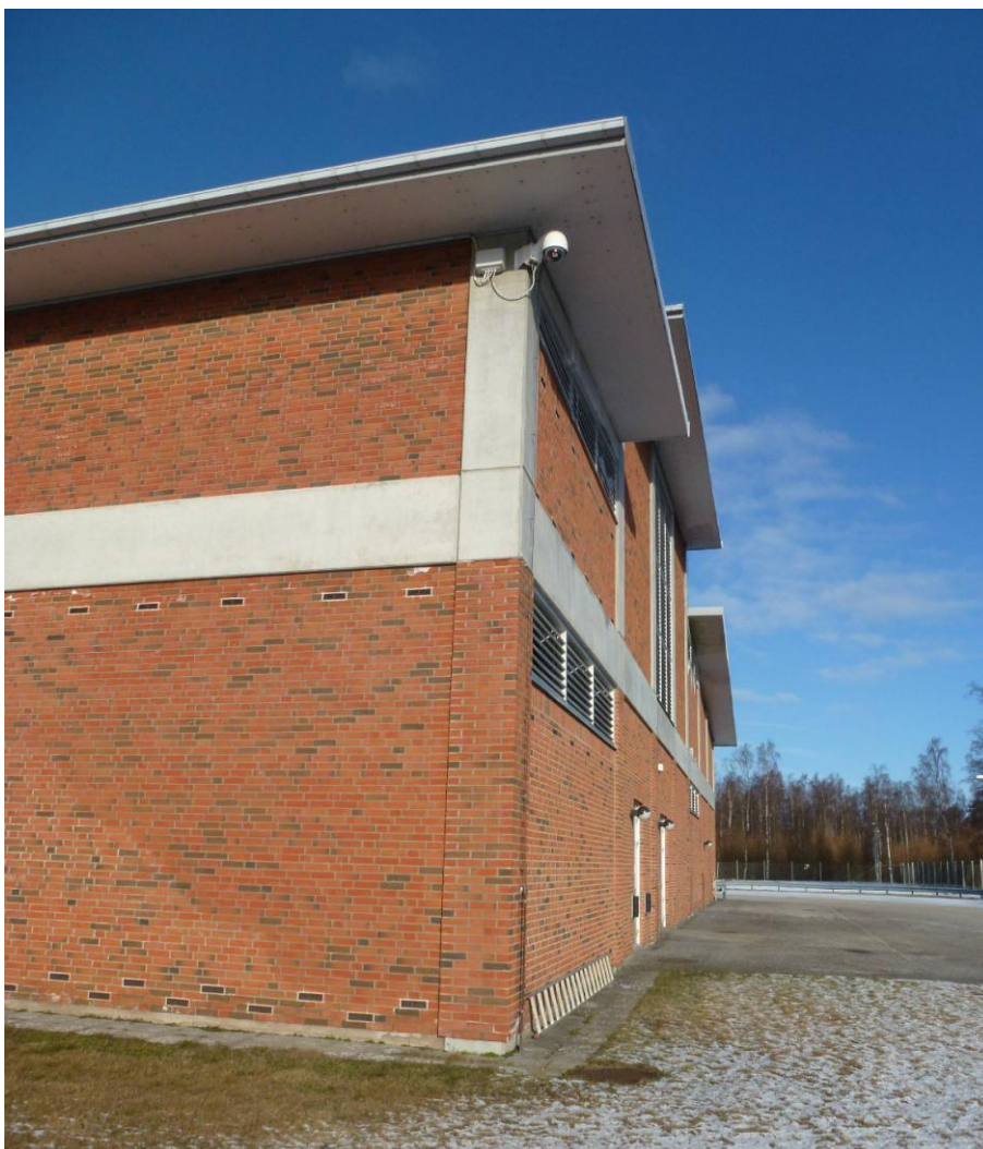
Vattenverket i Vomb. Avhärtningsanläggningen uppförd 1999 i rött fasadtegel och betong.
