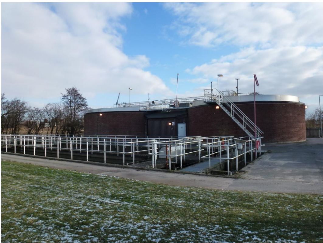
Södra Sandby reningsverk. Bioreaktor.
