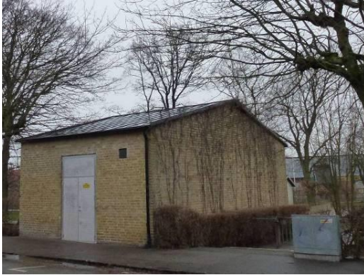
Gyllenholmsgatan/Arkivgatan. Gult tegel med plåtklätt sadeltak. På bilden syns även ett kabelskåp.
