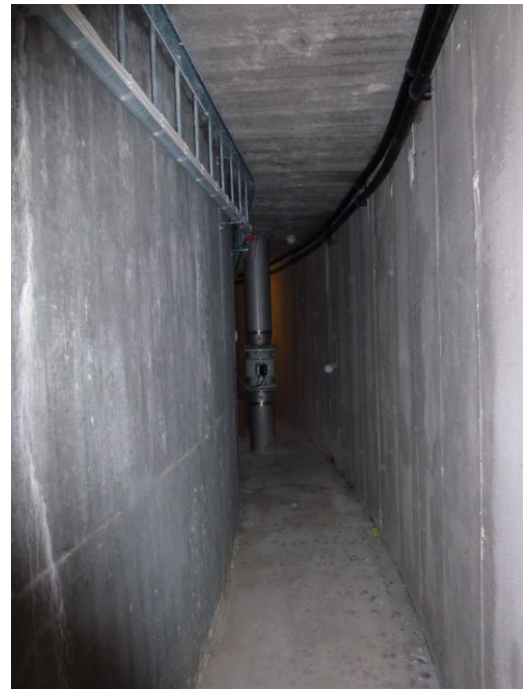
Vänster: Inspektionsgång i biobäddarna från 1960. Den högra väggen på bilden är ytterskalet i Siporexblock. Höger: trappa i den tillbyggda kontorsbyggnaden från 1960.
