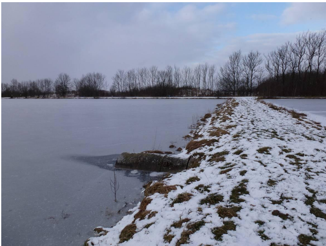
Rögle dammar. I vallarna som skiljer dammarna åt finns rör som förbinder de fem dammarna.
