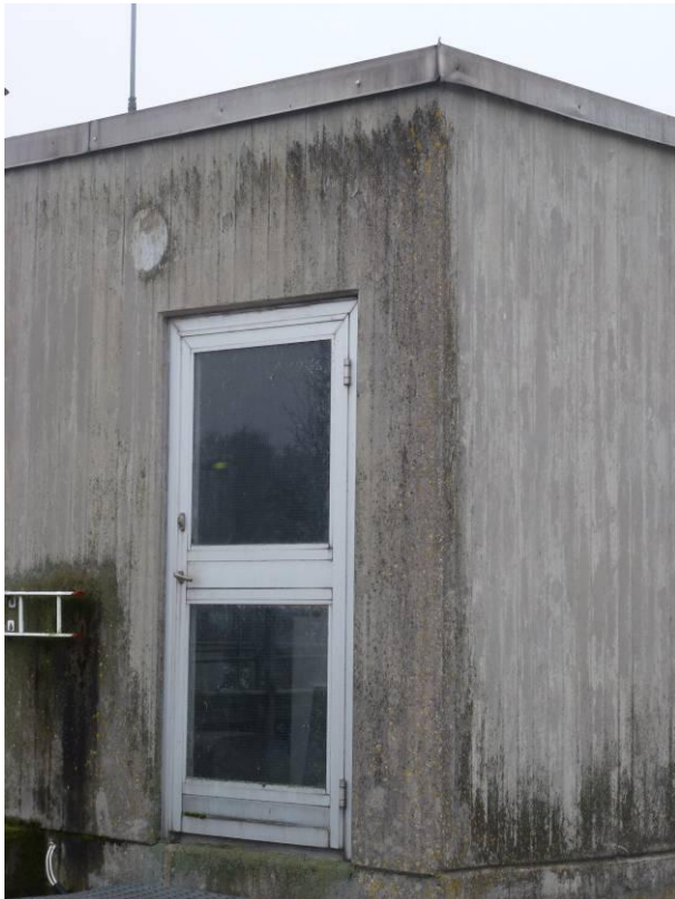
Detalj av byggnaden vid Revinge reningsverk.
