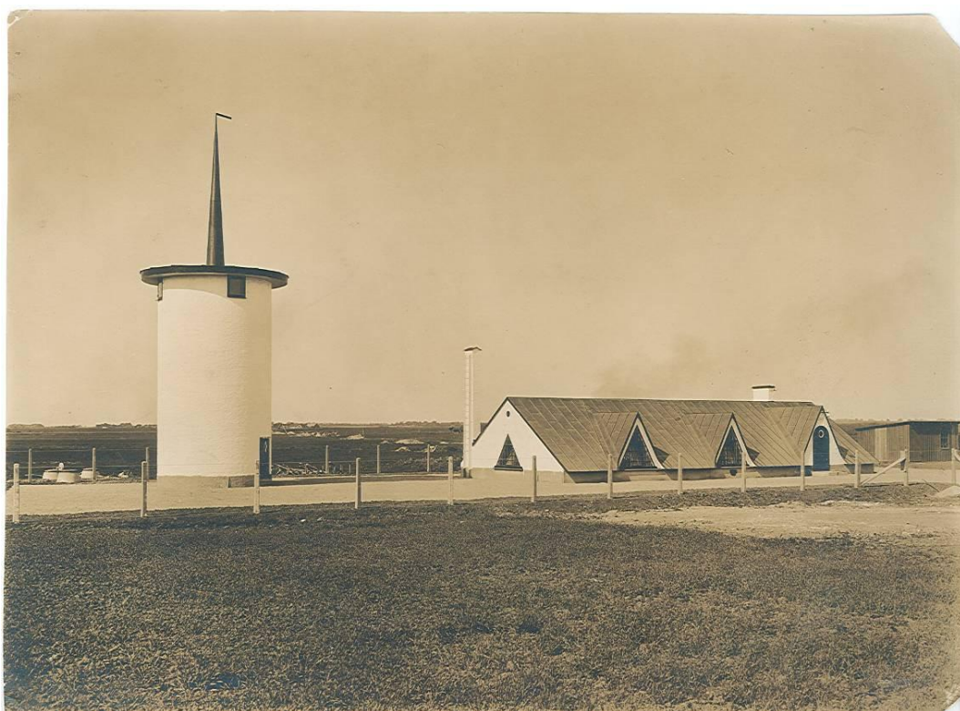
Vid Lunds stads nya vattenverk år 1922 vid Prästberga i Lomma kommun är brunnen byggd av armerad betong, från brunnen pumpas vattnet av pumpstationens elektriska pumpar genom den 4,5 km långa tryckledningen till vattenverket vid Källby. I samma rörgrav går en elektrisk kabelledning som gör att Prästbergaverket kunde skötas genom fjärrmanövrering från Källby. Ovan jord bestod anläggningen av ett litet trähus som tjänstgjort som tillfälligt pumphus men senare som redskapsbod. Man ser dels taket på pumphuset, dels överbyggnaden på samlingsbrunnen, ett lågt runt torn av vitkalkat tegel och med ett par fönster strax under det nästan platta svarta taket krönt av en mycket smal svart spira med en väderflöjel 11 . Anläggningen uppfördes enligt förslag av AB Vattenbyggnadsbyrå i Stockholm. Källa: Kulturens Arkiv. Fotograf: Per Bagge 1922.
