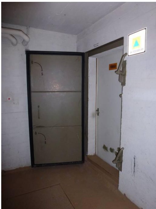
Skyddsrum från 1960-talet med den obligatoriska skylten vid ingången samt kombinerat el/handdrivet ventilationsaggregat. Tordönsvägen 4, Klostergården i Lund och byggår 1966-67
