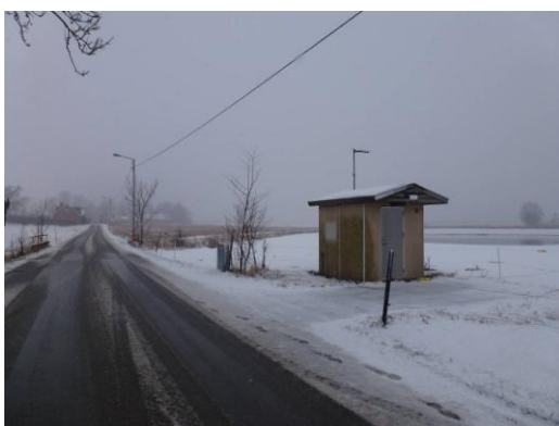
Vänster: Stora Råby, Stora Råby byaväg. Byggnad i plåt med yta av sjösten. Till höger: Stångby. Byggnad i betongelement med yta av sjösten. Flackt tälttak i betong.
