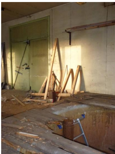
Grundvattenborran på Åldermansgatan i Lund. Interiör med gjuten brunn. Exteriör, till vänster i bild sammanbyggd med en nätstation i tegel.
