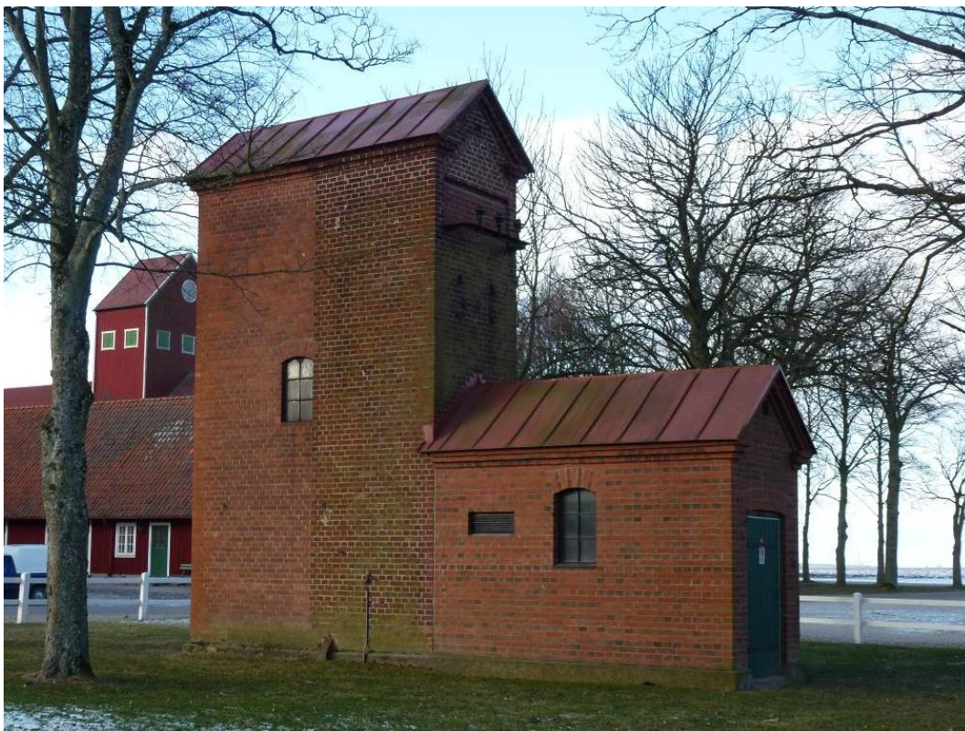
Transformatorstationen vid Svenstorps gods är ett gott exempel på varsam tillbyggnad.
