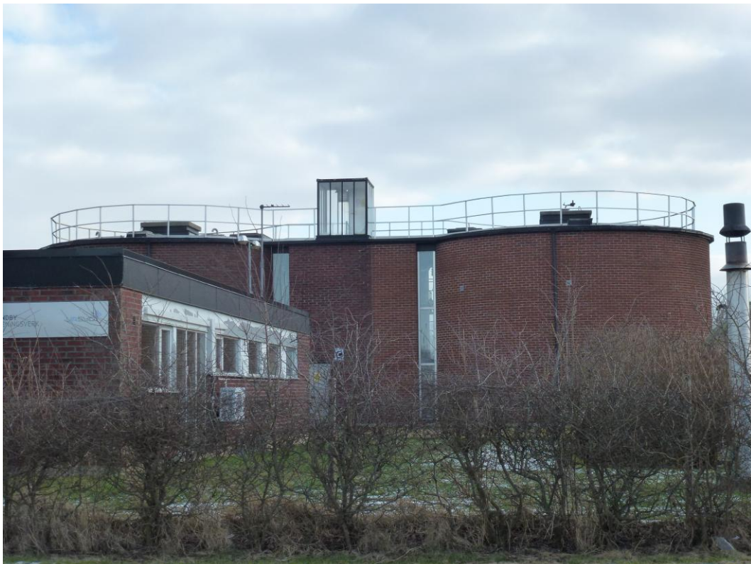
Södra Sandby reningsverk. Personalutrymmen till vänster i bild, rötkammare är en del av den första delen av anläggningen.
