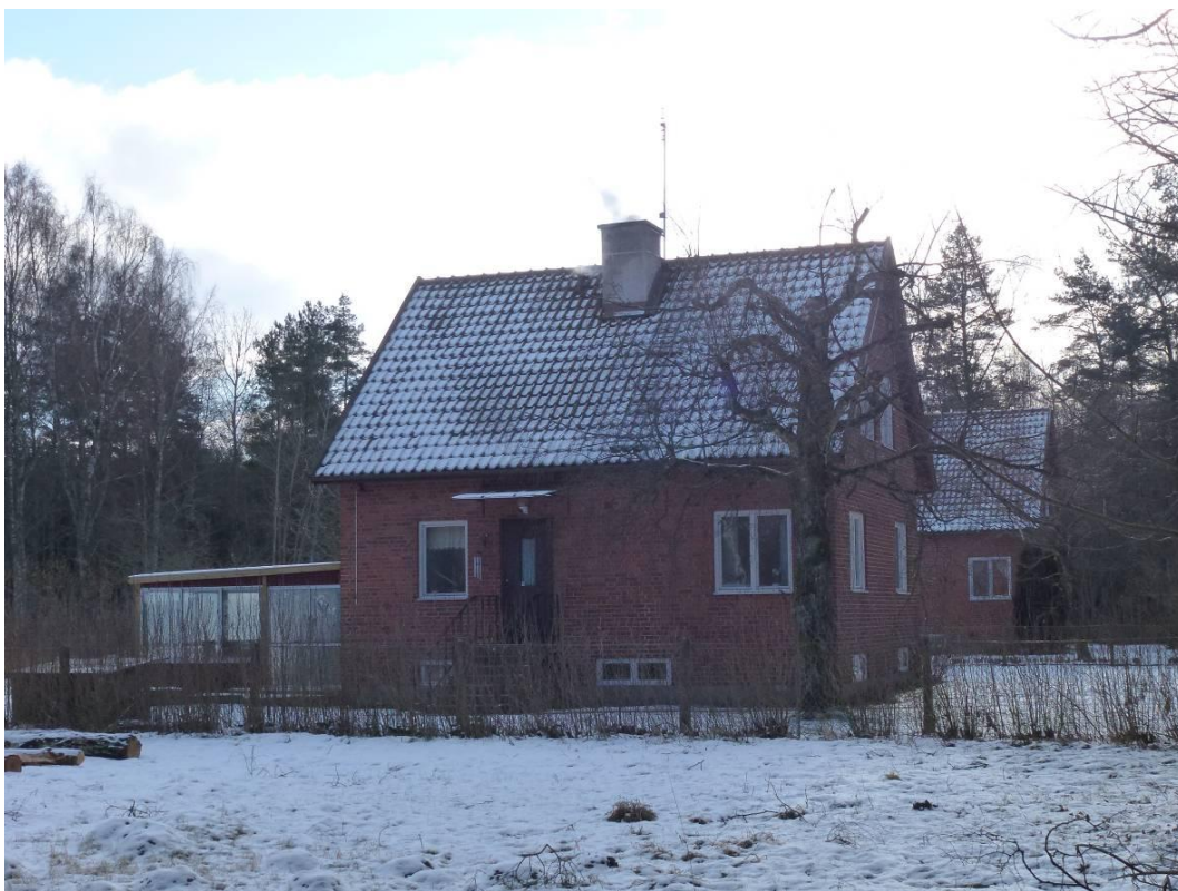
Vattenverket i Vomb. Två av maskinistbostäderna är bevarade och mycket oförändrade sedan uppförandet.
