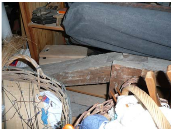
Spännbjälke i förråd på övre plan i den norra delen.
