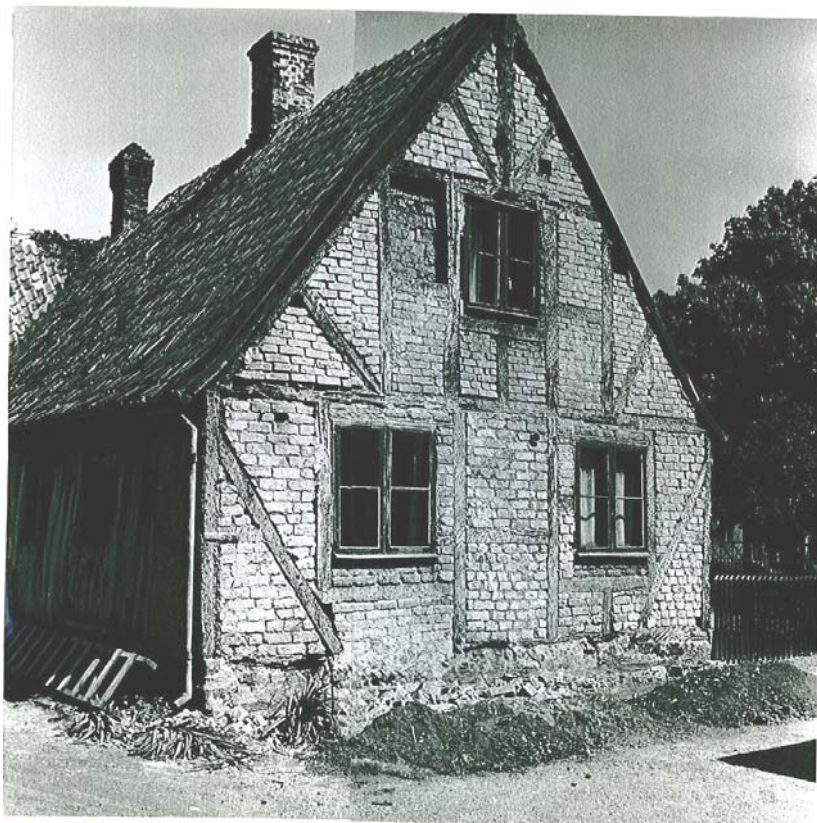
Figur 10. Södra gavelfasaden under renovering 1950. Här kan man genom teglets placering i korsvirkesfacken se att fönstren tidigare varit större. Observera skorstenarnas utformning. Källa: Arkiv Kulturen i Lund. D.229:33.
