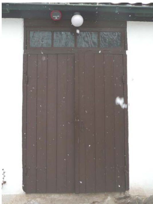
Dörr 4 med äldre karm, gångjärn och överljus.
