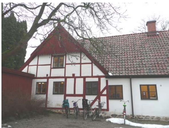
Figur 6. Västra gavelfasaden med bred locklistpanel i gavelröset.
