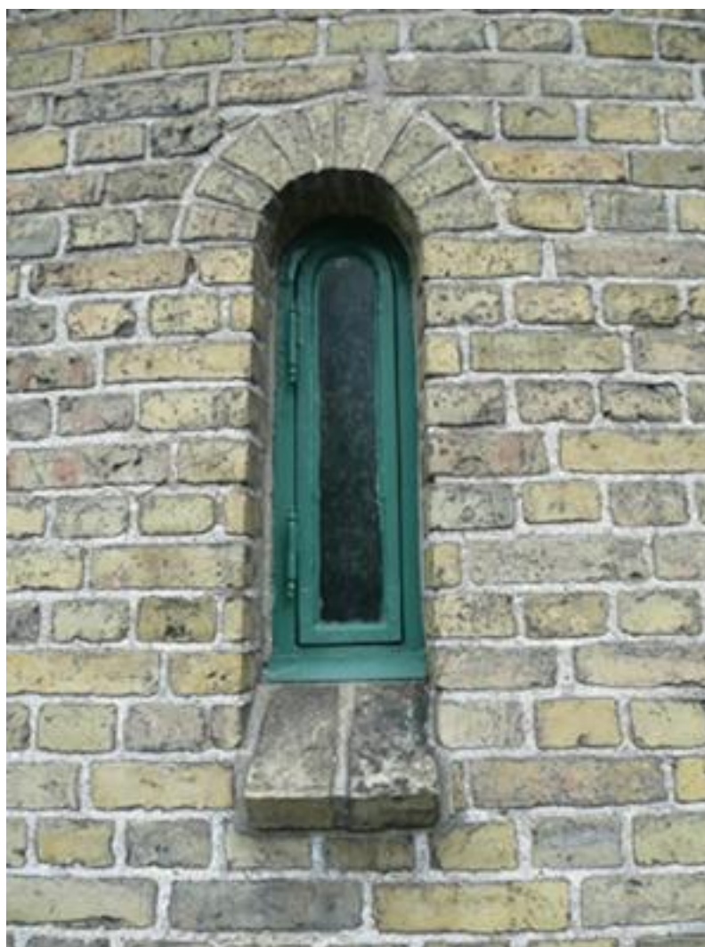
Fönster i observatoriebyggnaden med äldre gångjärn
