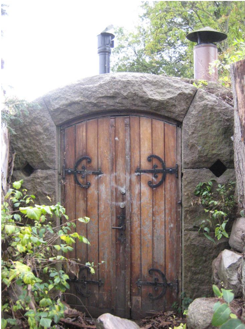
Seismografhuset gaveln, ornerad dörr och takventiler
