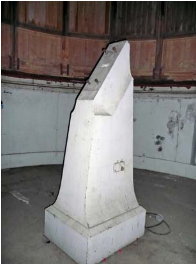
Fundament till stjärnkikare i kupolen
