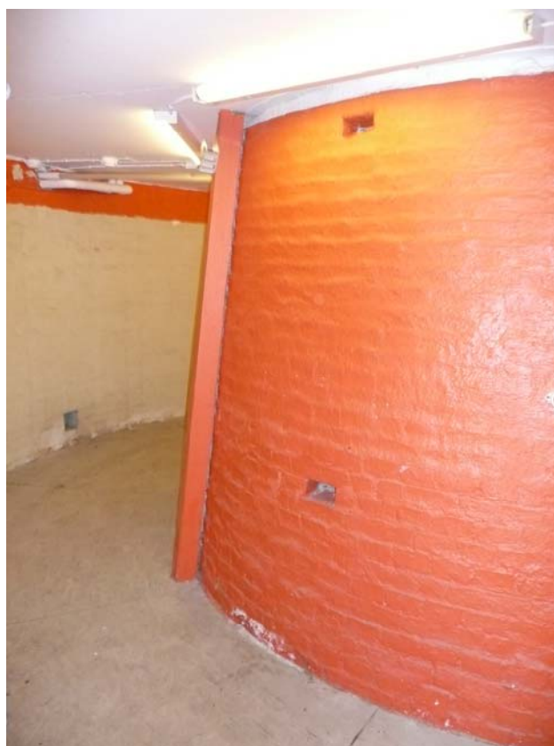
Den massiva murpelaren löper genom alla våningsplan i tornet, med tydlig konisk form i källaren.
