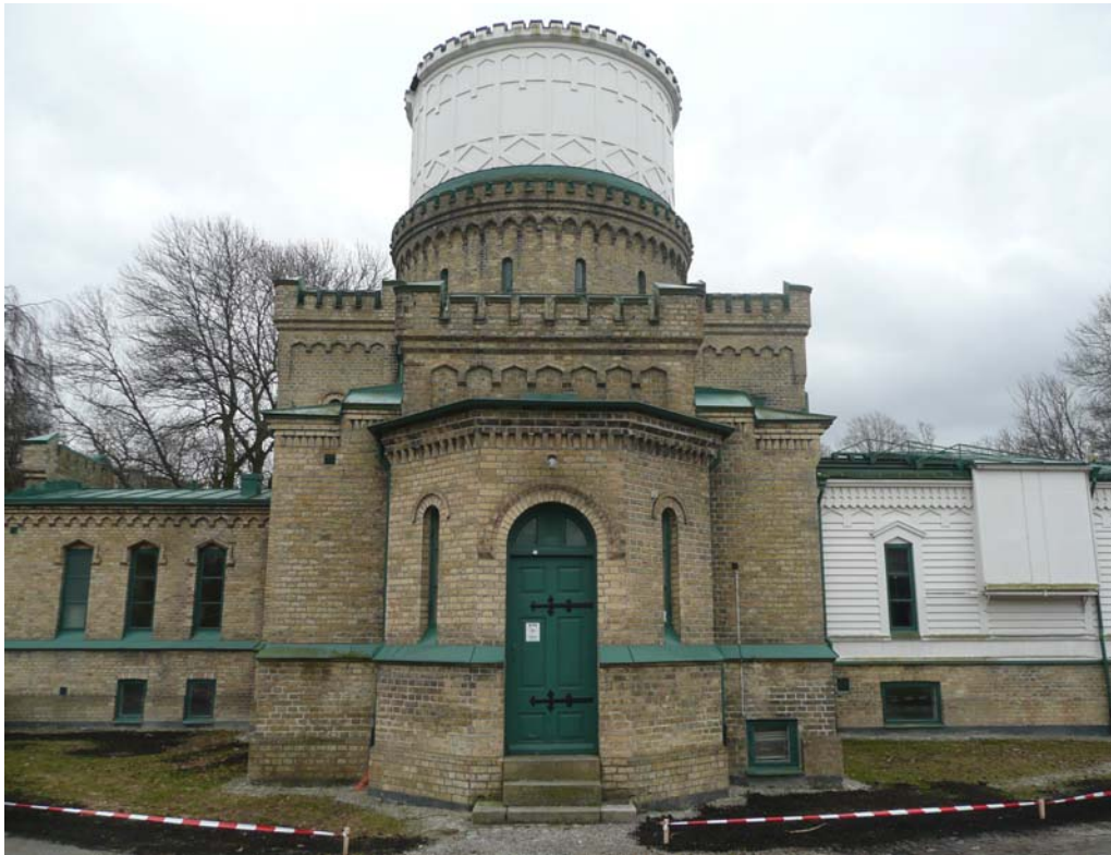
Observatoriet från norr med invändigt igensatt dörr.
