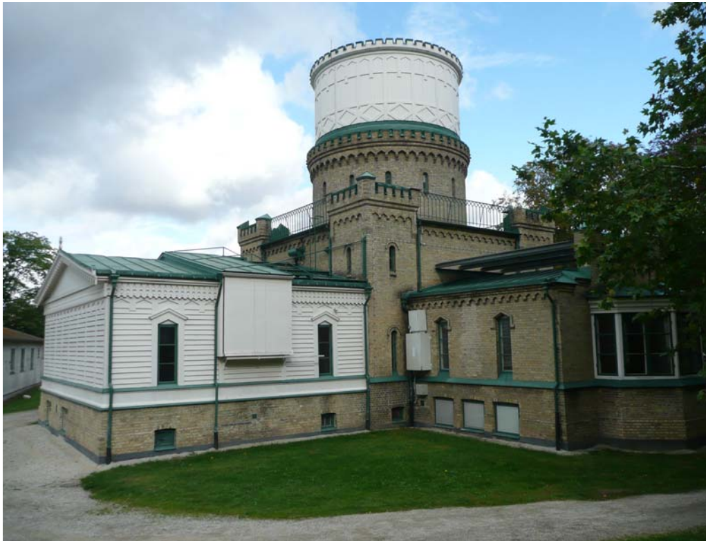
Från sydväst, notera igensatt spaltöppning i södra flygeln och plattformen i durkplåt på taket.
