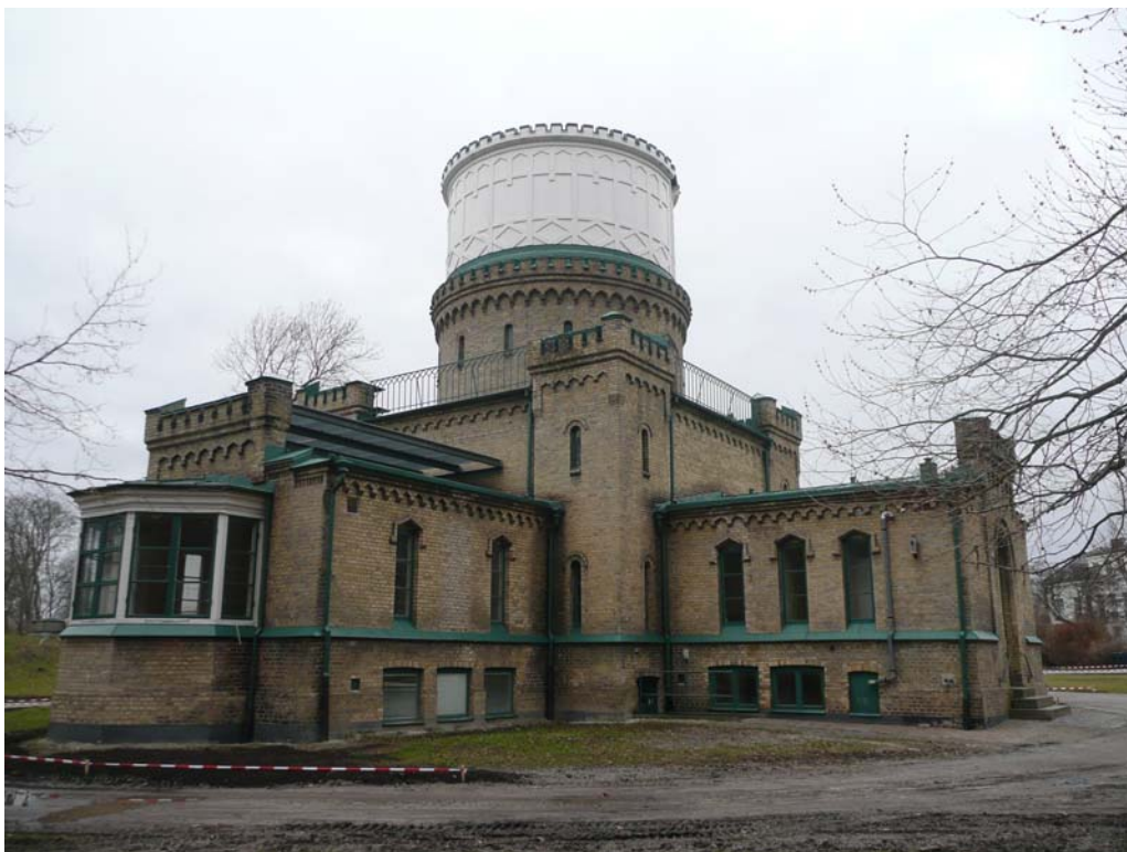
Från sydöst, förstörade källarfönster senare källarentré och det vänstra fönstret i östra flygeln har ersatt en lucka.
