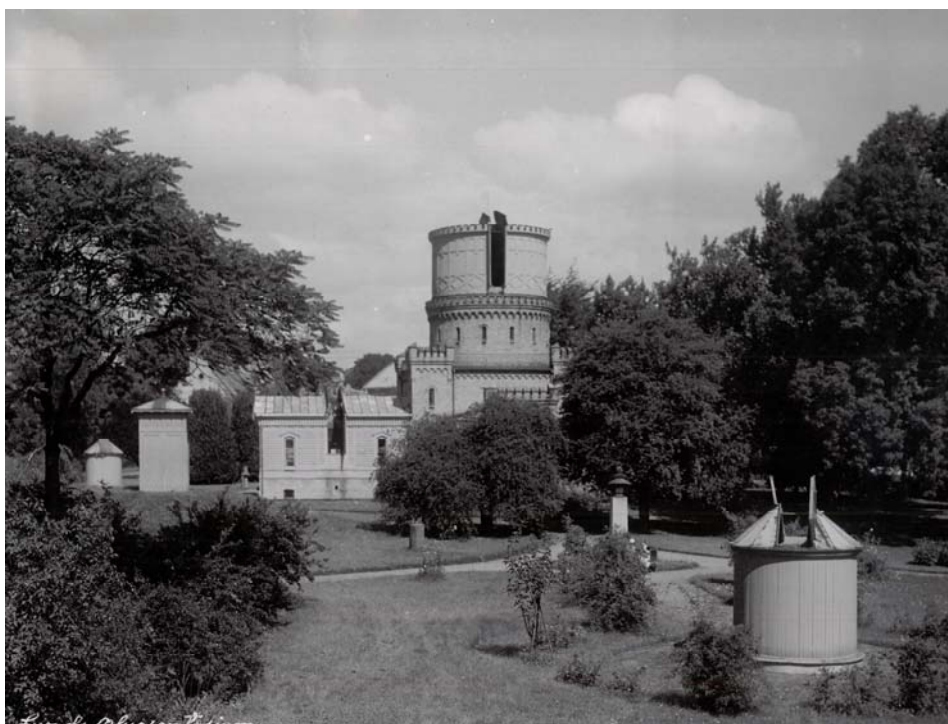
Fotot visar uppslagna spaltöppningar i kupol och västflygeln innan ombyggnad.
