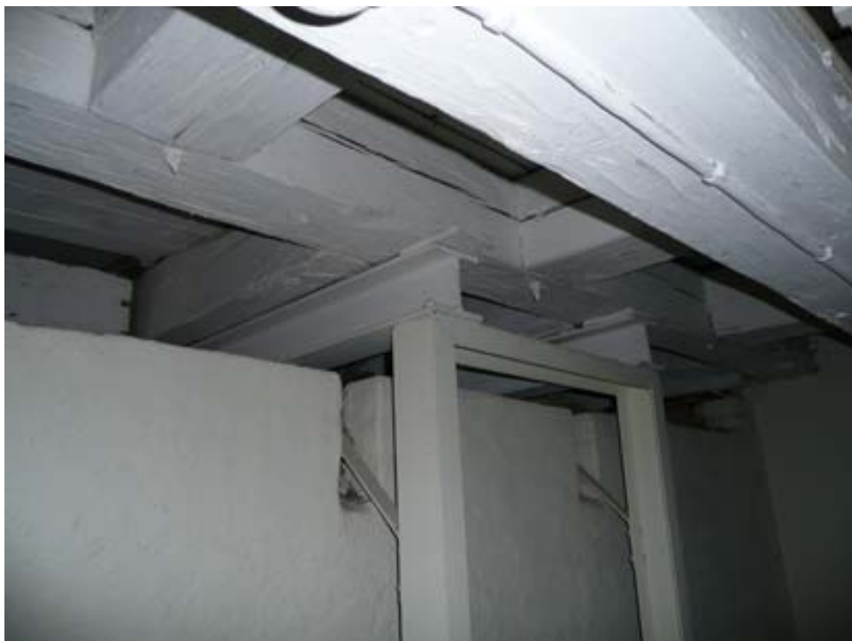
Bjälklaget till plan 1 har en stomme av bilat grov timmer, på bilden ses även fundament till instrument i plan 1.
