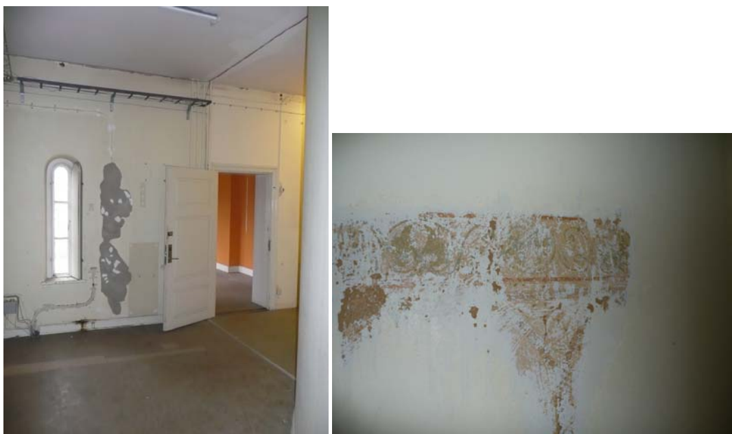
Rum 107 mörkläggningslucka vid fönster och äldre schablonmåleri på cylindern.
