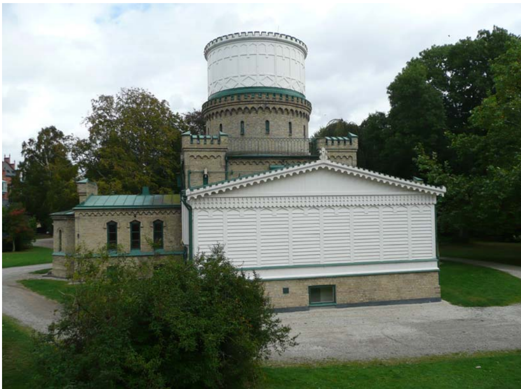
Från väster, i en tillbyggd farstu vid denna gavel kan eventuell ny tillgänglig entré placeras .
