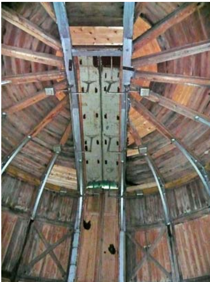
Spaltöppning i tak och vägg på kupol
