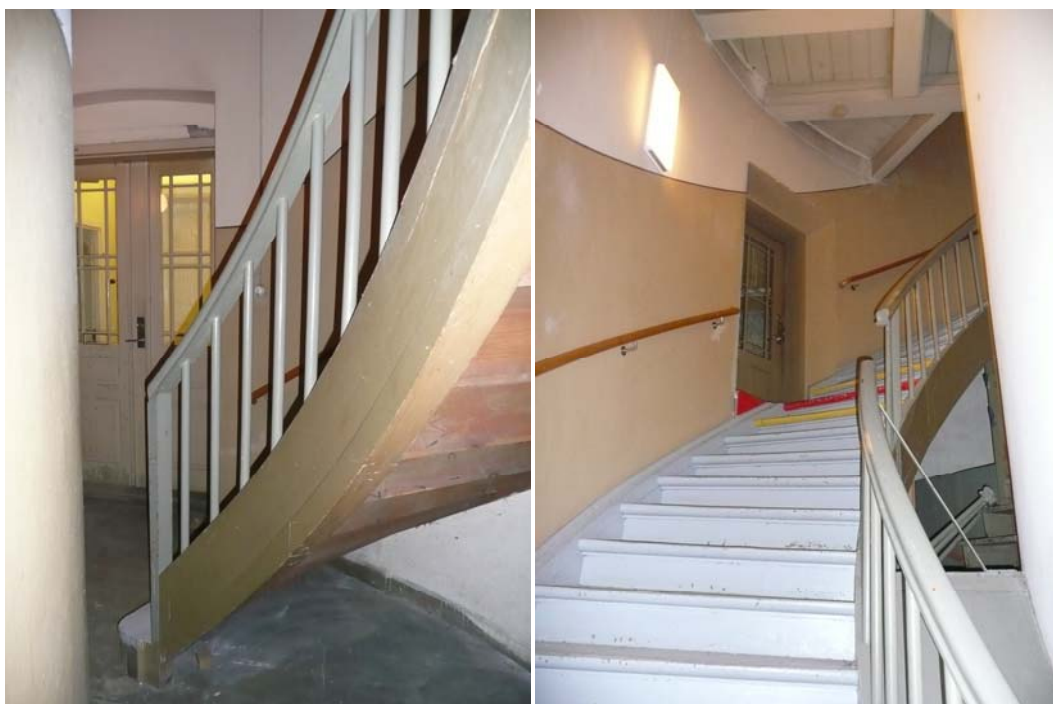
T v rum 115 trapphus med svängd trappa och träbjälklag.
