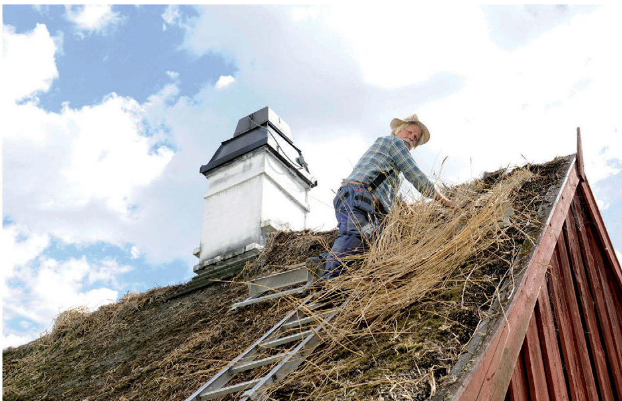
Det pågick mycket arbete med att restaurera byggnader och parkmiljöer på fri-luftsmuseet under 2012. Ett arbete som till stor del gjordes öppet och inför publik.
